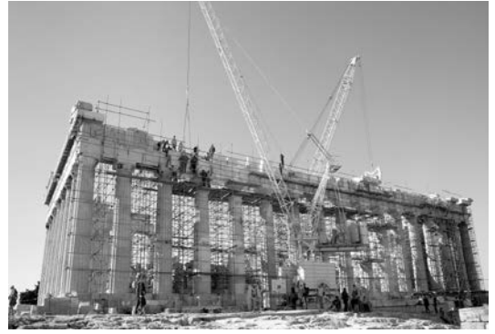
Η βόρεια πλευρά του Παρθενώνα στη διάρκεια των εργασιών αποκατάστασης. Άποψη από βόρεια (2009).
