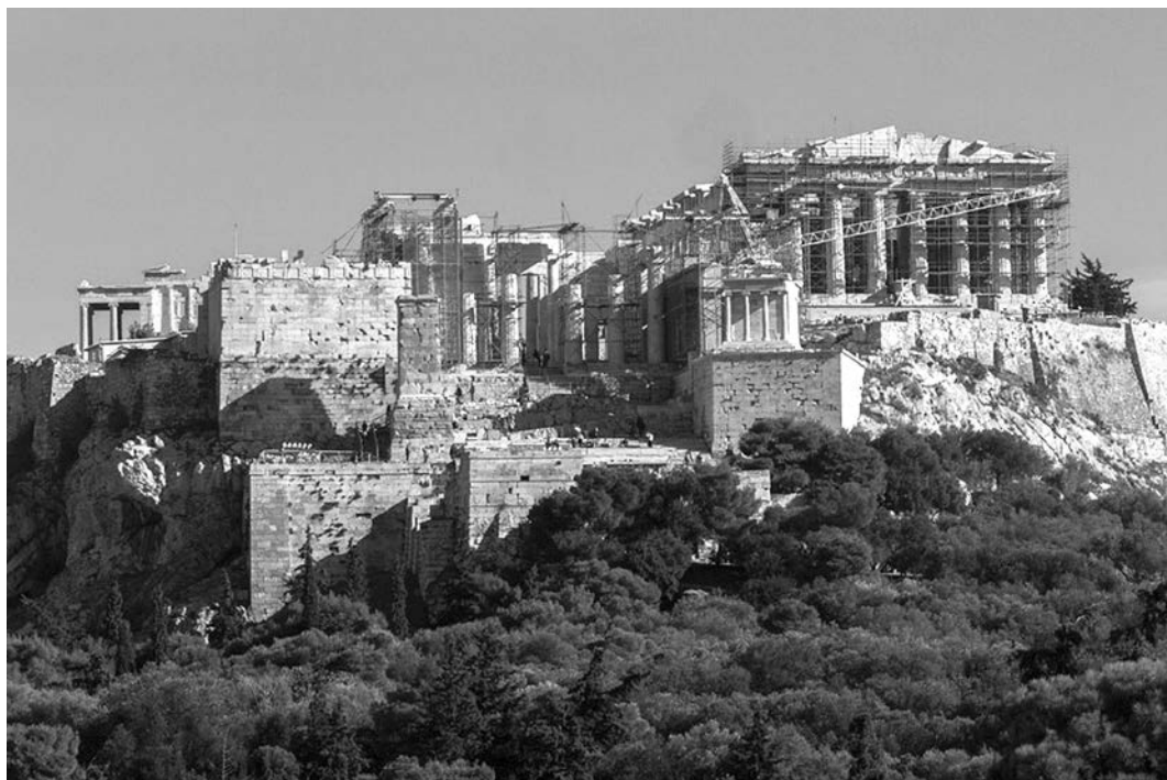
Άποψη της Ακρόπολης από την Πνύκα στη διάρκεια των έργων αναστήλωσης του προγράμματος 2011-2015 (2015).
