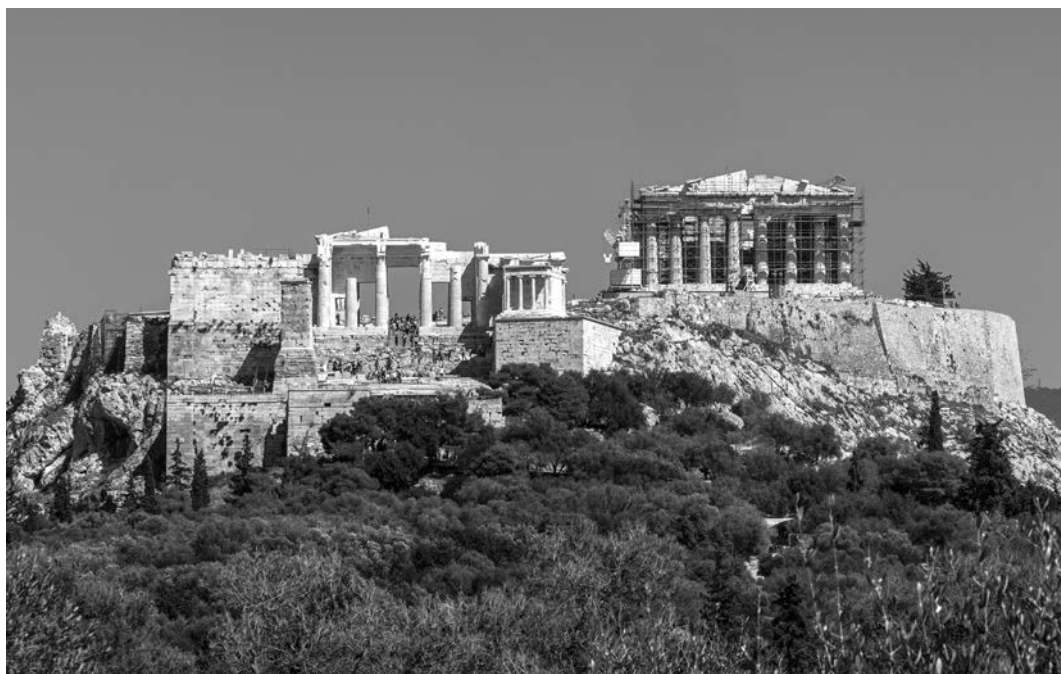
Άποψη της Ακρόπολης από την Πνύκα κατά την έναρξη των έργων αναστήλωσης του προγράμματος 2016-2020 (2016).
