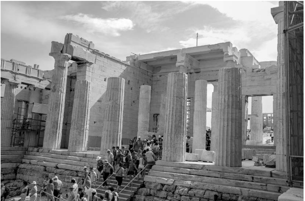
Η περιοχή της βορειοδυτικής γωνίας και της δυτικής πρόσοψης του κεντρικού κτηρίου των Προπυλαίων πριν από την επέμβαση αποκατάστασης. Αποψη από νοτιοδυτικά (2014).
