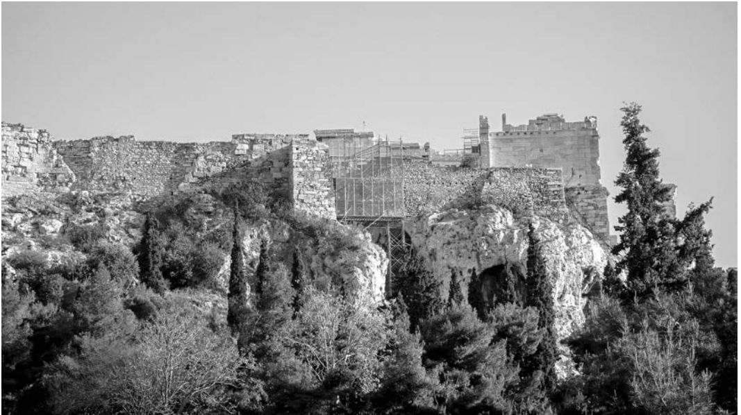
Άποψη του βόρειου τείχους της Ακρόπολης από νότια: περιοχή Β17. Διακρίνονται τα ικρίσματα στη θέση επέμβασης (2016).
