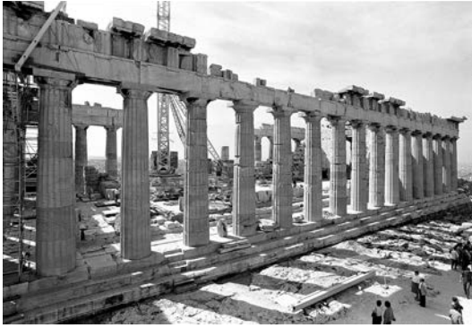
Η βόρεια πλευρά του Παρθενώνα πριν από την έναρξη των εργασιών αποκατάστασης. Άποψη από βορειοανατολικά (1986).
