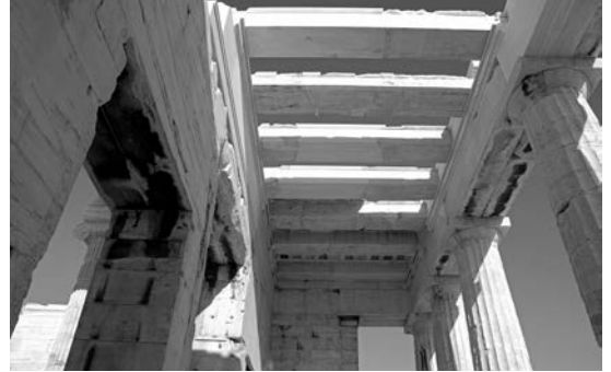
Η οροφή της ανατολικής στοάς μετά την αποκατάστασή της. Άποψη από νότια (2009).
