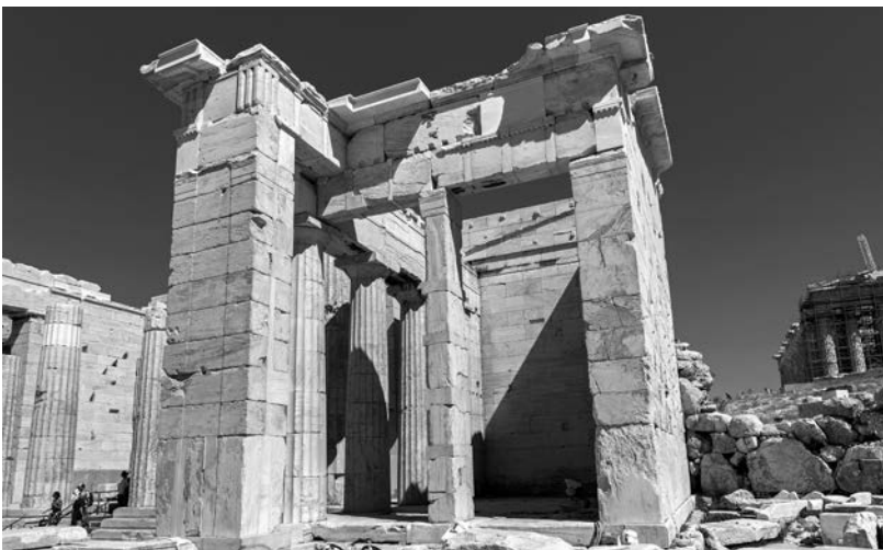
Η νότια πτέρυγα των Προπυλαίων από νοτιοδυτικά (2018).
