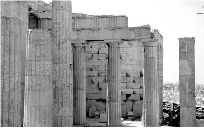
Η νότια πτέρυγα των Προπυλαίων πριν την αποκατάστασή της. Αποψη από βορρά (2010).
