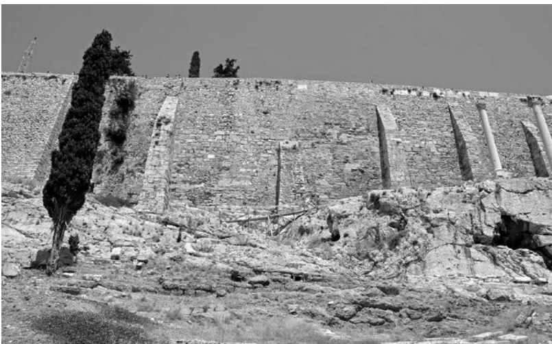
Η περιοχή μεταξύ έκτης και έβδομης αντηρίδας από νότια μετά την επέμβαση (2015).
