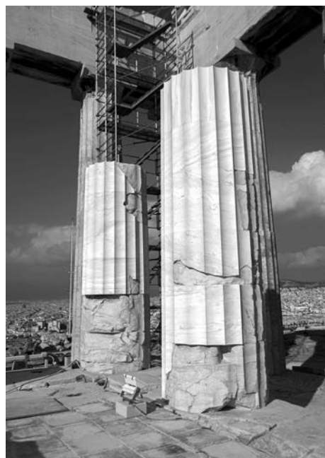
Οι δύο βορειότεροι κίονες του προνάου του Παρθενώνα μετά την ολοκλήρωση της κατάξεσης των ραβδώσεων. Άποψη από νοτιοδυτικά (2016).
