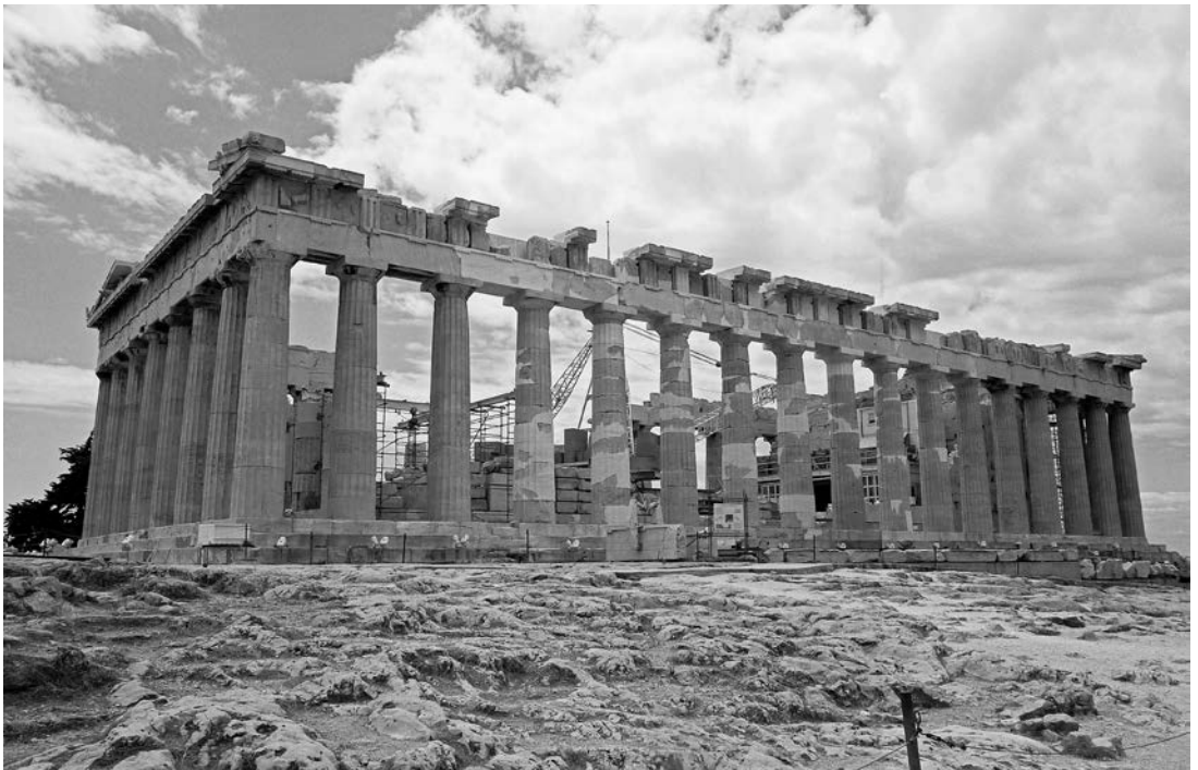
Η βόρεια πλευρά του Παρθενώνα μετά την αποκατάστασή της. Άποψη από βορειοανατολικά (2010).
