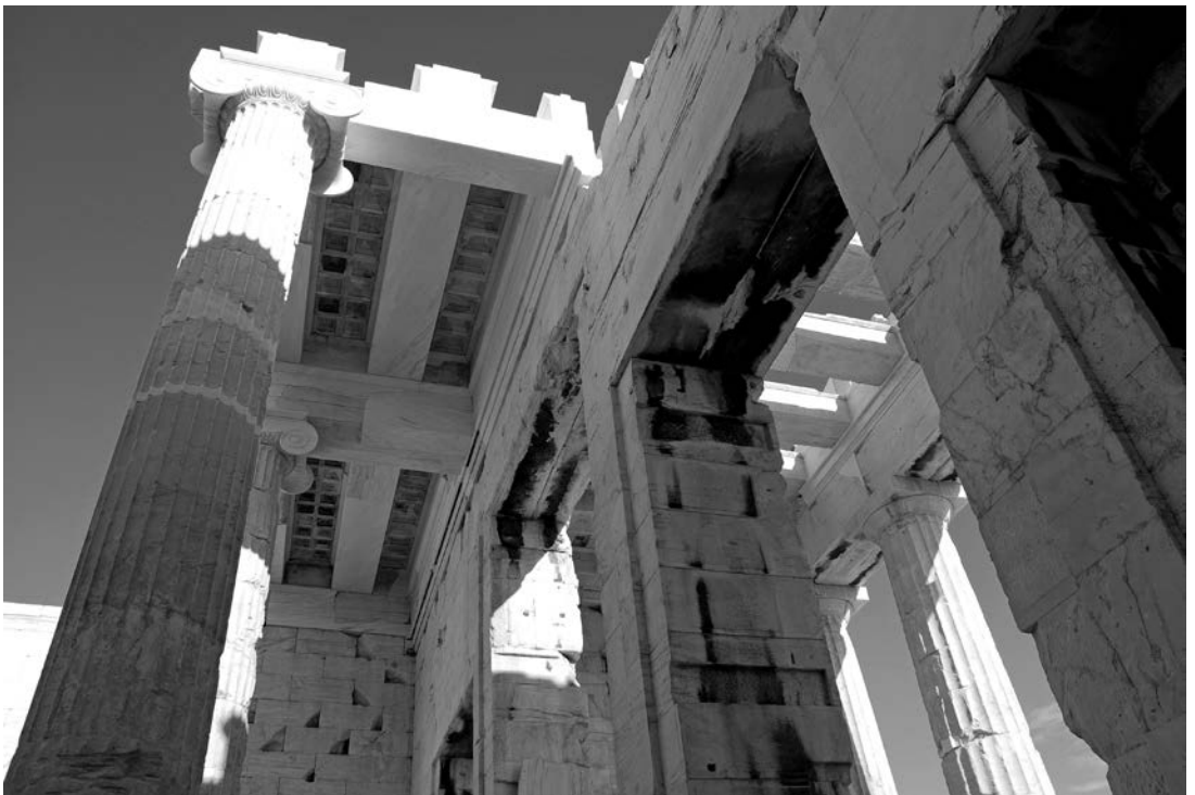
Οι αποκατεστημένες οροφές της κεντρικής αίθουσας και της ανατολικής πρόστασης των Προπυλαίων από νότια (2009).
