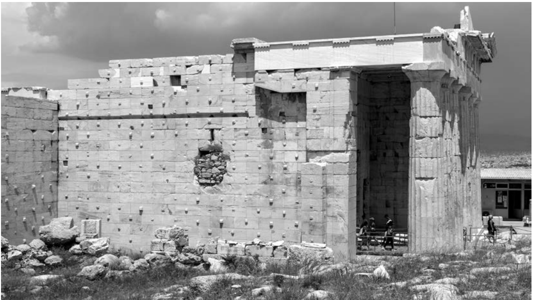
Ο νότιος τοίχος του κεντρικού κτηρίου Προπυλαίων μετά από την αποκατάστασή του. Αποψη από νότια (2018).
