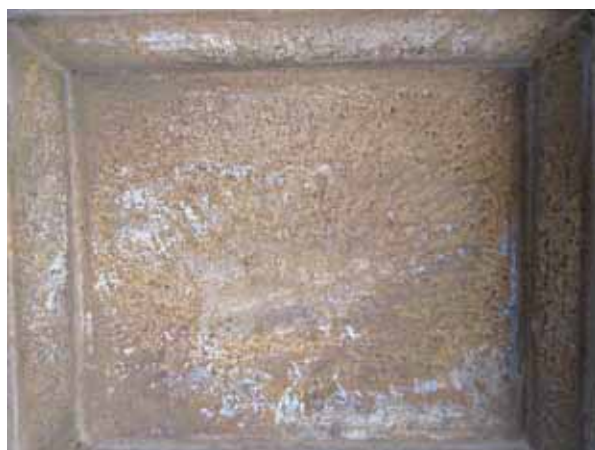
Εικ. 5. Υπόλευκο και πορτοκαλόχρωμο επίχρισμα σε ουρανίσκο φατνώματος.
