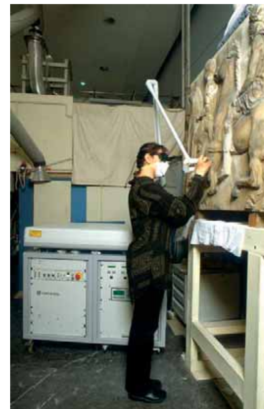
Εικ. 8. Δυτική Ζωφόρος λίθος IV. Κατά τον καθαρισμό με το σύστημα λέιζερ (φωτ. Τ. Σουβλάκης, Αρχείο Υ.Σ.Μ.Α).
