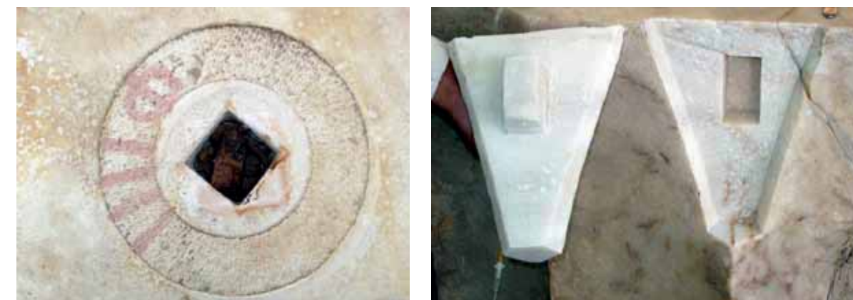
Εικ. 12. α: κλασική οικοδομική επιγραφή στην άνω επιφάνεια του τέταρτου σπονδύλου του τέταρτου από βορρά κίονα της ανατολικής στοάς. β: αρχαίο μαρμάρينو συμπλήρωμα για την επιδιόρθωση ζημίας σε ακμή ραβδώσεων δωρικού κίονα.
