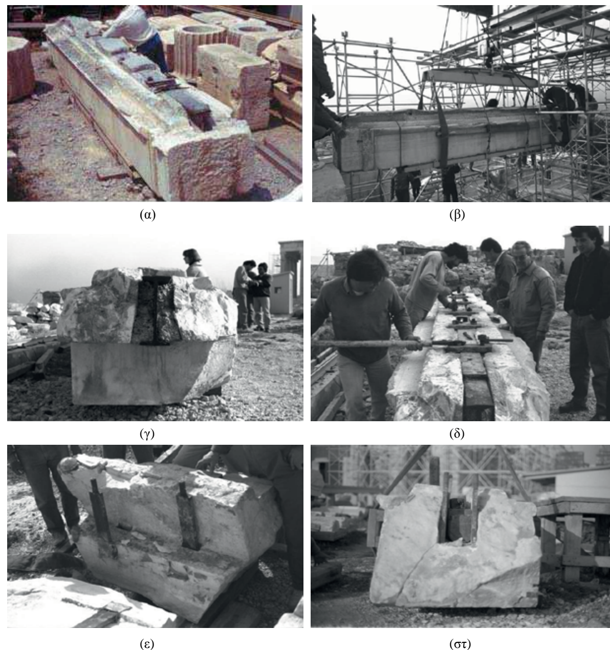
Εικ.15. Απομάκρυνση και αποσυναρμολόγηση των δοκών των Προπυλαίων: (α) Αποξήλωση δοκού από την οροφή της Ανατολικής Στοάς. (β) Το σύστημα σύνδεσης των θραυσμάτων των δοκών κατά την αναστήλωση Μπαλάνου. (γ) Η ένθετη σιδηροδοκός σε αύλακα της αρχαίας δοκού. (δ) Απομάκρυνση του συστήματος σιδηροδοκού - αναρτήρων μετά την αποσυναρμολόγηση. (ε, στ) Διάρρηξη θραυσμάτων δοκών από την οξείδωση των σιδερένιων αναρτήρων (Φωτ. Μ. Ιωαννίδου, Τ. Τανούλας).
