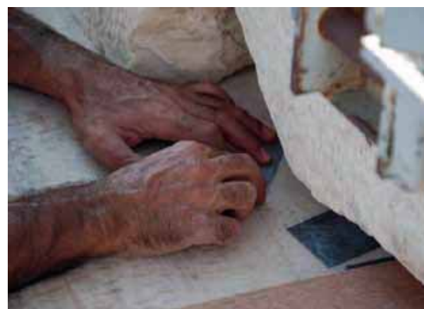
Εικ. 14. Η τοποθέτηση φύλλων μολύβδου κρίθηκε απαραίτητη στην ανατοποθέτηση των λίθων της ανωδομής του νότιου τοίχου (2011) (Αρχείο Υ.Σ.Μ.Α.).
