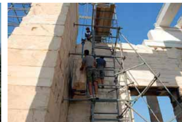
Εικ. 18. Αποψη της ΝΔ γωνίας της Ανατολικής Στοάς απ' όπου έγινε η αναβίβαση των μελών στον νότιο τοίχο (2011) (Αρχείο Υ.Σ.Μ.Α.).
