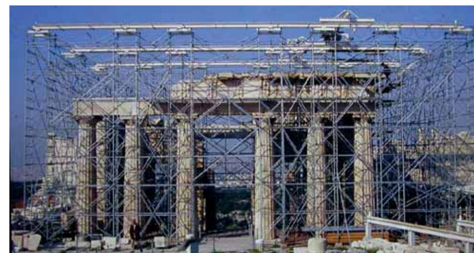
Εικ. 3. Το σύστημα ικριωμάτων - γερανογεφυρών της αναστηλωτικής επέμβασης στα Προπύλαια (Φωτ. Τ. Τανούλας).
