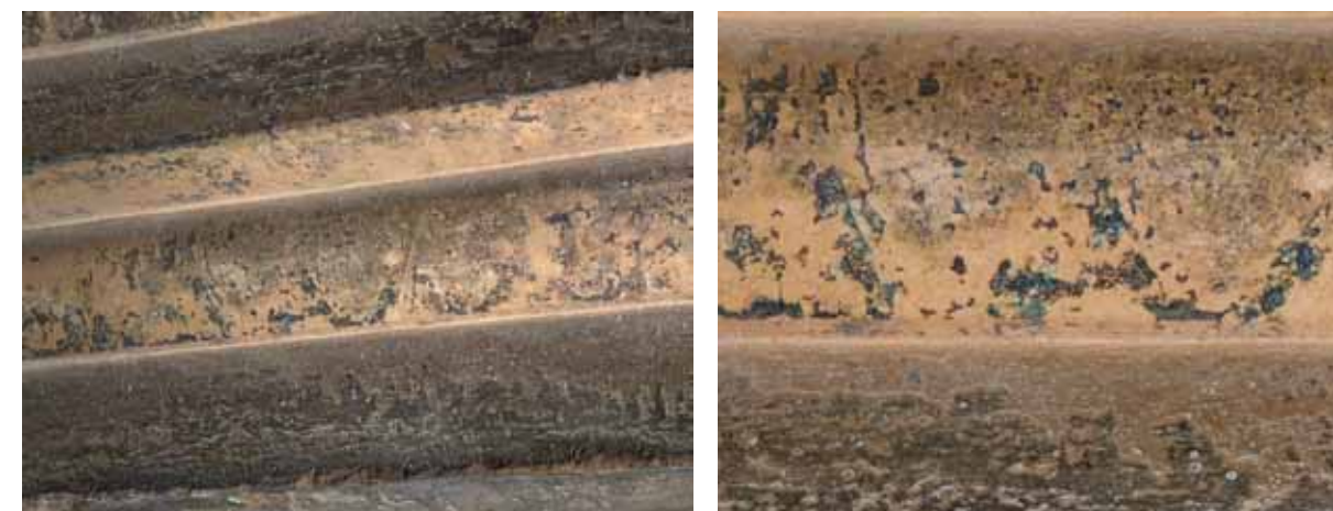
Εικ. 3. Ίχνη περιγραμμάτων από «ωά ιωνικού κυματίου», σε κυμάτιο φατνώματος της 1 ης στρώμα φατνωματικής πλάκας. Εικ. 4. Ίχνη κυανού χρώματος πάνω στο μαύρο στρώμα.
