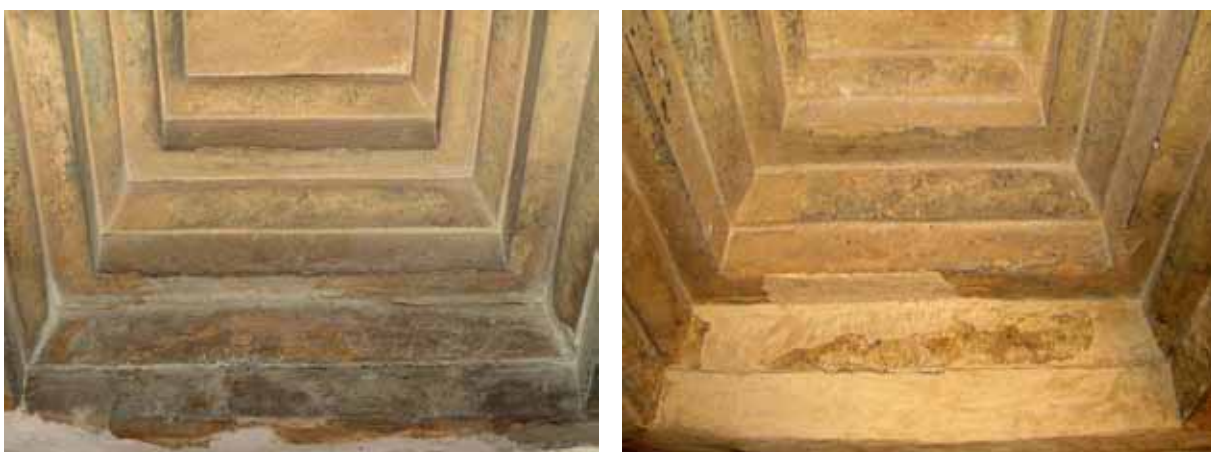
Εικ. 13. Φάτνωμα με συμπληρώσεις και τα 2 επιχρίσματα (υπόλευκο και πορτοκαλόχρωμο). Πριν από τις επεμβάσεις, είναι καλυμμένα με επικαθίσεις. Εικ. 14. Μετά τις επεμβάσεις καθαρισμού και αισθητικής αποκατάστασης η περιοχή είναι ενανάνγνωστη.
