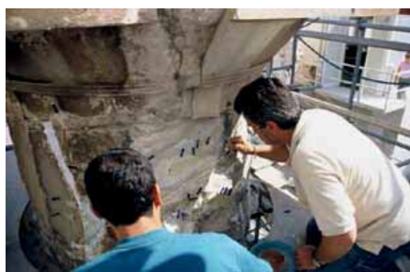
Εικ. 2. Παρθενόνας. Οπισθόναος. Επεμβάσεις συντήρησης σε σπόνδυλο του κίονα 4. Εφαρμογή ενεμάτων δομικής απόκατάστασης.
