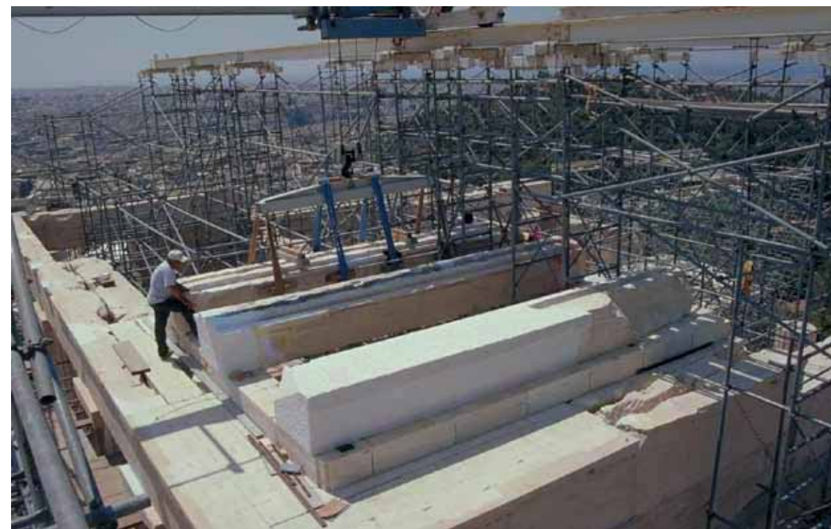
Εικ. 21. Ανατοποθέτηση δοκών στην οροφή της Ανατολικής Στοάς των Προπυλαίων.
