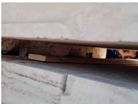
Εικ. 13. Κατά τις εργασίες ανατοποθέτησης των λίθων της ανωδομής του νότιου τοίχου (2011) (Αρχείο Υ.Σ.Μ.Α.).
