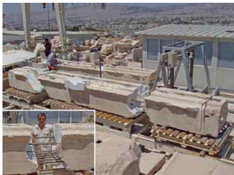
Εικ. 14. Συγκόλληση θραυσμάτων δοκού οροφής της ανατολικής στοάς με ράβδους τιτανίου και τσιμέντο. Γενική απόψη και λεπτομέρεια.
