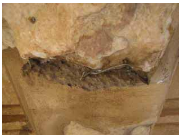
Εικ. 19. Αποκάλυψη οπλισμού συμπληρωμάτων.
