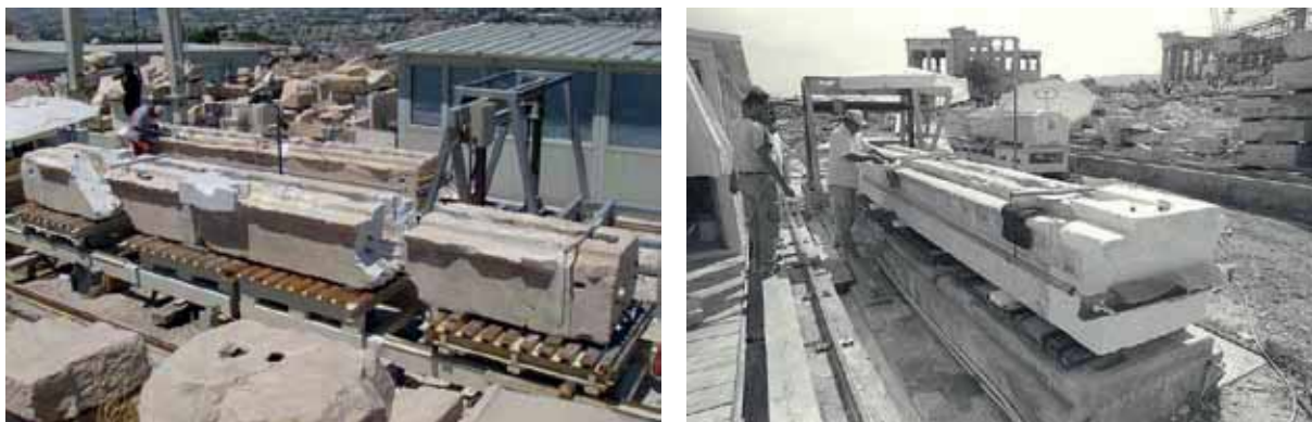
Εικ. 18. Συγκόλληση δοκού Προπυλαίων (Φωτ. Τ. Τανούλας). Εικ. 19. Περίδεση συγκολλημένης δοκού με ιμάντες τάνυσης μετά την συγκόλληση (Φωτ. Τ. Τανούλας).
