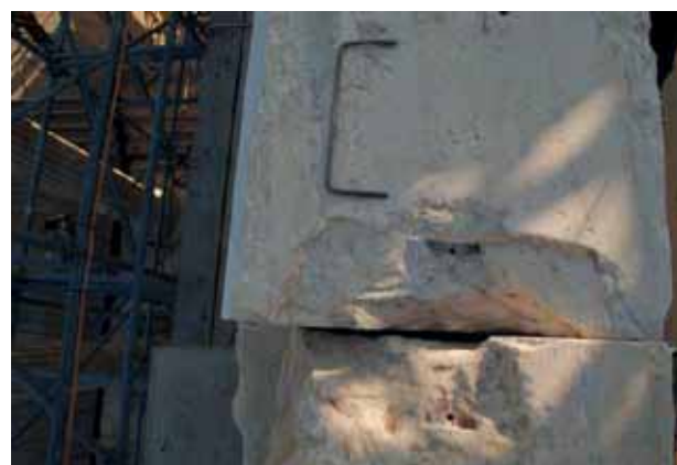
Εικ. 16. Οι νέοι σύνδεσμοι τιτανίου μορφής Π που τοποθετήθηκαν μεταξύ των λίθων του δόμου 20 (2011) (αρχείο Υ.Σ.Μ.Α.).
