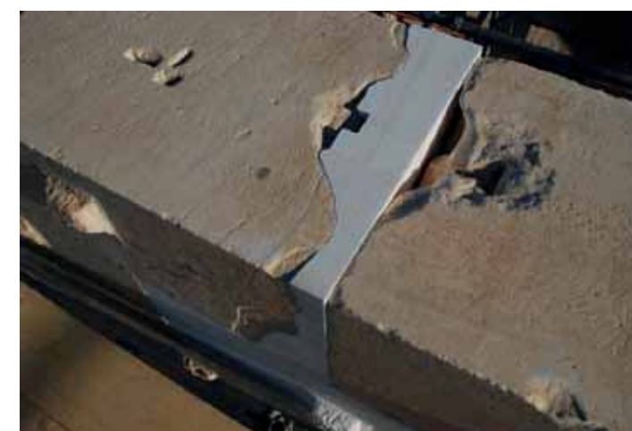
Εικ. 6. Άποψη από άνω των λίθων του δόμου 19 κατά τις εργασίες ανατοποθέτησης (2011) (Αρχείο Υ.Σ.Μ.Α.).
