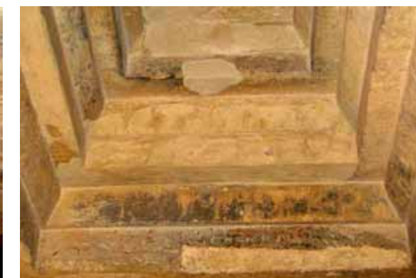
Εικ. 12. Μετά τις επεμβάσεις καθαρισμού και αισθητικής αποκατάστασης έγιναν αντιληπτά τα όρια των συμπληρώσεων καθώς και του μαύρου στρώματος και των επιχρισμάτων.
