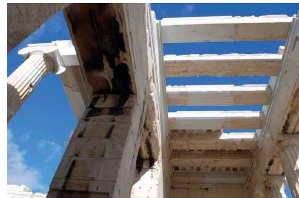
Εικ. 22. Η οροφή της ανατολικής στοάς με τις αναστηλωμένες δοκούς (Φωτ. Τ. Τανούλας).
