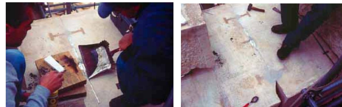
Εικ. 15. Μολυβδοχόηση σε αρμό που έμεινε αναγκαστικά χαίλων στον θυραίο τοίχο. Αμμος και τσιμέντο εξασφαλίζουν την μόνωση του τιτανίου από το μολύβι.
