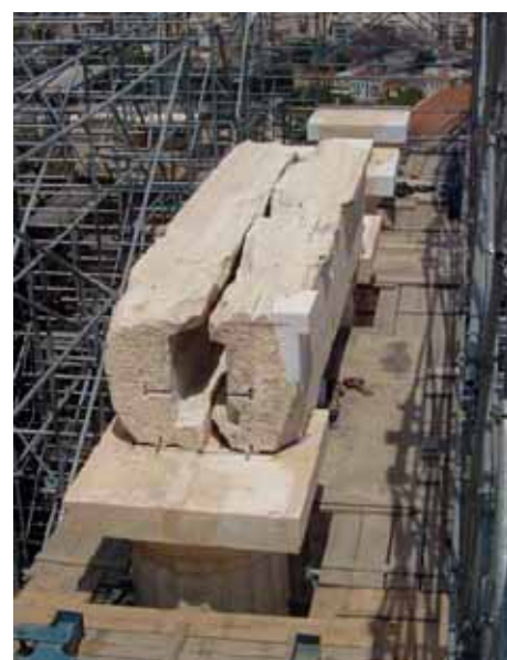
Εικ. 10β. Οι δύο λίθοι του κεντρικού επιστυλίου μετά την ανατοποθέτησή τους στο μνημείο (Φωτ. Β. Πασχαλίδης).
