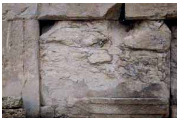
Εικ. 5. Προπύλαια. Στοά βόρειας πτέρυγας. Ορθοστάτης δυτικού τοίχου. Πριν τις επεμβάσεις συντήρησης.
