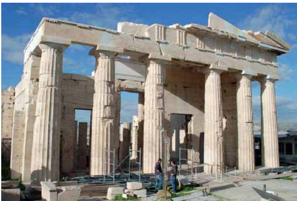
Εικ. 1. Η ανατολική πλευρά των Προπυλαίων μετά την αποκατάσταση (Φωτ. Τ. Τανούλας).
