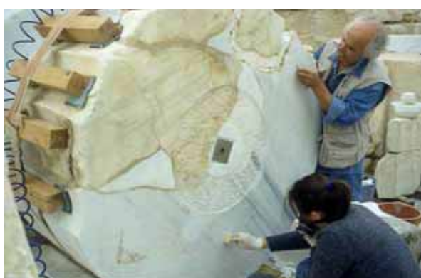
Εικ. 1. Παρθενόνας. Βόρεια πλευρά. Επεμβάσεις συντήρησης σε έδρα σπονδύλου.
