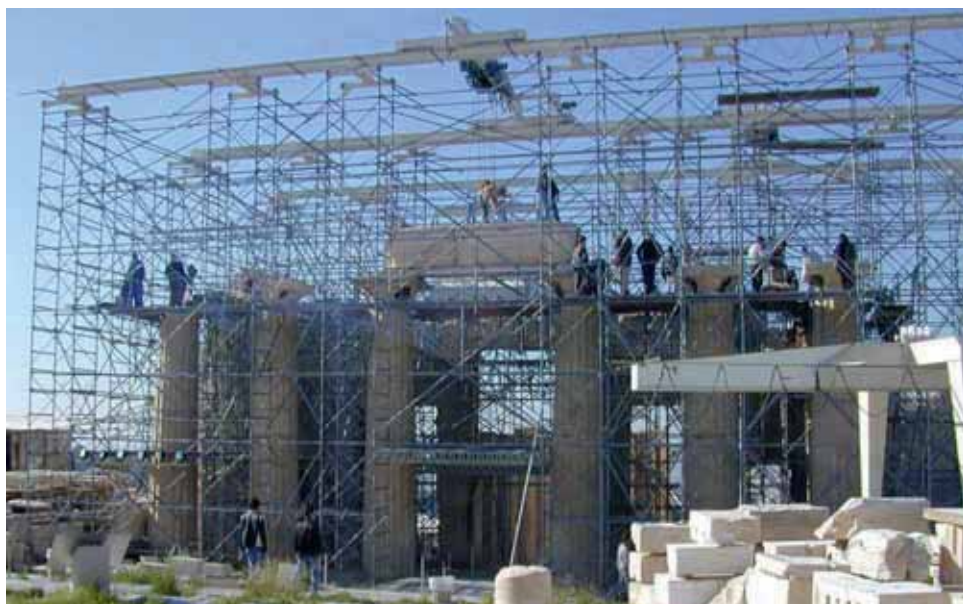
Εικ. 7. Το επιστόλιο του μεσαίου μετακινίου διαστήματος της ανατολικής στοάς των Προπυλαίων κατά τις εργασίες απομάκρυνσής του (Φωτ. Β. Πασχαλίδης).
