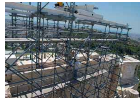
Εικ. 17. Αποψη από τα ΒΑ του νότιου τοίχου. Η γερανογέφυρα επί ικριωμάτων για τις εργασίες αποκατάστασης (2011) (Αρχείο Υ.Σ.Μ.Α.).
