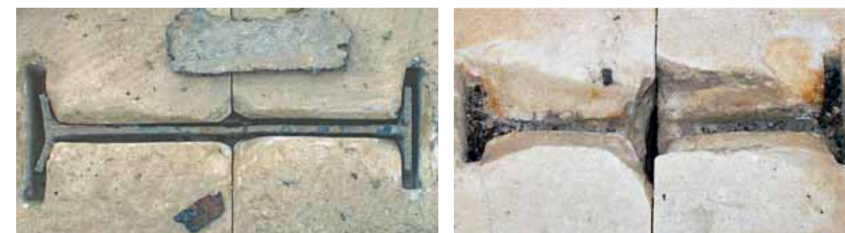
Εικ. 10. α: σύνδεσμος μορφής διπλού ταύ υψηλής ποιότητας, από τον νότιο τοίχο. β: υπολείμματα οξειδωμένου συνδέσμου μορφής διπλού ταύ στον βόρειο τοίχο.
