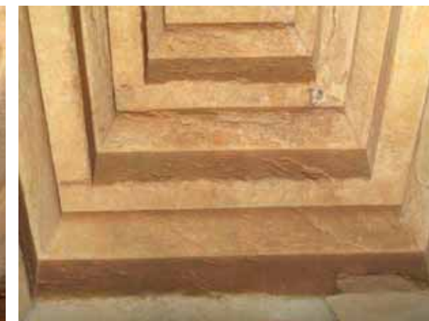
Εικ. 10. Τρίτη φατνωματική πλάκα, μάρμαρο με πορτοκαλί χροιά, μετά τον καθαρισμό.
