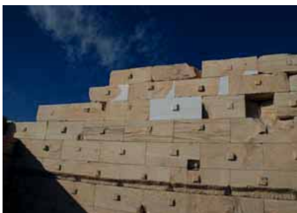
Εικ. 19. Άποψη της ανωδομής του νότιου τοίχου των Προπυλαίων μετά την αποκατάστασή της (2011) (Αρχείο Υ.Σ.Μ.Α.).
