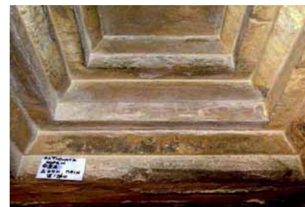
Εικ. 11. Όψη φατνώματος που λόγω των εκτεταμένων επικαθίσεων δεν είναι δυνατός ο διαχωρισμός των κονιαμάτων από το μάρμαρο ούτε είναι ευκρινής η παρουσία του μαύρου στρώματος.
