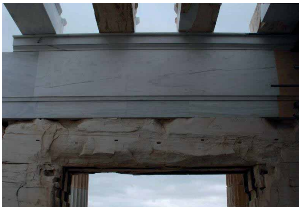
Εικ. 13. Η περιοχή των λίθων του υπερθύρου μετά την αποκατάσταση (Φωτ. Τ. Τανούλας).
