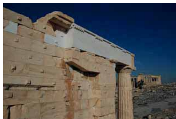
Εικ. 20. Άποψη από τα ΝΔ της αναστηλωμένης ανωδομής του νότιου τοίχου (2011) (Αρχείο Υ.Σ.Μ.Α.).
