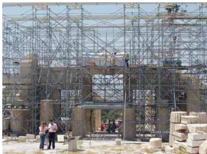
Εικ. 9. Η ανατολική στοά μετά την συμπλήρωση της αποξήλωσης των αρχιτεκτονικών μελών της αναστήλωσης του Μπαλάνου, και πριν την έναρξη των ανατοποθετήσεων (Μάιος 2003). Αποψη από τα ανατολικά.
