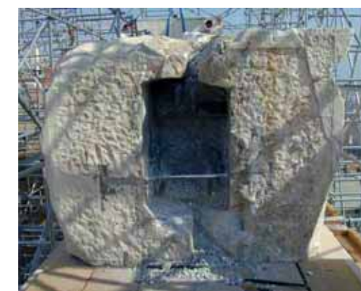
Εικ. 6. Οι δύο λίθοι του επιστυλίου μετά την έναρξη καθαρισμού των κεφαλών. Άποψη από νότια (Φωτ. Β. Πασχαλίδης).
