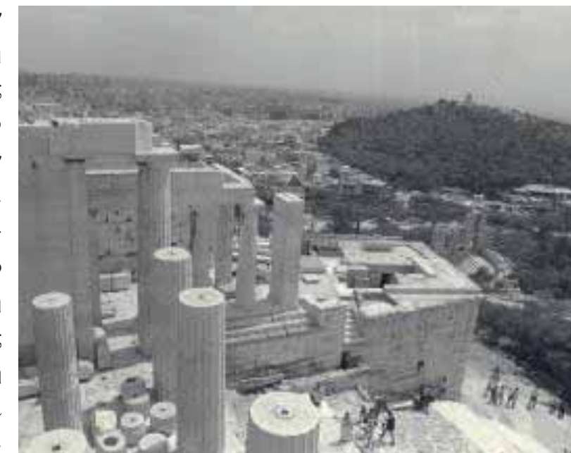
Εικ. 5. Αποψη του πύργου της Αθηνάς Νίκης μετά την αποσυναρμολόγηση του ναού.
