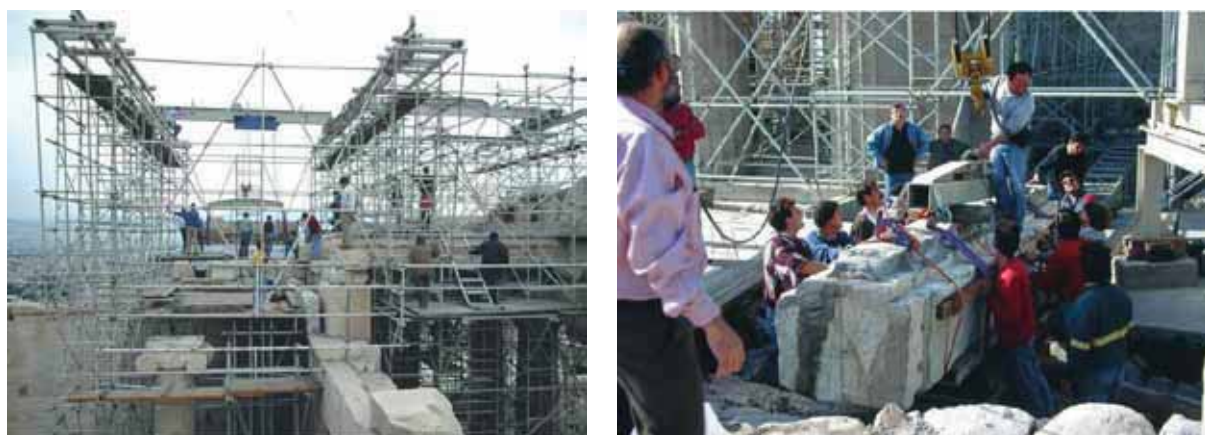
Εικ. 5. Από την καθαίρεση των τμημάτων των οροφών του κεντρικού κτιρίου που είχε αναστηλώσει ο Μπαλάνος (1992).
