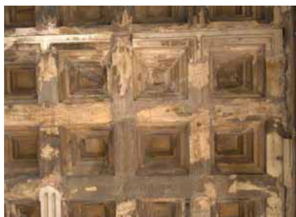
Εικ. 17. Τμήμα της φατνωματικής οροφής πριν από τις επεμβάσεις.
