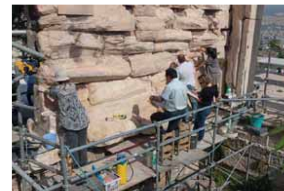
Εικ. 9. Ερέχθειο. Δυτικός τοίχος, εσωτερικά. Συστηματικές επεμβάσεις συντήρησης.
