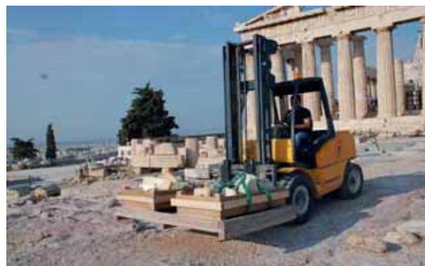
Εικ. 7. Μεταφορά πώρινων μελών με το περνοφόρο όχημα στις ξύλινες εξέδρες του συνεργείου των Διασπάρτων.
