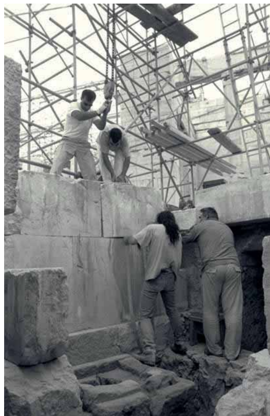
Εικ. 11. Εργασίες αποσυναμολόγησης των μελών του πώρινου ναού.
