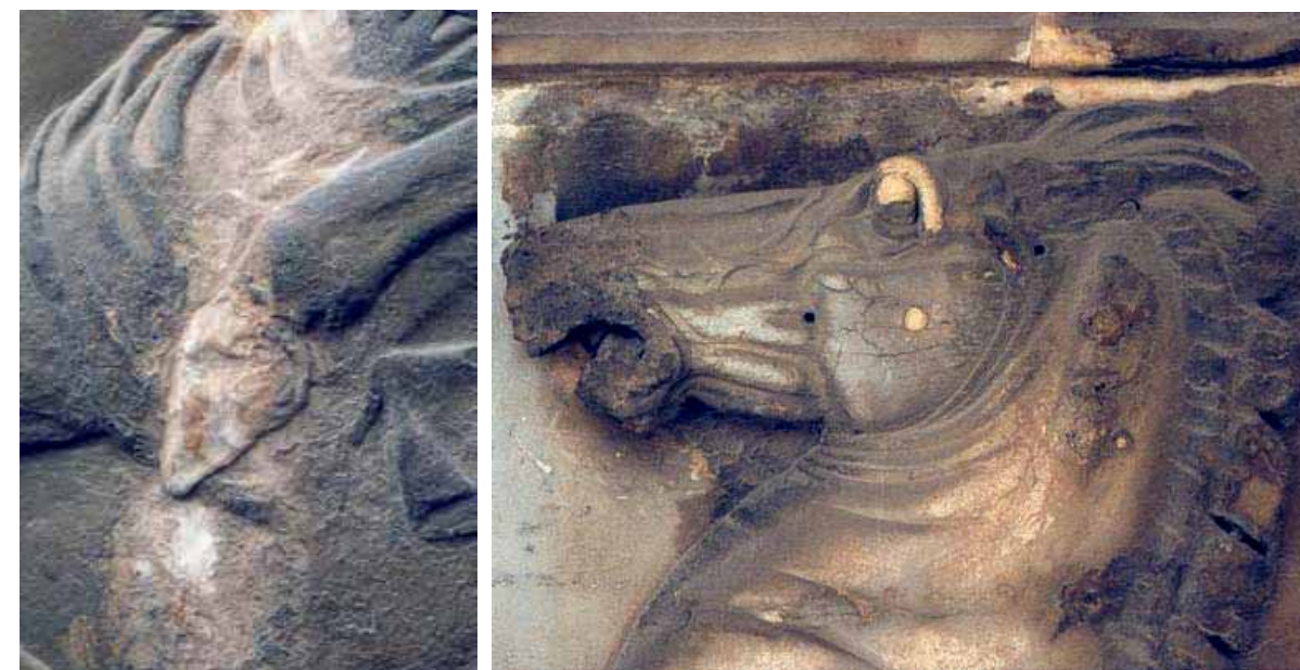
Εικ. 16. Δυτική Ζωφόρος λίθος XI. Εικ. 17. Δυτική Ζωφόρος λίθος VII. Παλαιότερη ανάπλαση Παλαιότερη ανάπλαση της οπλής του περιοχής του οφθαλμού του αλόγου με κονίαμα (φωτ. Τ. αλόγου της μορφής 21 με κονίαμα Σουβλάκης, Αρχείο Υ.Σ.Μ.Α). (Αρχείο Υ.Σ.Μ.Α).
