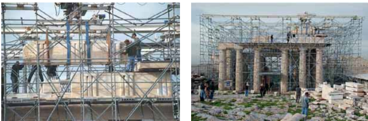
Εικ. 13. Ανατοποθέτηση του βόρειου από τους δύο μεγάλους λίθους της ζωφόρου της ανατολικής στοάς, επάνω από το κεντρικό μετακίονιο διάστημα. Έχει αποκατασταθεί η συνοχή των θραυσμάτων και η δομική αυτοτέλεια του αρχιτεκτονικού μέλους.
