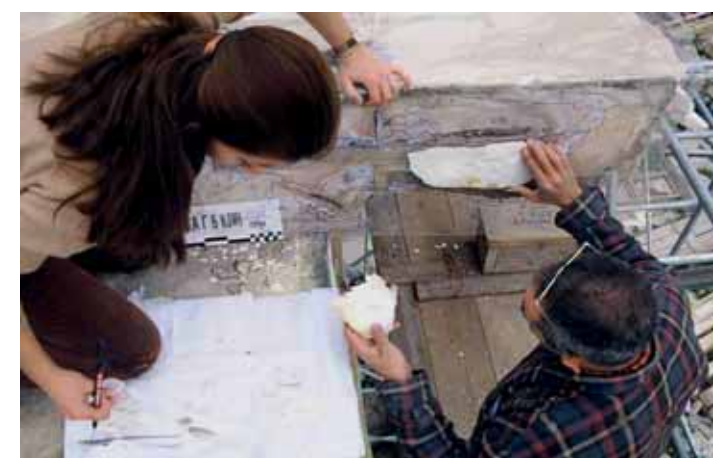
Εικ. 4. Προπύλαια. Γέισο ανατολικής πρόσοψης. Ταύτιση αποσπασμένων θραυσμάτων.
