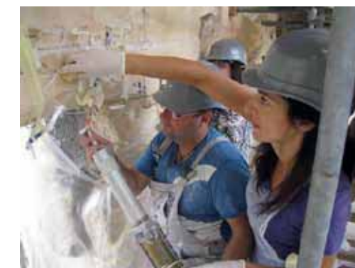
Εικ. 10. Ερέχθειο. Δυτικός τοίχος, εσωτερικά. Εφαρμογή ενέματος.
