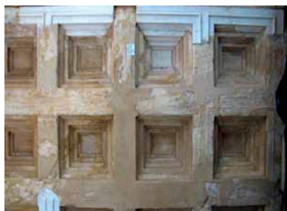
Εικ. 18. Τμήμα της φατνωματικής οροφής μετά τις επεμβάσεις.
