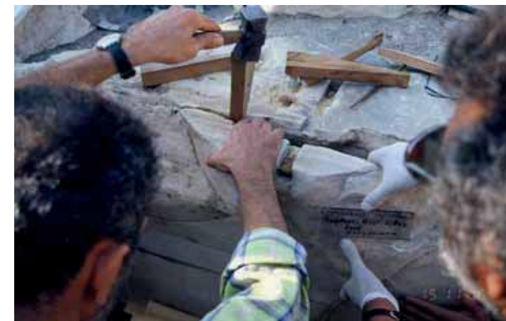
Εικ. 3. Προπύλαια. Κεντρ. κτίριο. Ανατολικός λίθος του κεντρικού υπερθύρου. Κατά την απομάκρυνση θραύσματος.
