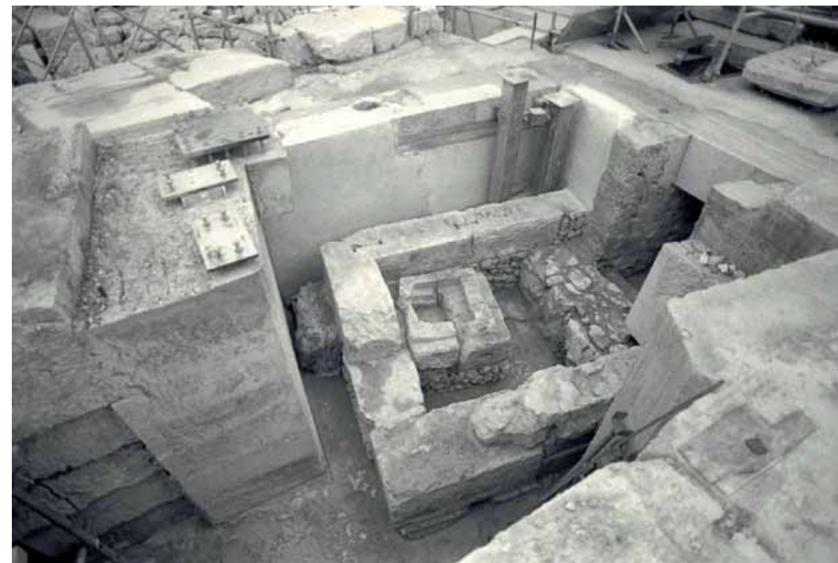
Εικ. 10. Ο πόρινος ναός μερικώς αποσυναρμολογημένος και οι απαιτούμενες νέες κατασκευές για την έδραση της μεταλλικής εσχάρας και την στήριξη της ΒΑ γωνίας του ναού.
