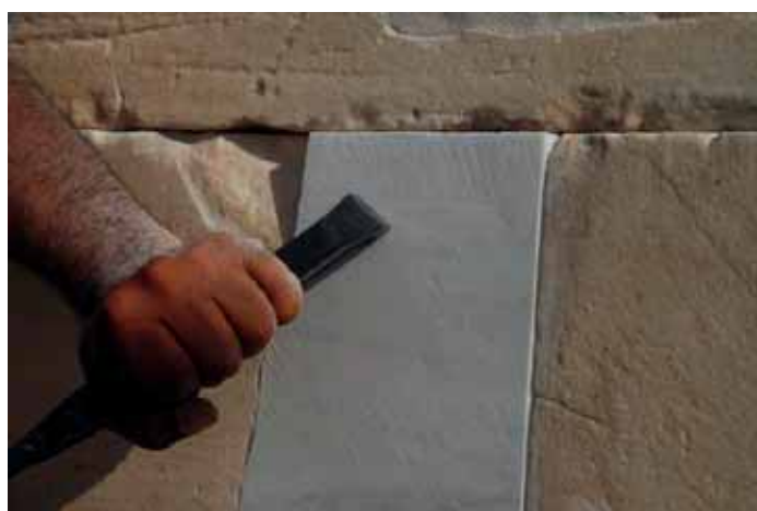
Εικ. 21. Κατά τη κατεργασία της τελικής επιφάνειας συμπληρώματος λίθου του δόμου 19 (2011) (Αρχείο Υ.Σ.Μ.Α.).
