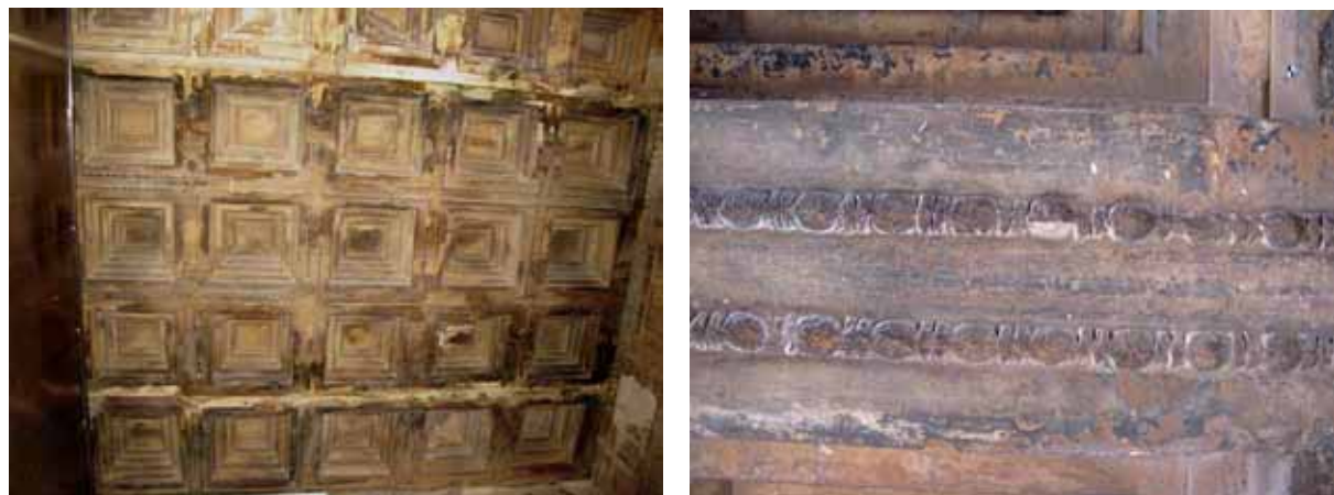
Εικ. 1. Η φατνωματική οροφή (1 η και 2 η πλάκα) της Πρόστασης των Κορών πριν τις επεμβάσεις. Εικ. 2. Οι διακοσμητικές ταινίες μεταξύ των φατνωμάτων, ορατές πριν τις επεμβάσεις.
