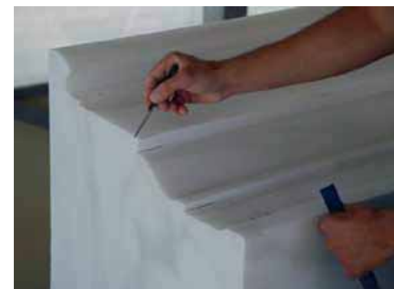
Εικ. 9. Κατά τις εργασίες λάξευσης της τελικής επιφάνειας του λίθου θράνου από νέο μάρμαρο (ΑΙ.Ν.ΘΡ.7) (Αρχείο Υ.Σ.Μ.Α.).
