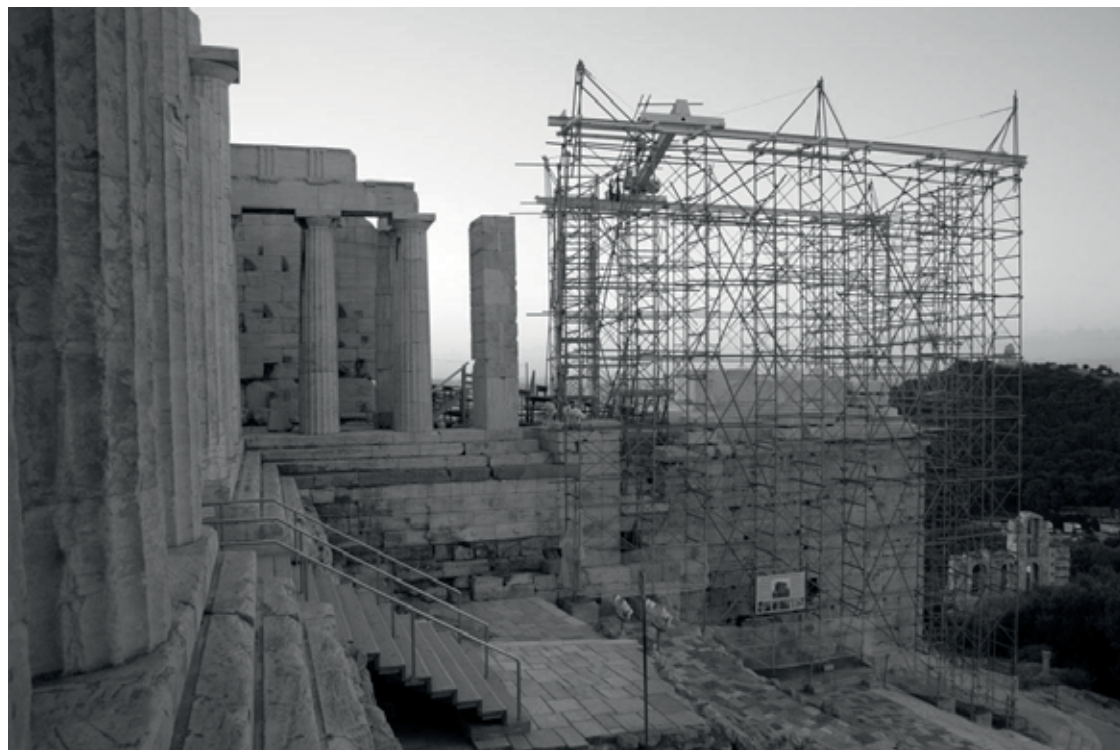
Εικ. 4. Σύστημα γερανογέφυρας επί ικριωμάτων για το έργο αποκατάστασης του μνημείου.
