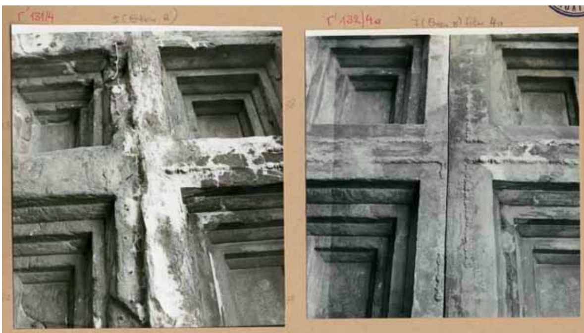
Εικ. 7. Επεμβάσεις 1970, ενίσχυση των συμπληρωμάτων από τσιμεντοκονίαμα με οπλισμό.
