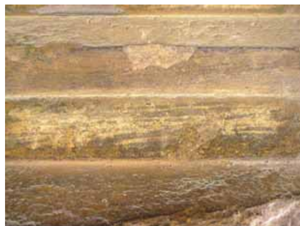
Εικ. 6. Ίχνη εφαρμογής με πινέλο του υπόλευκου επιχρίσματος πάνω από το μαύρο στρώμα.
