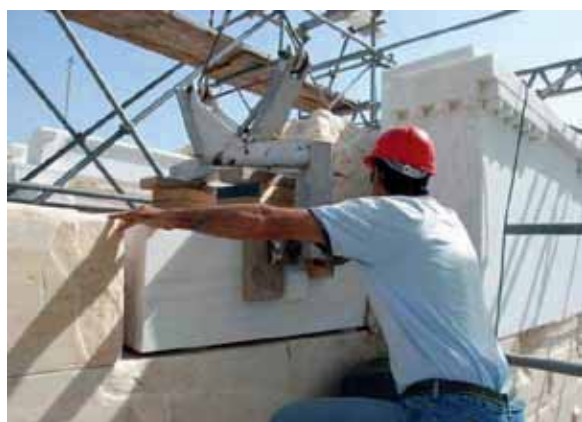
Εικ. 15. Κατά τις εργασίες ανατοποθέτησης του λίθου Κ.Ν.19.9 (2011) (Αρχείο Υ.Σ.Μ.Α.).
