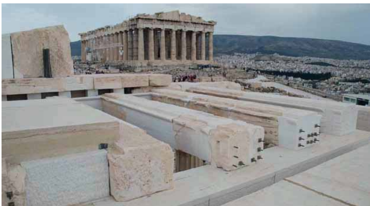
Εικ. 20. Η οροφή της ανατολικής στοάς από δυτικά μετά την ανατοποθέτηση των δοκών όπου φαίνονται οι πλάκες αγκύρωσης των ράβδων τιτανίου με τα περικόχλια (Φωτ. Τ. Τανούλας).
