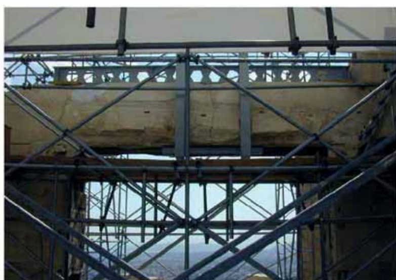
Εικ. 12. Η διάταξη προσωρινής ενίσχυσης του ανατολικού λίθου του κεντρικού υπερθύρου (Σχέδιο - φωτ. Β. Πασχαλίδης).
