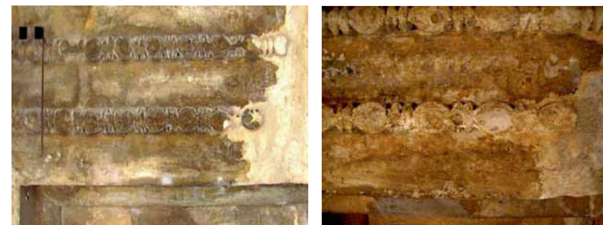
Εικ. 15. Ανάγλυφο αστράγαλοι μεταξύ φατνωμάτων, πριν από τον καθαρισμό.
