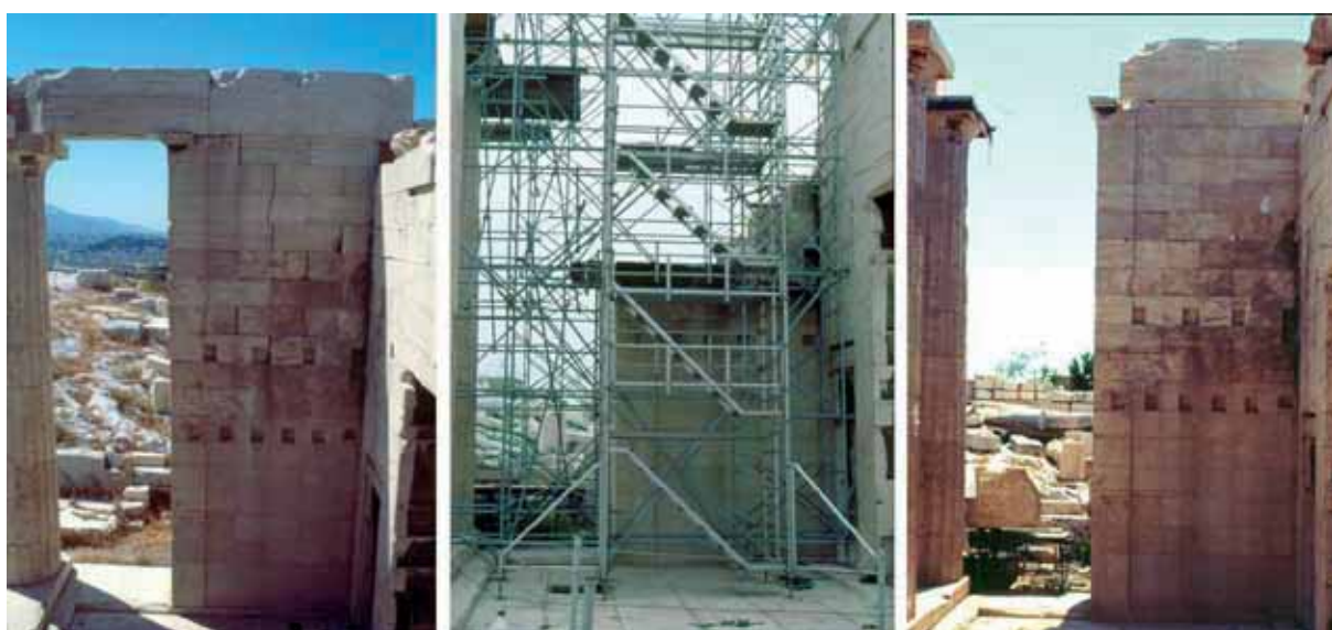
Εικ. 7. Το ανατολικό άκρο του νότιου τοίχου του κεντρικού κτιρίου των Προπυλαίων πριν, κατά και μετά την αποξήλωση και αποκατάσταση (1997-2001).
