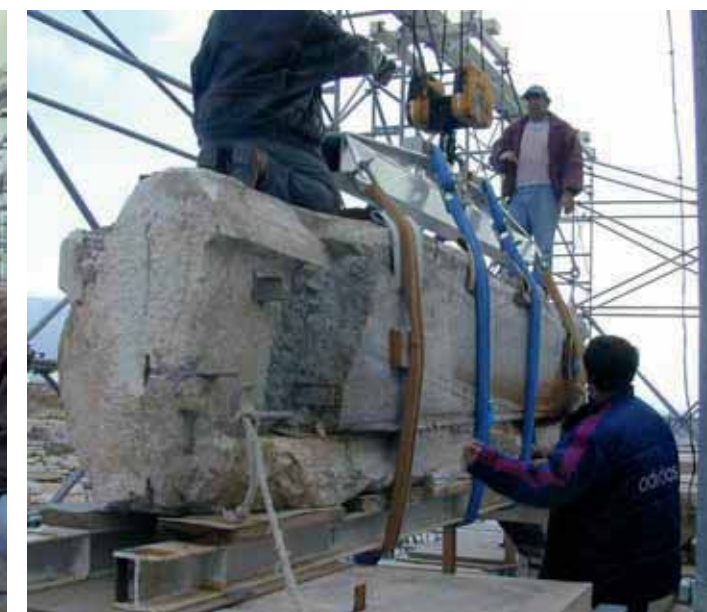
Εικ. 9. Η προετοιμασία της καθαίρεσης του ανατολικού λίθου. Διακρίνεται η εσχάρα υποστήλωσής του (Φωτ. Β. Πασχαλίδης).
