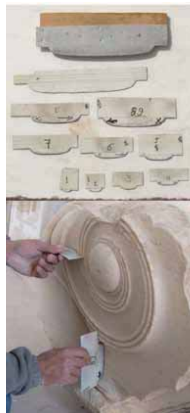
Εικ. 17. Τύποι (κν. φόρμες) για τον έλεγχο της ακριβούς αντιγραφής της μεταβαλλόμενης διατομής των ελίκων των νέων ιωνικών κιονοκράνων.
