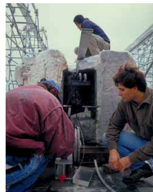
Εικ. 8. Η διάταξη της συρματοκοπής κατά την λειτουργία της (Φωτ. Β. Πασχαλίδης).
