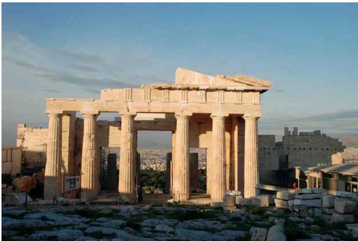
Εικ. 25. Αποψη των Προπυλαίων από τα ανατολικά μετά την αποκατάσταση στην ανωδομή του κεντρικού κτιρίου.
