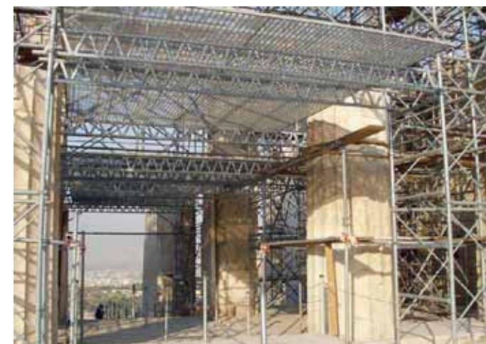
Εικ. 4. Το στέγαστρο στην κεντρική διάβαση των Προπυλαίων για την προστασία των επισκεπτών (Φωτ. Τ. Τανούλας).
