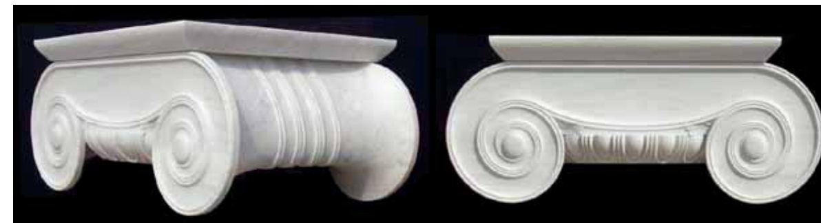
Εικ. 18. Δύο όψεις ενός από τα δύο ιωνικά κιονόκρανα που κατασκευάστηκαν στο εργοτάξιο των Προπυλαίων για να τοποθετηθούν στους δύο κίονες που αναστηλώθηκαν στη δυτική στοά.
