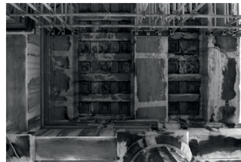
Εικ. 2. Ρηγματώσεις και θραύσεις των αναστηλωμένων την περίοδο 1909 - 1917 αρχιτεκτονικών μελών στις οροφές των Προπυλαίων (Φωτ. Τ. Τανούλας).
