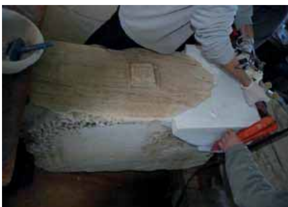
Εικ. 7. Κατά τις εργασίες συγκόλλησης νέου συμπληρώματος σε λίθο του δόμου 19 (2009-2010).
