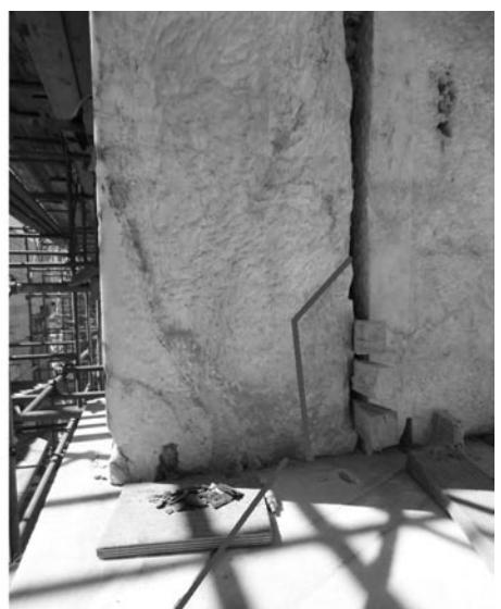
**Το ΝΑ θράυσμα εδράζεται σε περιοχή με έλλειψη μάζας στον υποκείμενο σπόνδυλο (αριστερά, κέντρο), και ρυγμάτωση από συγκέντρωση τάσεων που εμφανίζεται στην κάτω ΒΔ γωνία του εσωτερικού-ανατολικού λίθου του επιστυλίου των δεύτερου μετακιονίου (δεξιά). Φωτ. Α. Βρούβα, 2012**
