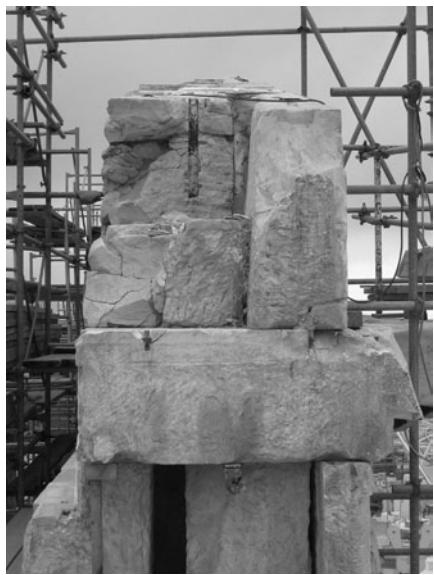
*Αποψη του γείσου Δ.Γ5 και των υπερκείμενων μελών του αντιθηματικού τοίχου και του τυμπάνου από Β, μετά τις αποσυναρμολογήσεις της ΒΔ γωνίας. Είναι χαρακτηριστικό το βάθος στο οποίο φαίνεται να επεκτείνονται οι ρηγματώσεις λόγω θερμικής θράσης των λιθοπλίνθων του αντιθηματικού τοίχου*
