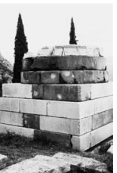
*Αποκατάσταση του μνημείου των Κροτωνιατών στους Δελφούς με δικαιολογημένη χρήση μεγάλου ποσοστού νέου υλικού. Φωτ. Χ. Μπούρας, 2006*
