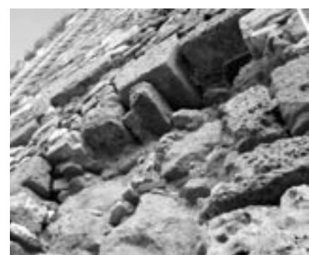
Χαρακτηριστική αποσάθρωση σε τμήμα του νότου Τείχους Ακροπόλεως. Φωτ. Δ. Εγγλέζος, 2008
