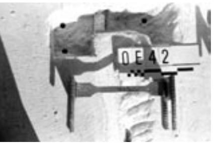
Νέοι σύνδεσμοι από τιτάνιο. Άνω: σύνδεσμοι μορφής Π σε αντακάσταση συνδέσμων παλαιοτέρων επεμβάσεων. Κάτω: σύνδεσμοι ειδικού σχήματος. Φωτ. P. Χριστοδούλου, 2003-04
