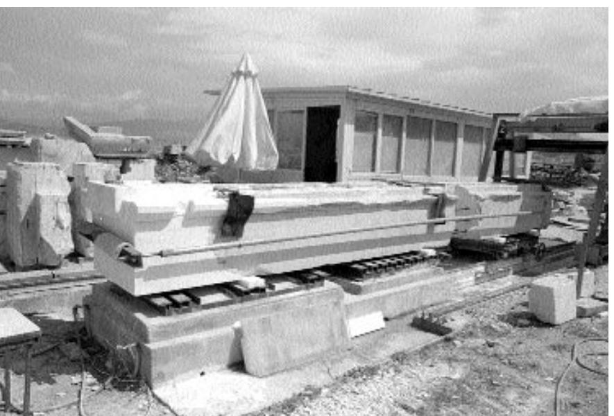
Συγκόλλωση δοκού οροφής Προπυλαών με χρήση σταθερής και κυλιόμενης τράπεζας
