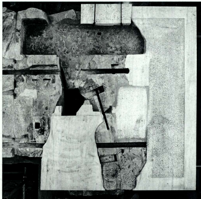
32. 帕特农神庙。复位后神庙东南角上的水平上楣柱（1992年）。 32. Parthenon. The horizontal cornice of the southeast corner after resetting in place (1992).
