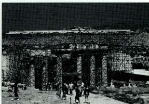
110-114. 卫城山门的内门廊正在拆除过程中（2002年）。 110-114. The dismantling of the inner porch of the Propylaea (2002).
