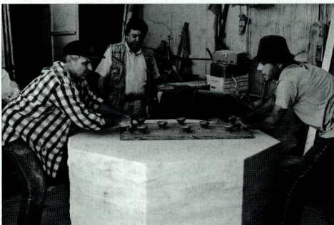
39. 切割伊瑞克提翁神庙的辅助性建筑构件（1985年）。 39. Cutting supplementary architectural members for the Erechtheion (1985).
