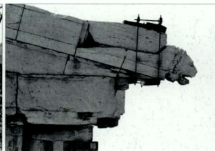
153-154. 在拆除前放置于一个临时支架上，带有狮头假喷水口的台柱（1986年）。 153-154. The sima with the lion-head false-spout on a temporary support before being dismantled (1986).
