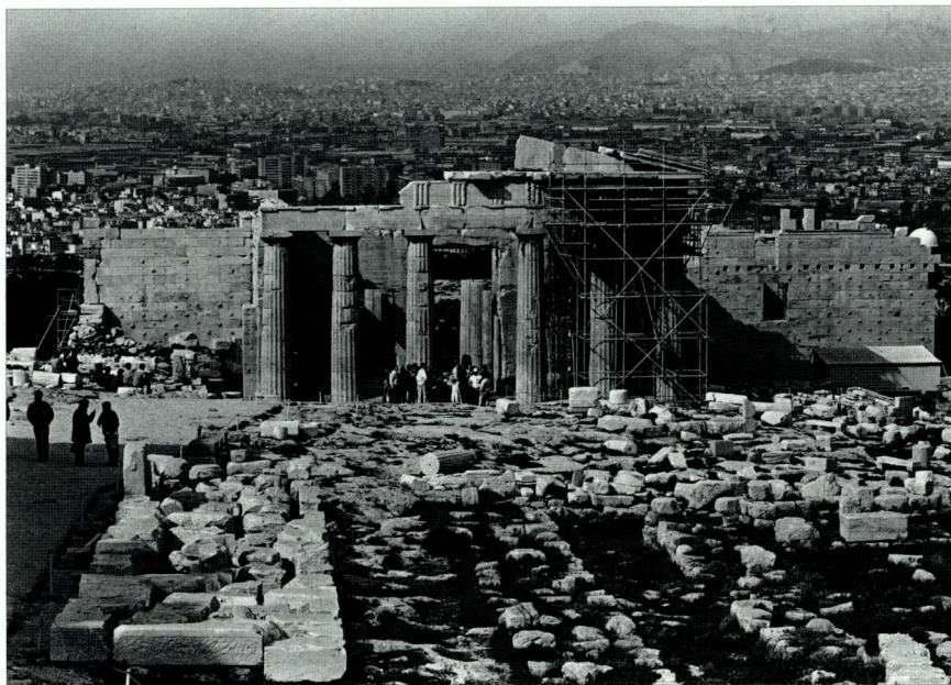
58. 修复工程开始时，装有脚手架的内门廊（1984年）。 58. The interior porch, with scaffolding at the beginning of the restoration programme (1984).
