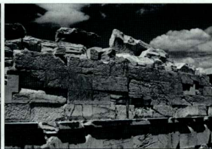
172. 帕特农神庙内部西侧山花。 172. The west pediment of the Parthenon interior.
