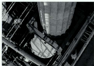
40. 帕特农神庙。将南柱廊的第5根柱子移走（1992年）。 40. Parthenon. Moving the 5th column of the south colonnade (1992).
