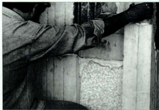
75-78. 卫城山门。将天花板饰板和用新大理石制成的辅助构件在必要的地方接合起来（2002年）。 75-78. Propylaea. Joining of the ceiling coffers with supplements in new marble where necessary (2002).
