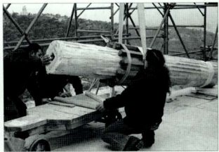
89-94. 雅典娜胜利女神庙中一个巨大的柱身被移走（2002年）。 89-94. Removal of a monolithic column shaft from the temple of Athena Nike (2002).
