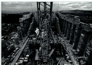
41. 帕特农神庙。安装在内殿中的起重机的（1987年）。 41. Parthenon. The crane inside the cella (1987).
