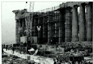
165-169. 正在拆除过程中的北柱廊（2002年）。 165-169. The north colonnade being dismantled (2002).
