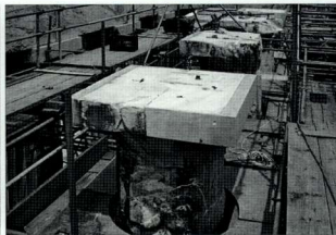
48-49. 帕特农神庙。现场修复过程中的后殿门廊柱（2002年）。 48-49. Parthenon. The columns of the opisthonaos during their restoration in situ (2002).
