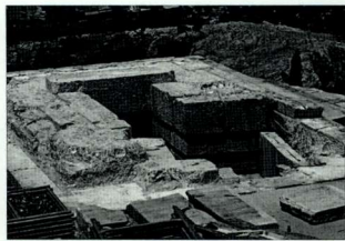
100-104. 雅典娜胜利女神庙在完全拆除后的地基。同一处可以清晰地看到早期用粗粒灰岩建成的圣祠（2002年）。 100-104. The foundations of the temple after the complete dismantling of the temple. Visible are sections of the earlier poros shrine in the same place (2002).
