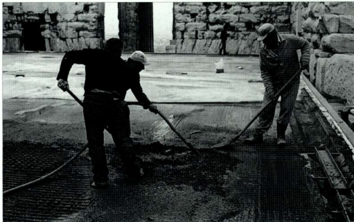
18. 对帕特农神庙搭建的临时高空工作台进行金属加固 (1985年)。 18. The metal reinforcing for the temporary work-floor in the Parthenon (1985). 19. 对帕特农神庙中搭建的临时高空工作台浇筑混凝土 (1985年)。 19. The laying of concrete for the temporary work-floor in the Parthenon (1985).
