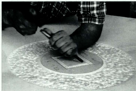
41. 为一个新大理石填料制备粗糙表面（2002年）。 41. Preparing a coarse surface on a new marble filling (2002).
