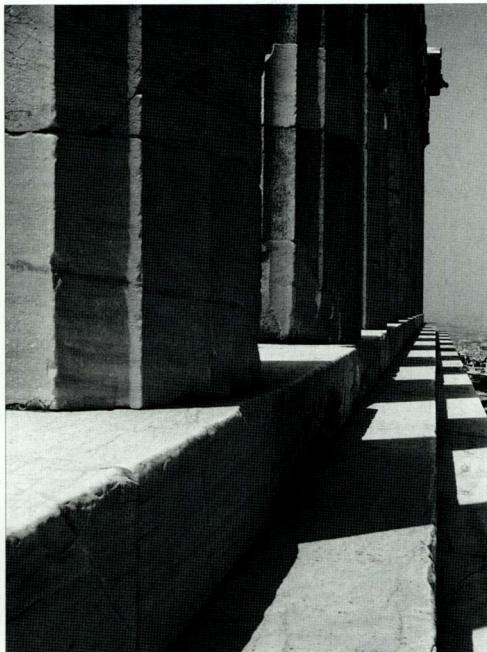
78. 北柱廊的基座和祭坛（1980年）。 78. The stylobate and krepis of the north colonnade (1980).
