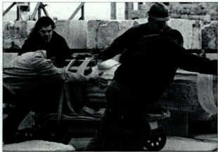
95. 雅典娜胜利女神庙中一个巨大的柱身被移走（2002年）。 95. Removal of a monolithic column shaft from the temple of Athena Nike (2002).
