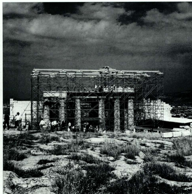
59. 内门廊，旁边是一个用于拆除上横梁的桥式起重机（2002年）。 59. The interior porch, with a bridge crane for dismantling the entablature (2002).
