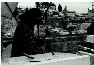
56-60. 卫城山门。用新大理石制成的爱奥尼式柱头的复制品（2002年）。 56-60. Propylaea. Making copies of the Ionic capitals in new marble (2002).
