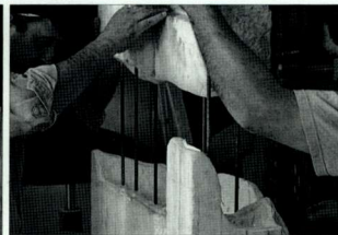
75-78. 卫城山门。将天花板饰板和用新大理石制成的辅助构件在必要的地方接合起来（2002年）。 75-78. Propylaea. Joining of the ceiling coffers with supplements in new marble where necessary (2002).
