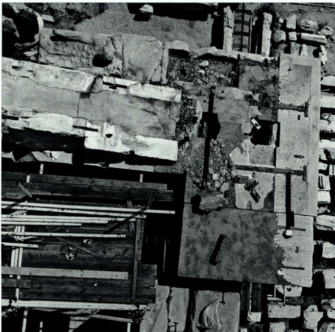
31. 帕特农神庙。在拆除过程中的神庙东南角。水平上楣柱和生锈的铁制加固件清晰可见（1988年）。 31. Parthenon. The southeast corner during dismantling. Visible are the corner horizontal cornice and the rusted iron reinforcements (1988).
