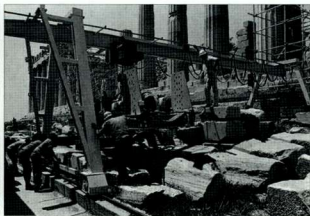
20. 安装在卫城东南角的特制升降机 (1985年)。 20. The special hoisting machine at the southeast corner of the Acropolis (1985). 21. 电动拖车正在移动一个大理石建筑构件。 21. Electric hauling vehicle moving a marble architectural member.
