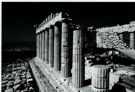
73. 修复后的东端细部（2002年）。 73. Detail of the east end after the restoration (2002).
