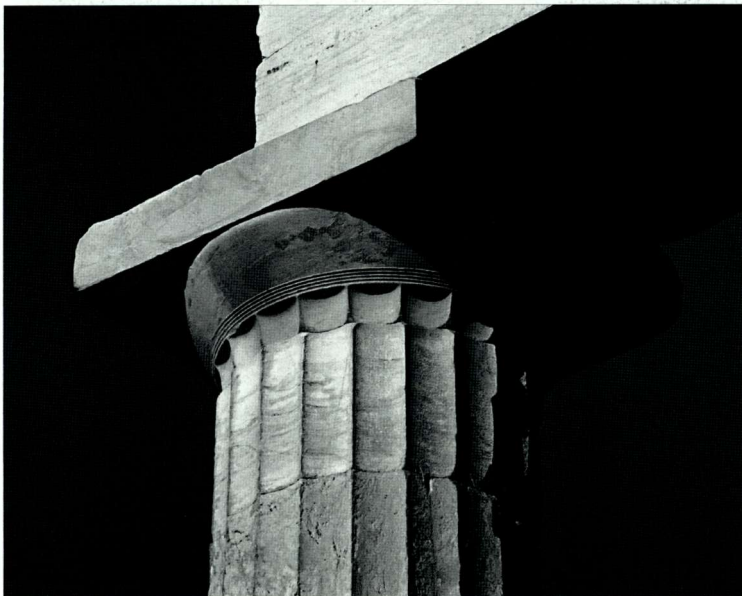
86. 南柱廊的多利克式柱头细部（1994年）。
