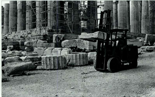
20. 安装在卫城东南角的特制升降机 (1985年)。 20. The special hoisting machine at the southeast corner of the Acropolis (1985). 21. 电动拖车正在移动一个大理石建筑构件。 21. Electric hauling vehicle moving a marble architectural member.
