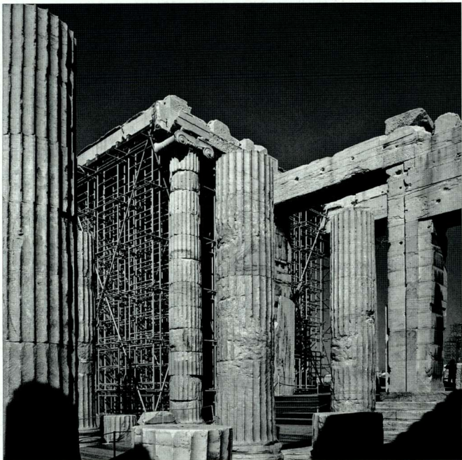
54. 拆除前的中央大厅（1985年）。 54. The central hall before beginning the dismantling (1985).
