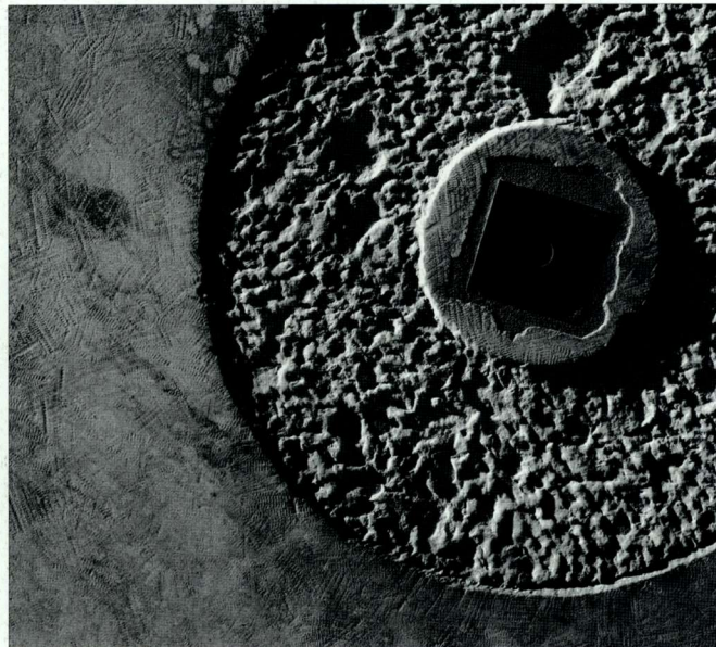
87. 平放着的柱子表面细部，显示有环行的凸起石缘和新的木榫（2002年）。
