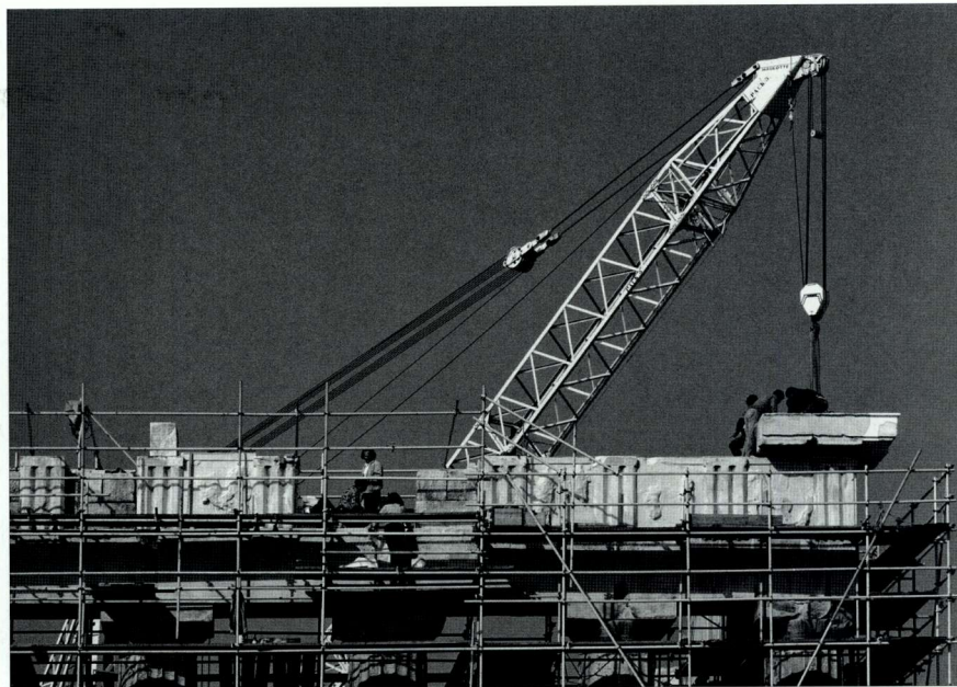
28. 帕特农神庙。正在复位过程中的东端上楣柱（1990年）。 28. Parthenon. During the re-setting of the cornice of the east end (1990).
