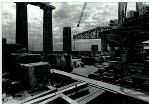
20. 安装在卫城东南角的特制升降机 (1985年)。 20. The special hoisting machine at the southeast corner of the Acropolis (1985). 21. 电动拖车正在移动一个大理石建筑构件。 21. Electric hauling vehicle moving a marble architectural member.
