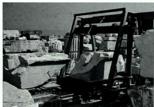
55. 卫城山门。用来连接大块大理石的石板（2002年）。 55. Propylaea. Table used for joining large pieces of marble (2002).
