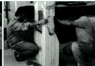
75-78. 卫城山门。将天花板饰板和用新大理石制成的辅助构件在必要的地方接合起来（2002年）。 75-78. Propylaea. Joining of the ceiling coffers with supplements in new marble where necessary (2002).
