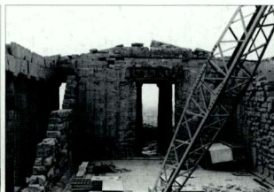
152. 安装起重机后的帕特农神庙内部（1986年）。 152. The interior of the Parthenon after installation of the crane (1986).
