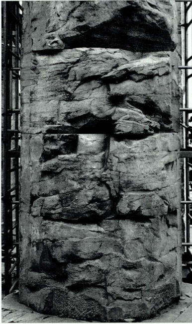
4. 帕特农神庙前殿的一个石柱因受热不均而破裂 4. Column in the Parthenon pronaos showing thermal fracturing.
