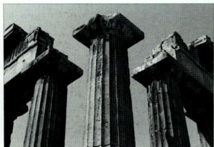
155-157. 上横梁移走后的东北角柱（1986年）。 155-157. The northeast corner after removal of the entablature (1986).
