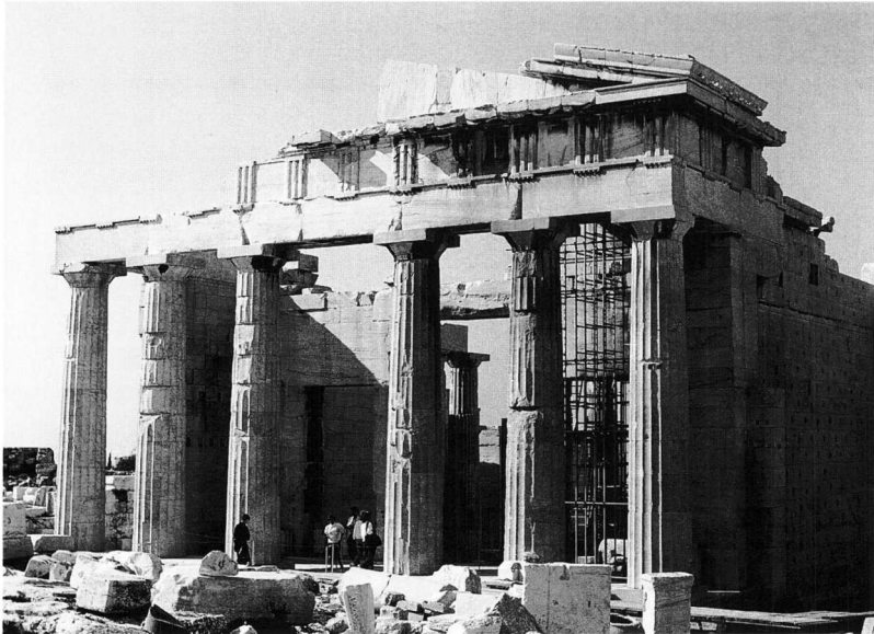
11. Η Ανατολική Στοά των Προπυλαίων πριν από την εγκατάσταση των ικριωμάτων για την αποξήλωση των αναστηλωμένων από τον Μπαλάνο οροφών. Από τα βορειοανατολικά.
