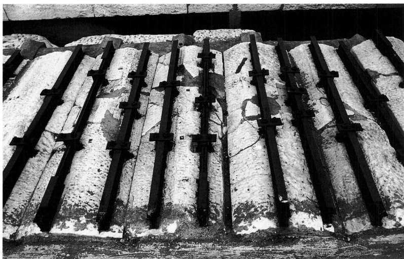
10. Αναστηλωμένες από τον Μπαλάνο φατνωματικές πλάκες στο πρώτο από Βορρά μεταδόκιο διάστημα της Ανατολικής Στοάς. Τα θραύσματα που απαρτίζουν κάθε πλάκα είναι αναρτημένα από σιδερένιες δοκούς διατομής Η, τοποθετημένες επάνω στις δοκούς.
