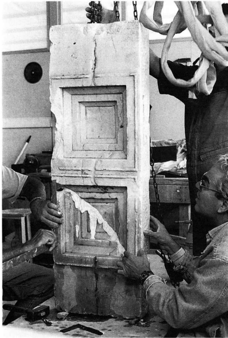
23γ, δ. Συγκόλληση της φατνωματικής πλάκας α/α 32 της Δυτικής Αίθουσας. Έχει επιτευχθεί η πλήρης συναρμογή των δύο τμημάτων και το πλεονάζον ρευστό τοιμεντοκονίαμα έχει εκκρεύσει κατά μήκος των ορίων των επιφανειών θραύσης που συναρμώστηκαν.
