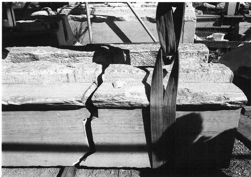
24. Αποκόλληση δύο τμημάτων του θραύσματος 1 της δοκού Σ.Δ.1 της αναστήλωσης Μπαλάνου. Το θραύσμα 1 έσπασε σε δύο τμήματα λόγω της οξειδωσης και της διόγκωσης του σιδερένιου αναρτήρα της αναστήλωσης.
