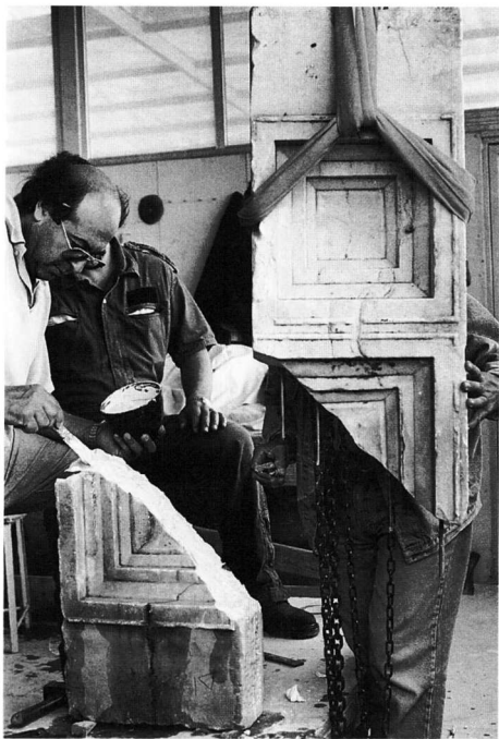
23α, β. Συγκόλληση της φατνωματικής πλάκας α/α 32 της Δυτικής Αίθουσας. Στο υπερκείμενο στην εικόνα τμήμα έχουν ήδη τοποθετηθεί οι ράβδοι τιτανίου. Οι υποδοχές των ράβδων τιτανίου στο υποκείμενο τμήμα έχουν πληρωθεί με ρευστό τσιμεντοκονίαμα.
