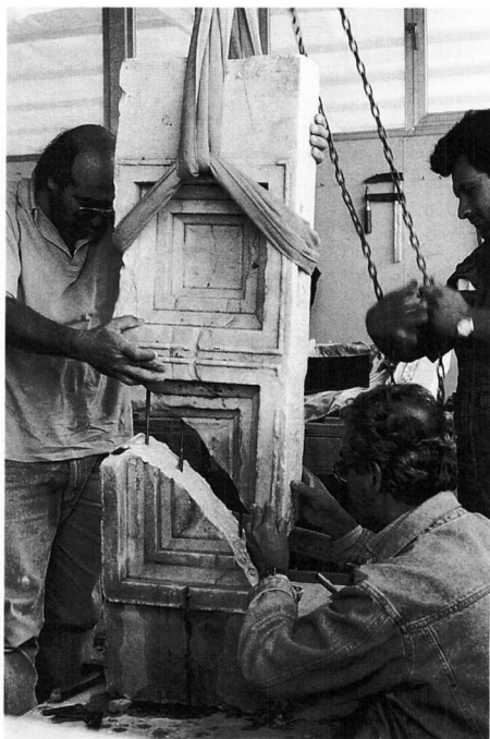
23α, β. Συγκόλληση της φατνωματικής πλάκας α/α 32 της Δυτικής Αίθουσας. Στο υπερκείμενο στην εικόνα τμήμα έχουν ήδη τοποθετηθεί οι ράβδοι τιτανίου. Οι υποδοχές των ράβδων τιτανίου στο υποκείμενο τμήμα έχουν πληρωθεί με ρευστό τσιμεντοκονίαμα.
