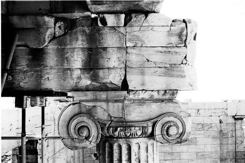
13. Το αναστηλωμένο από τον Μπαλάνο ιωνικό κιονόκρανο στον ανατολικό κίονα της βόρειας ιωνικής κιονοστοιχίας. Βόρεια όψη.
