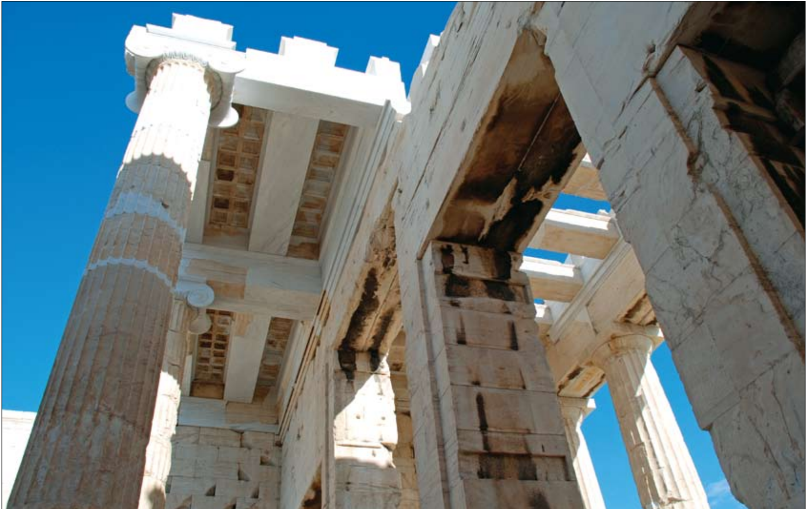
57. Προπύλαια. Οι αποκατεστημένες οροφές της κεντρικής αίθουσας και της ανατολικής στοάς από τα νότια.
