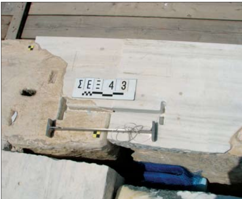
12 Τοποθέτηση συνδέσμου διπλού τσιμεντοκονιάματος για τη σύνδεση δύο επιστυλίων της βόρειας πλευράς του Παρθενώνα.
