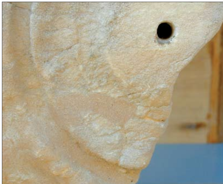
13α-β. Κιονόκρανο της ανατολικής πρόστασης του Ερεχθείου. Η κατάσταση της επιφάνειας πριν και μετά τις επεμβάσεις συντήρησης.
