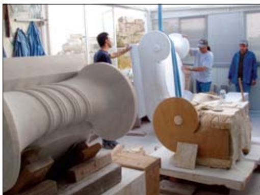
51. Κατασκευή ιονικών κιονοκράνων από νέο μάρμαρο στο εργαστήριο των Προπυλαίων.
