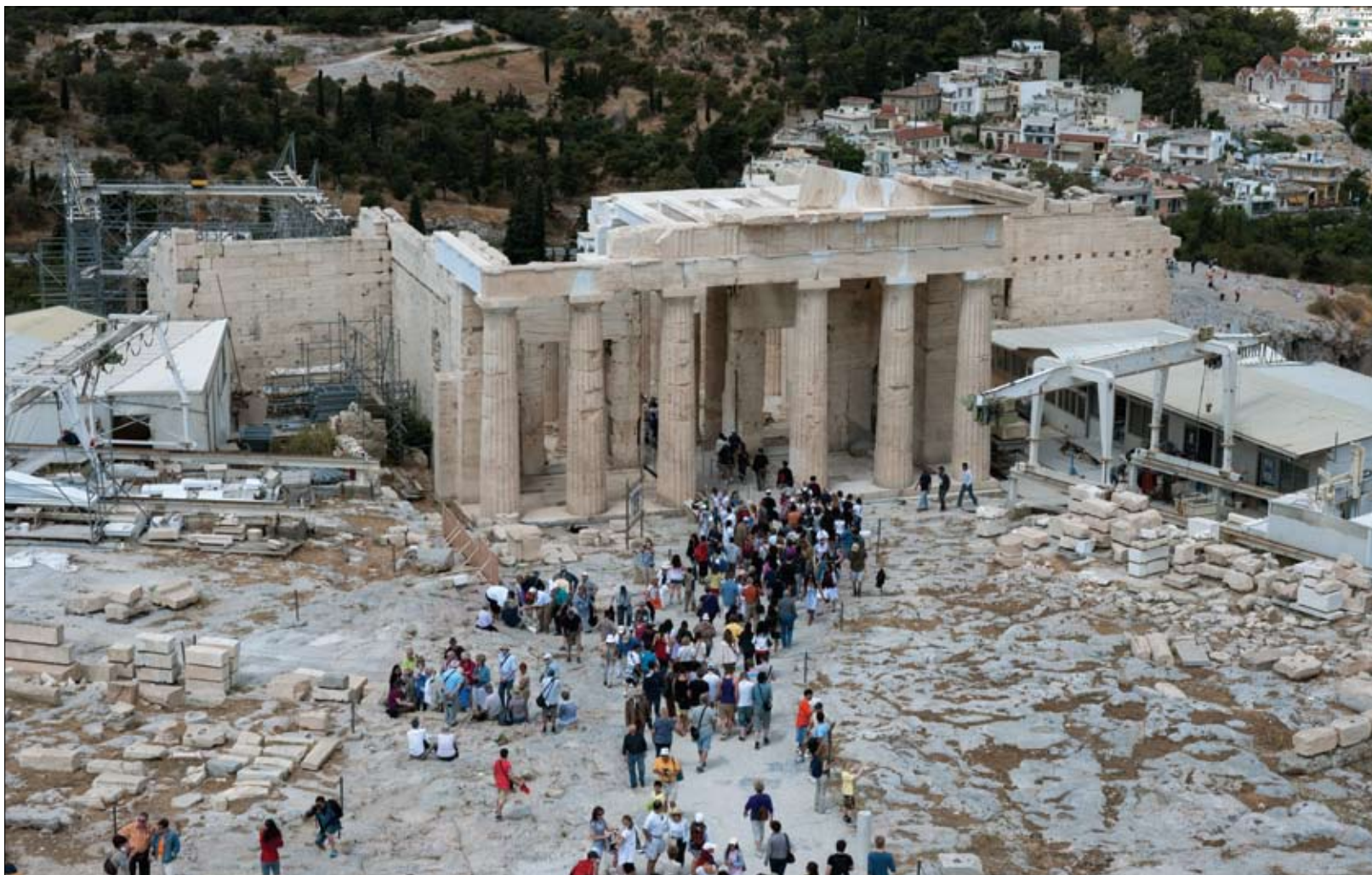
59. Τα Προπύλαια μετά την ολοκλήρωση των επεμβάσεων του προγράμματος 2001-2010 στο μνημείο. Άποψη από τον Παρθενώνα (2009).
