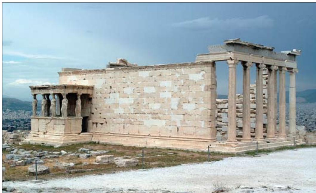
2. Το Ερέχθειο μετά την αναστήλωσή του. Άποψη από τα νοτιοανατολικά.
