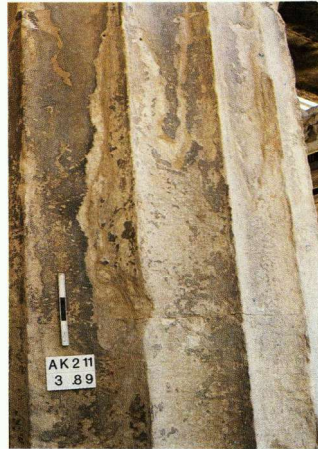
Σχ. 40. Μετά τη συγκόλληση της αποφλοιώσης και ολοκλήρωση της επέμβασης. Παρθενών Α.Κ. 2.11.
