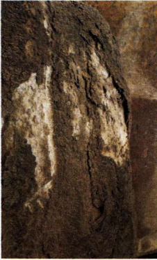
Σχ. 29. Αποσάθρωση μαρμάρου σε συνδυασμό με επικαθήσεις αιθάλης και σχηματισμό μαύρης κρούστας.
