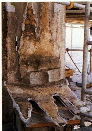
Σχ. 38. Ίδια περιοχή με Σχ. 37 μετά τον αποχωρισμό της αποφλοίωσης. Παρθενών Α.Κ. 2.11.
