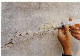
Σχ. 41. Πλήρωση εσωτερικών κενών με ένεμα. Προπύλαιο. Β-Δ.Ο. 6.
