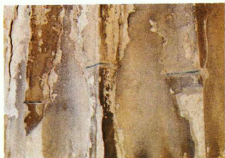
Σχ. 37. Λεπτομέρεια παλαιότερης στερεωτικής επέμβασης της περιόδου 1922-1933 με κονία Meyer και χάλκινους συνδετήρες. Παρθενών Α.Κ. 2.11.
