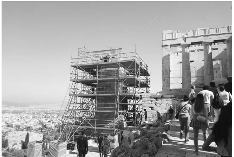
Αποψη από ΝΑ του μνημείου του Αγκρίππα, μετά την εγκατάσταση ικρίωματος εργασίας. Φωτ. Β. Εβρευθερίου, 2022
