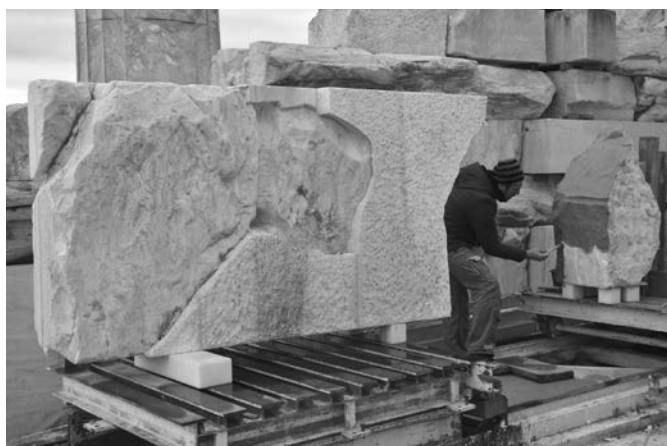
Κατεργασία συμπληρώματος λίθου ορθοστάτη του νότιου τοίχου του σηκού του Παρθενώνα. Φωτ. Ρ. Χριστοδουλοπούλου, 2022
