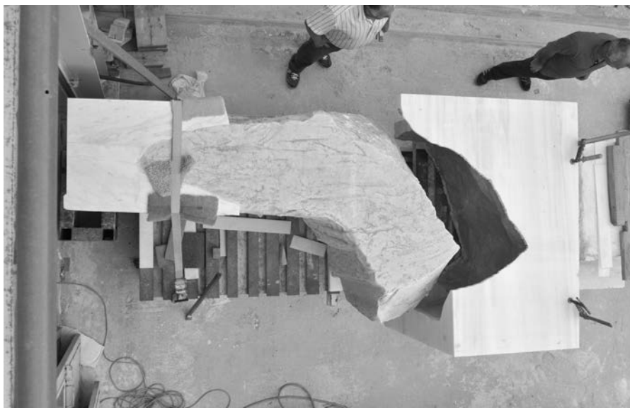
Προσαρμογή συμπληρώματος στον ορθοστάτη της βορειοανατολικής παραστάδας του Παρθενώνα. Το συμπλήρωμα διαμορφώθηκε σε CNC, μετά από ψηφιακή σάρωση του εκμαγείου. «Μικτή μέθοδος». Φωτ. Β. Μανιδάκη, 2014
