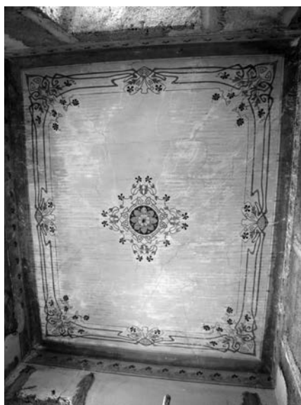
Οροφωγραφία στον β' όροφο του κτηρίου 1. Φωτ. Κ. Σκαρής, 2012
