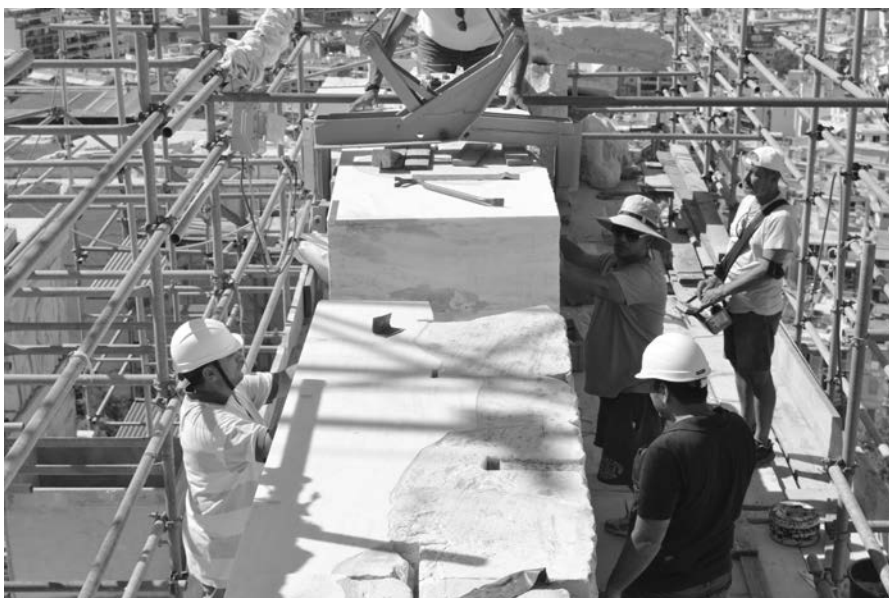
Δοκιμαστική τοποθέτηση λίθου του αντιθηματικού τοίχου του δυτικού αετώματος του Παρθενώνα. Φωτ. Κ. Σκαρής, 2022
