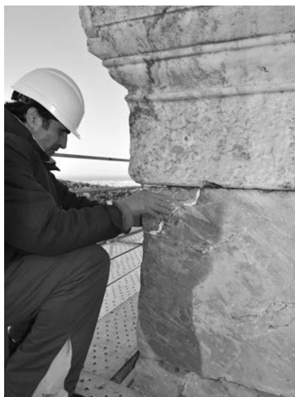
Άποψη από Α κατά τις εργασίες συγκόλλησης θραύσματος λίθου του κορμού του μνημείου. Φωτ. Π. Βλαχούλη, 2022
