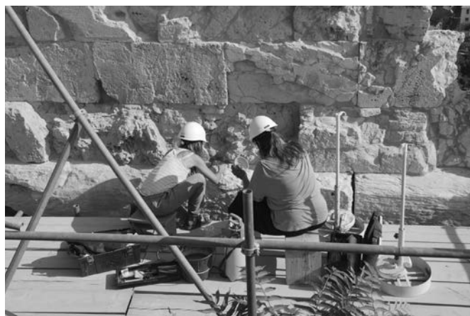
Εργασίες συντήρησης στο βόρειο τείχος, στην περιοχή Β12. Φωτ. Α. Τσιμερέκη, 2021
