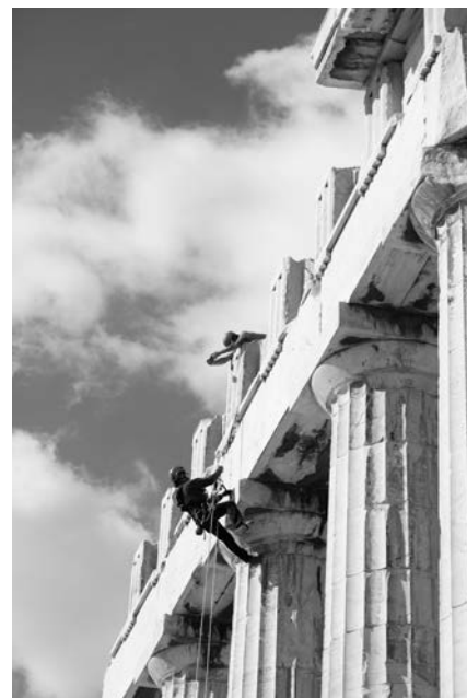
Καθαρισμός των μνημείων από βλάβιση, από συνεργείο ειδικευμένων εναερίτων, 2022
