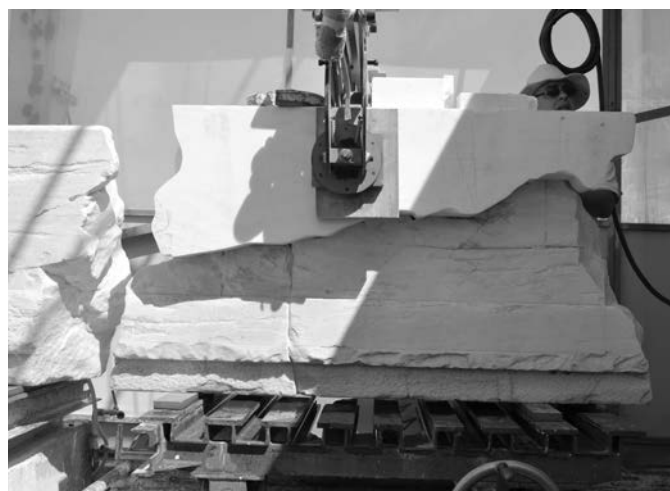
Αριστερά: εκμαγείο για τη συμπλήρωση της ζωφόρου της νότιας πτέρυγας των Προπυλαίων. Δεξιά: δοκιμαστική τοποθέτηση του συμπληρώματος που διαμορφώθηκε σε CNC, μετά από ψηφιακή σάρωση του εκμαγείου. «Μικτή μέθοδος». Φωτ. Β. Μανιδάκη, 2014
