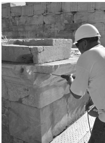
Άποψη από ΝΑ κατά τις εργασίες στερέωσης λίθου της επίστεψης του μνημείου. Φωτ. Κ. Καρανάσος, 2022
