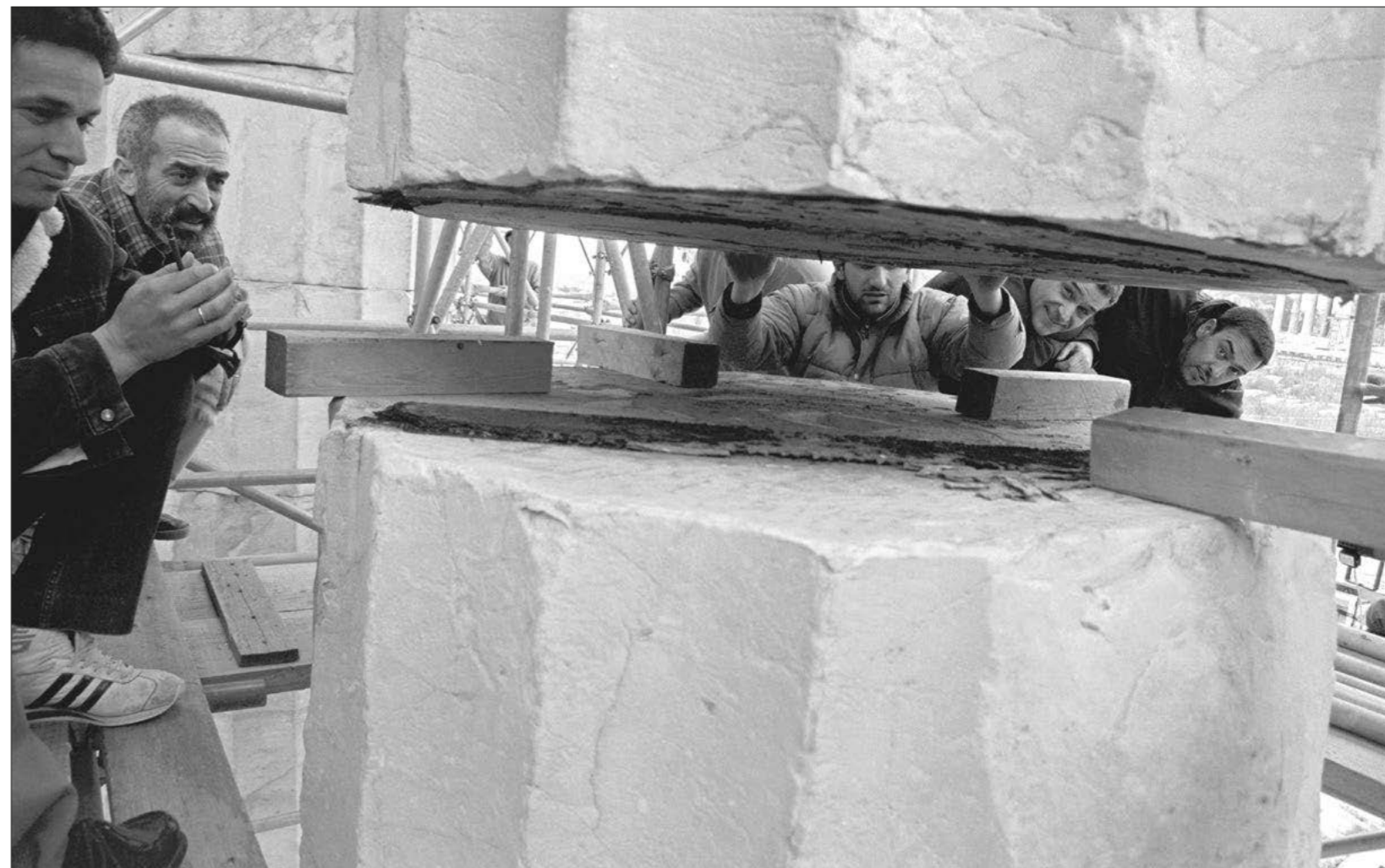
Προπύλαια. Αποξήλωση σπονδύλου του νότιου κίονα της ανατολικής πρόστασης: η στιγμή της αποκάλυψης του εγκλωβισμένου πριονιού της αναστήλωσης Πιττάκη-Ραγκαβή (2003)
