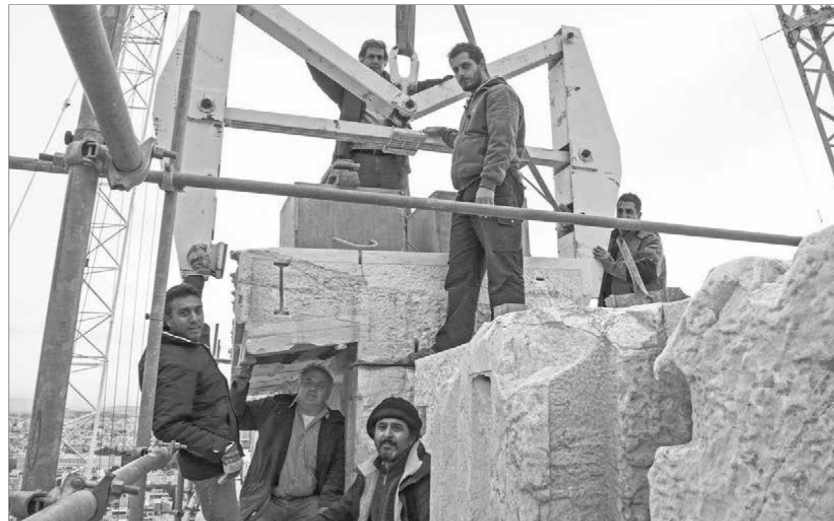
Παρθενώνας. Μέλη του συνεργείου κατά τις εργασίες ανατοποθέτησης των γείσων του βόρειου πτερού (2009)
