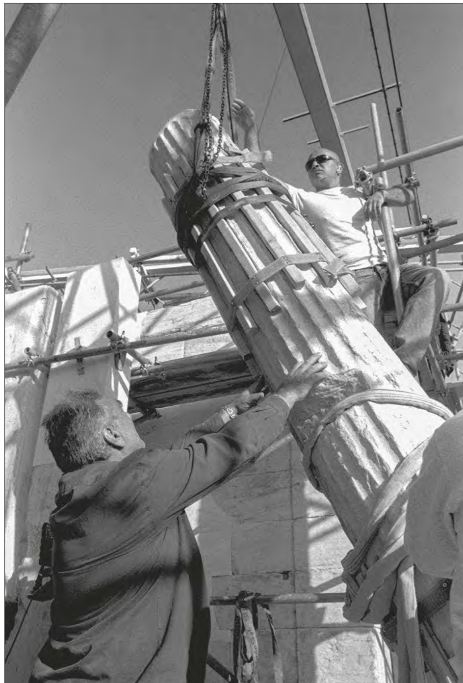
Ναός Αθηνάς Νίκης. Τοποθέτηση κίονα της ανατολικής πρόστασης στην οριστική του θέση (2008)
