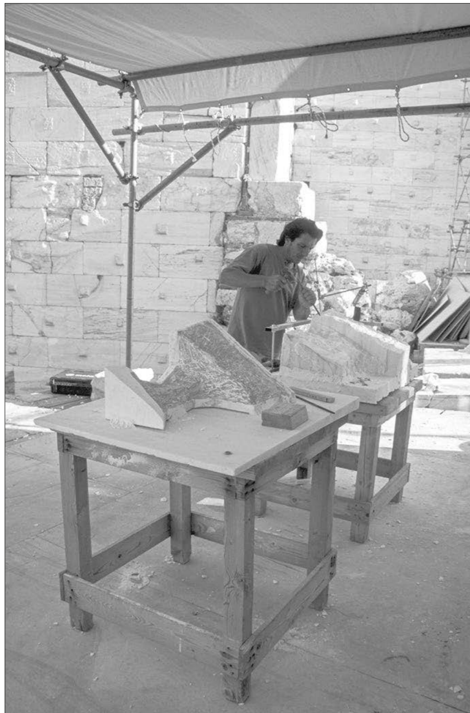
Ναός Αθηνάς Νίκης. Αντιγραφή εκμαγείου με χρήση πονταδόρου για τη διαμόρφωση συμπληρώματος λίθου (2002)
