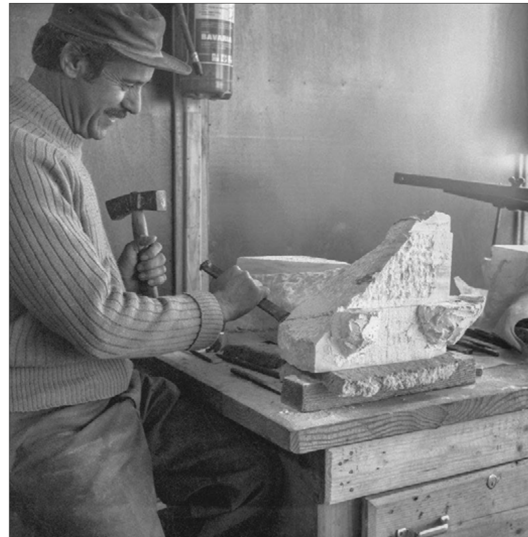
Ερέχθειο. Διαμόρφωση συμπληρώματος σε επιστύλιο της πρόστασης των Κορών (1979)
