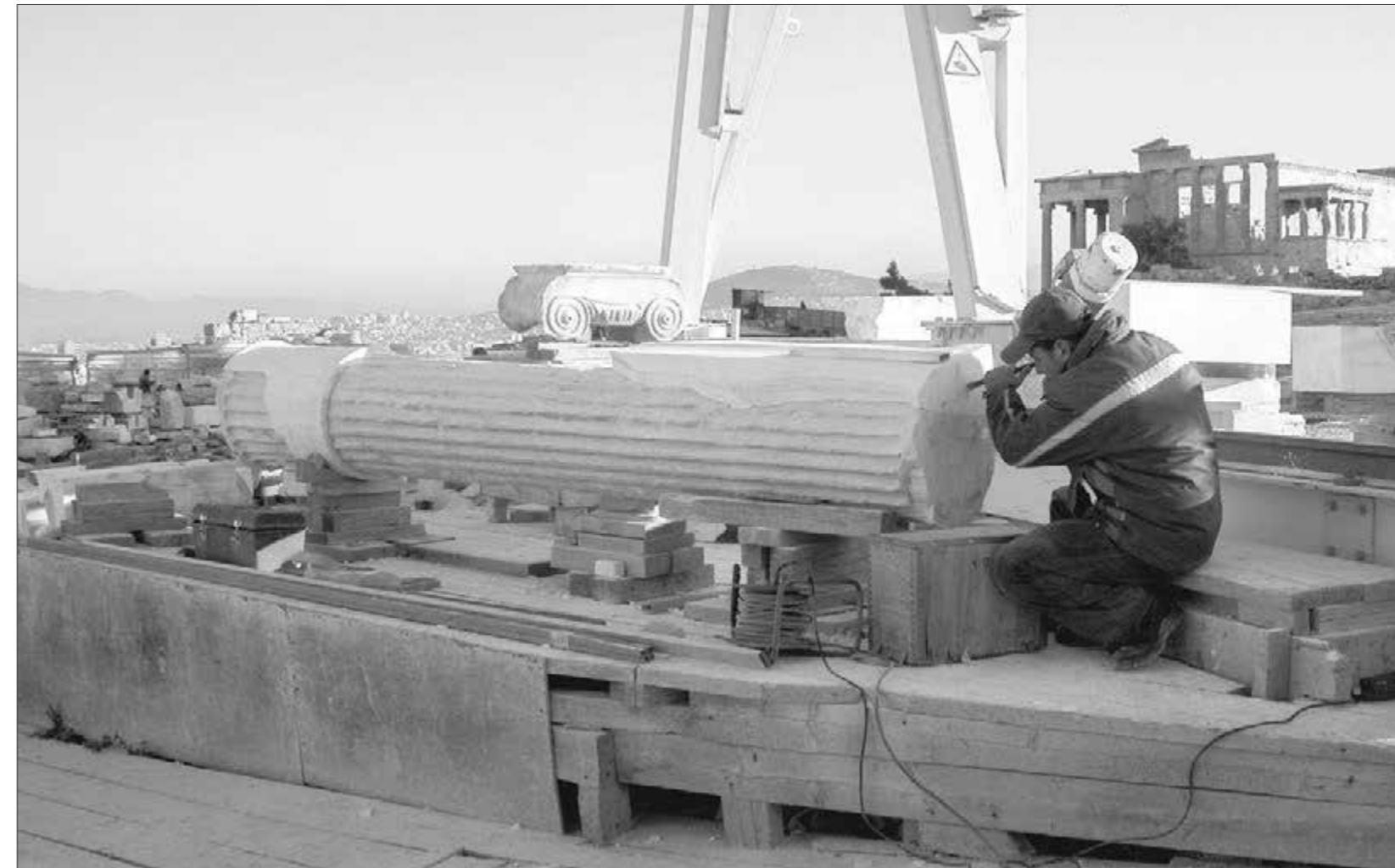
Ναός Αθηνάς Νίκης. Διαμόρφωση συμπληρώματος στον κορμό του νοτιοανατολικού κίονα (2007)
