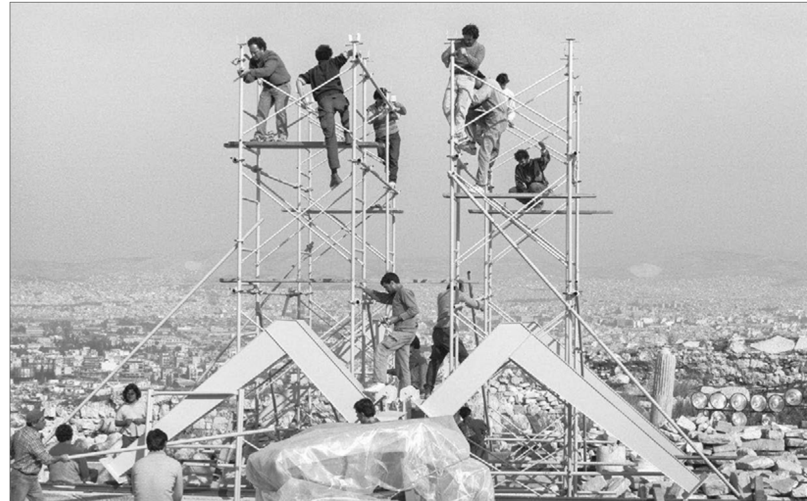
Προπύλαια. Εργασίες συναρμογής γερανογέφυρας εδάφους (1990) The Propylaea. Grounding a crane bridge (1990)
