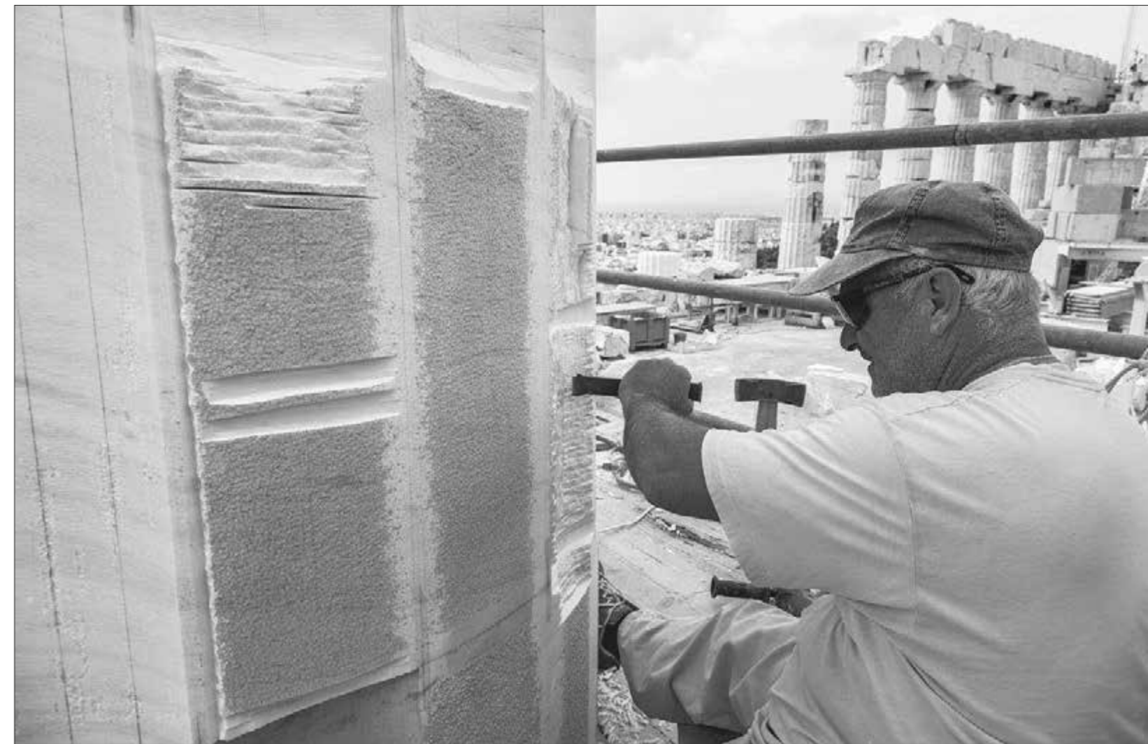
Παρθενώνας. Διαμόρφωση ραβδώσεων σε σπόνδυλο του δεύτερου κίονα του προναού (2014) The Parthenon. Forming flutes on a drum of the second column of the pronaos (2014)
