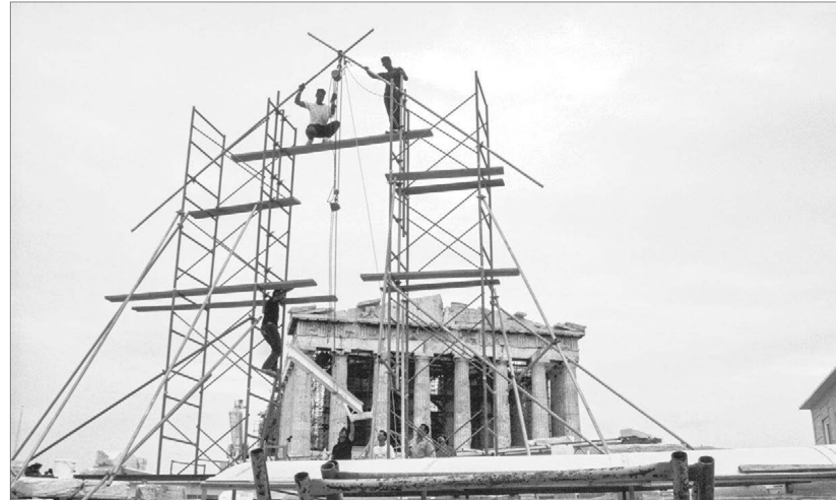
Ναός Αθηνάς Νίκης. Εγκατάσταση γερανογέφυρας τύπου πύλων στο εργοτάξιο (2003)
