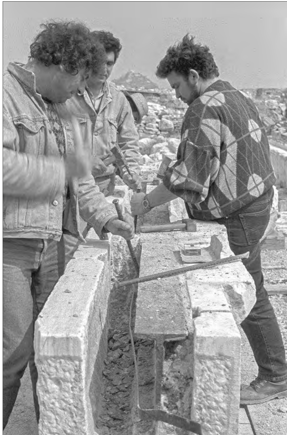
Προπύλαια. Αφαίρεση σιδερένιου οπλισμού της αναστήλωσης Μπαλάνου από λίθο ιωνικού επιστυλίου της δυτικής αίθουσας (1993)
