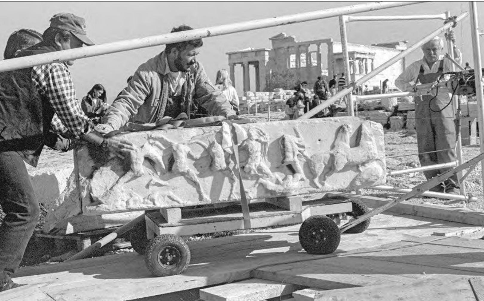
Ναός Αθηνάς Νίκης. Μεταφορά λίθου της ιωνικής ζωφόρου κατά τις εργασίες αποξήλωσης του γλυπτικού διακόσμου του μνημείου, για λόγους προστασίας (1998)
