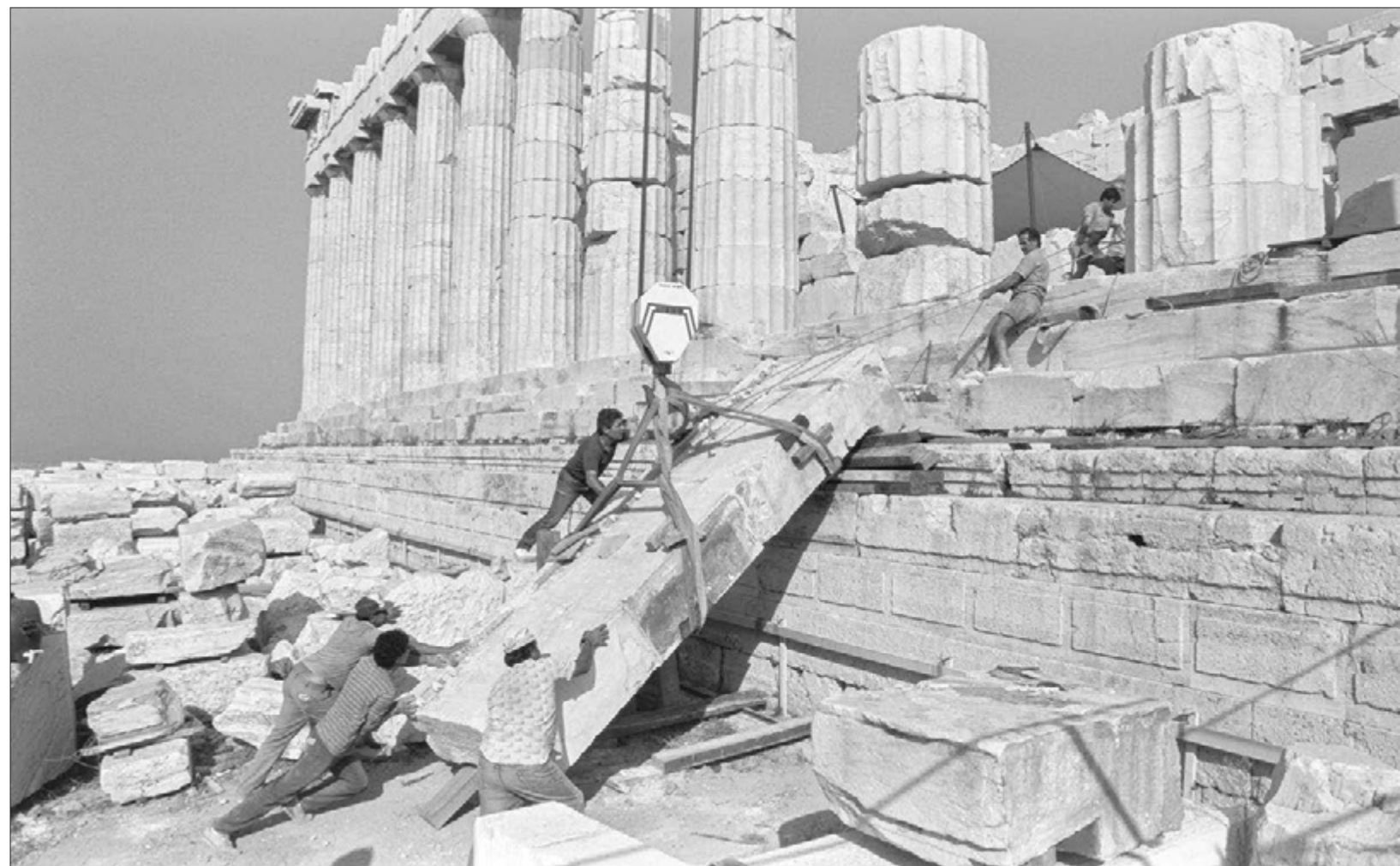
Παρθενώνας. Μεταφορά του βορειοανατολικού εξωτερικού επιστυλίου από τον ναό στο εργοτάξιο (1987)
