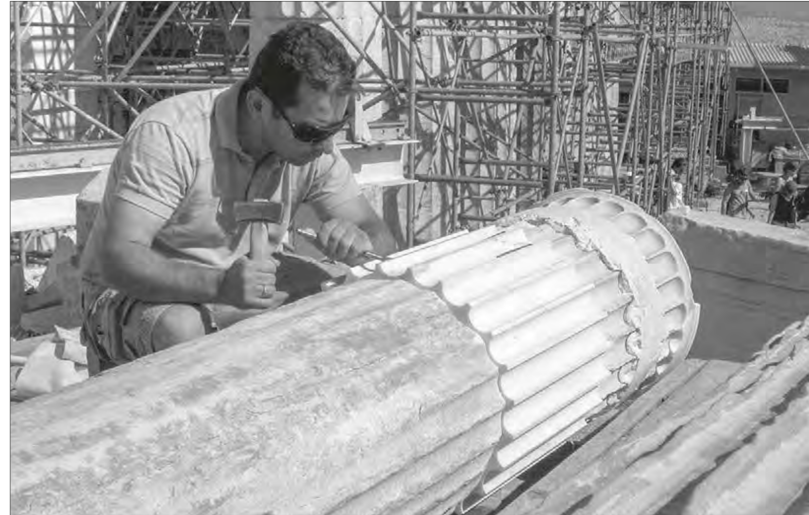
Ναός Αθηνάς Νίκης. Διαμόρφωση ραβδώσεων σε συμπλήρωμα κορμού κίονα της ανατολικής πρόστασης (2008)
