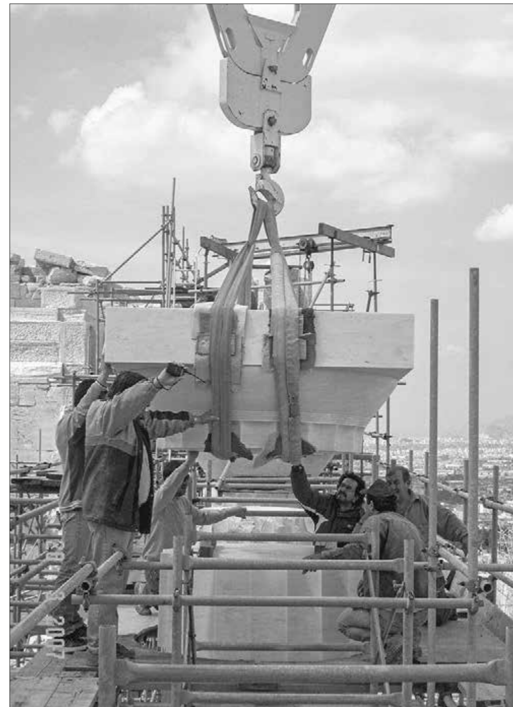
Παρθενώνας. Τοποθέτηση κιονοκράνου στο βόρειο πτερό (2007)
