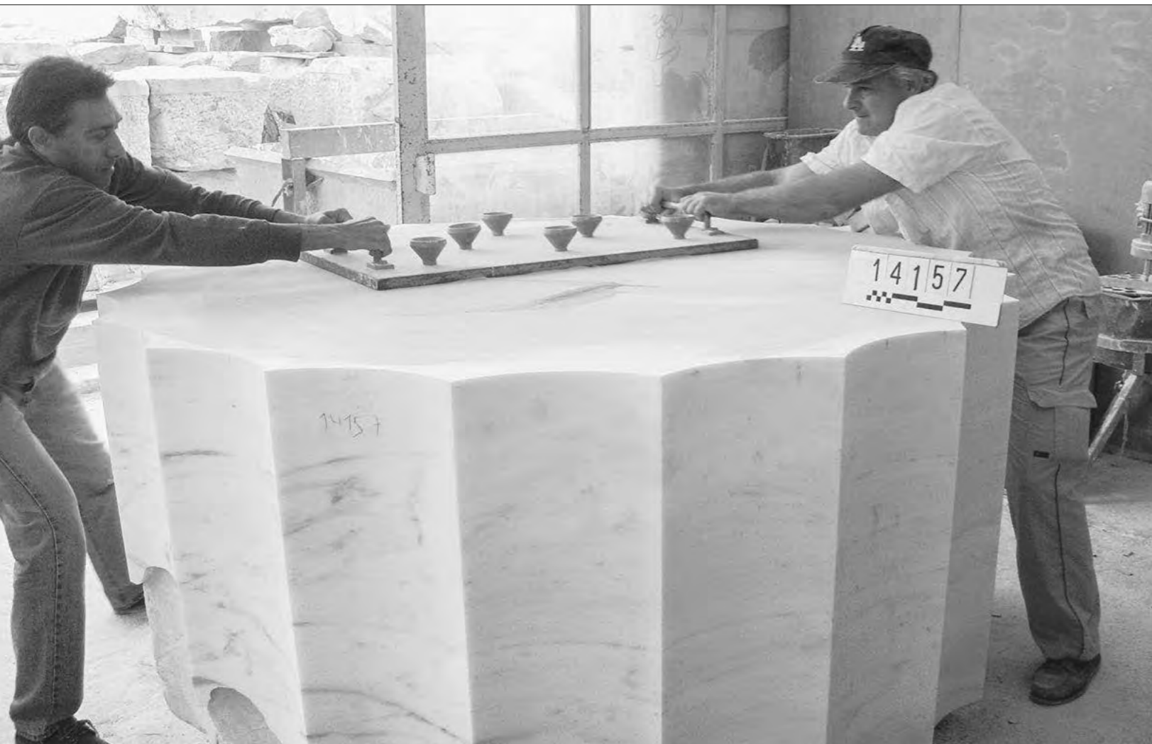
Παρθενώνας. Λείανση έδρας συμπληρώματος σπονδύλου της βόρειας κιονοστοιχίας (2004)
