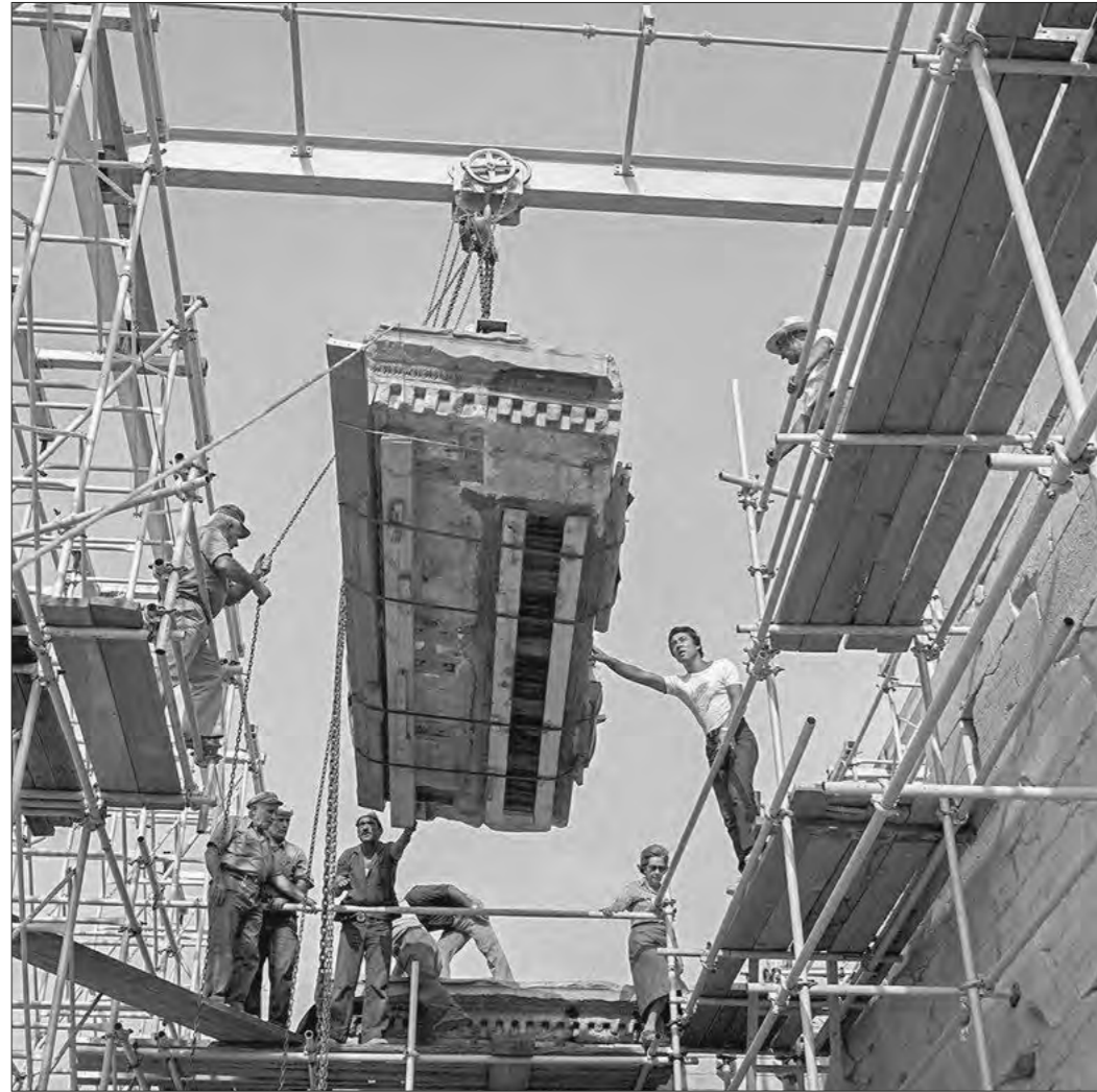
Ερέχθειο. Αποξήλωση φατνωματικής πλάκας από την οροφή της νότιας πρόστασης (1979)
