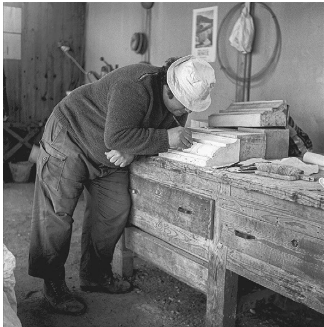
Ερέχθειο. Διαμόρφωση συμπληρώματος κυματίου της επίστεψης του βάθρου της πρόστασης των Κορών στο εργαστήριο (1980)
