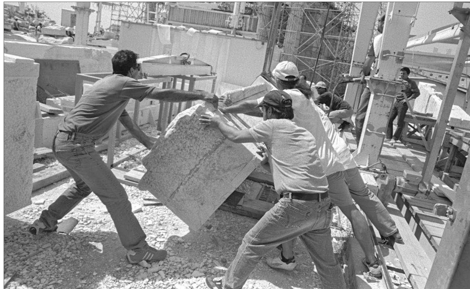
Προπύλαια. Ανατροπή δοκού της ανατολικής πρόστασης κατά τη μεταφορά της στον κόφτη μαρμάρου για την επεξεργασία του συμπληρώματος από νέο μάρμαρο (2009)
