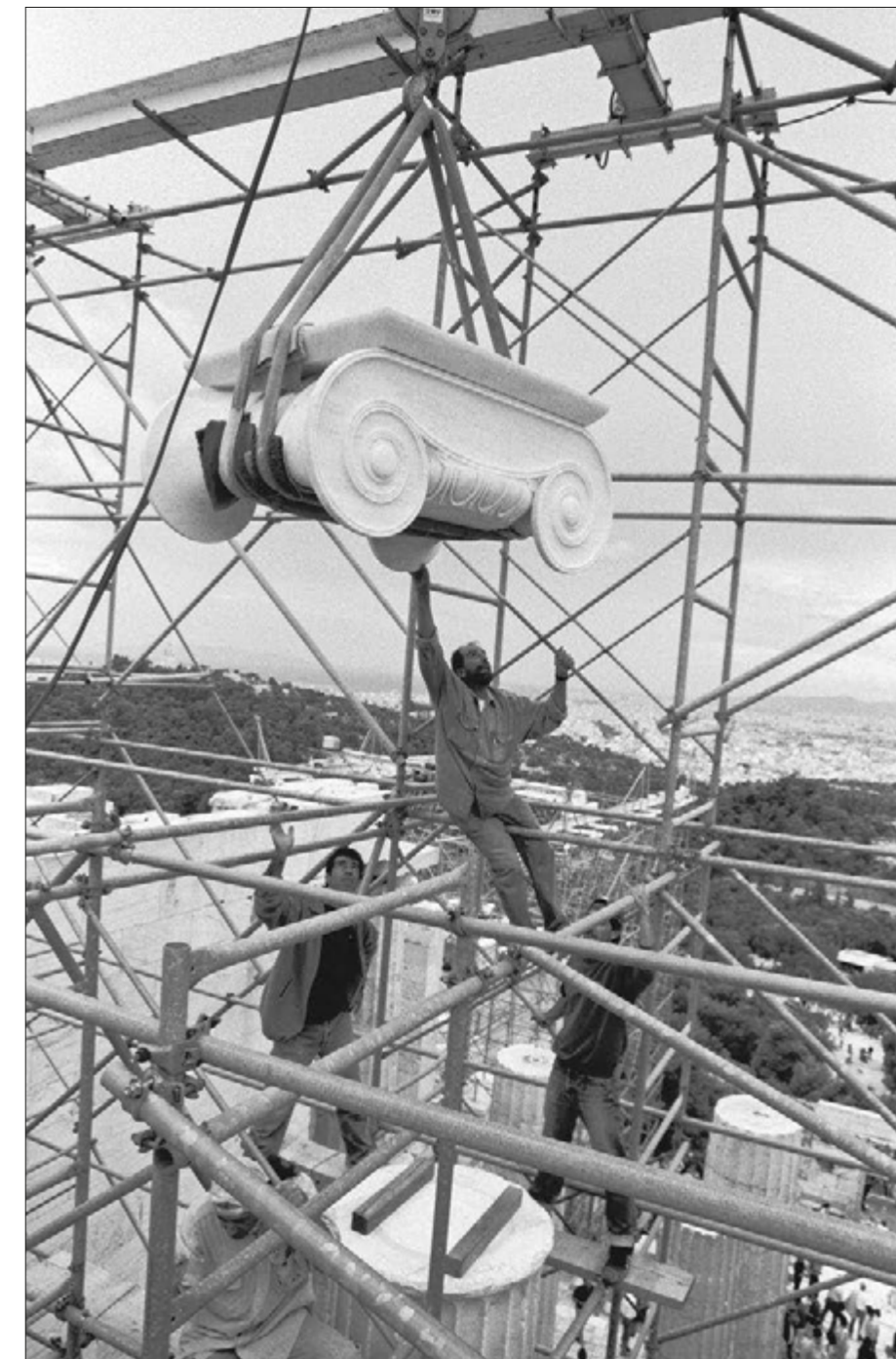
Προπύλαια. Τοποθέτηση αντιγράφου ιωνικού κιονοκράνου στη δυτική αίθουσα (2006)
