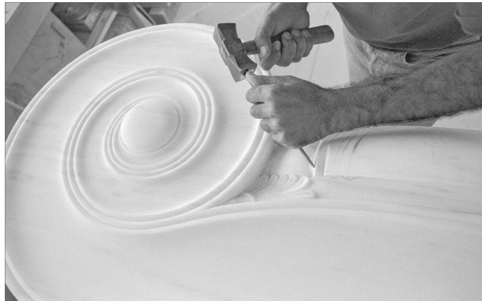
Προπύλαια. Διαμόρφωση γλυπτικού διακόσμου στον εχίνο του αντιγράφου του ιωνικού κιονοκράνου (2005) The Propylaea. Carving sculptural ornaments on the echinus of the Ionic column-capital copy (2005)
