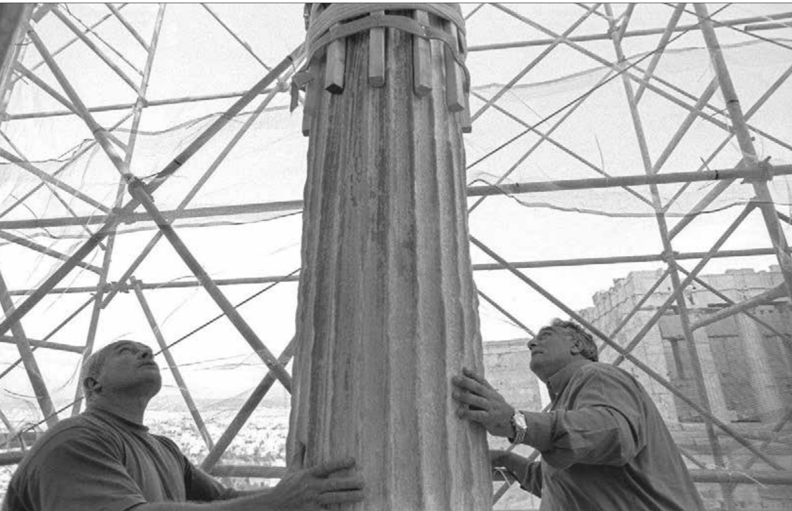
Ναός Αθηνάς Νίκης. Μεταφορά του κορμού του νοτιοδυτικού κίονα για την τοποθέτησή του στην οριστική του θέση (2008)
