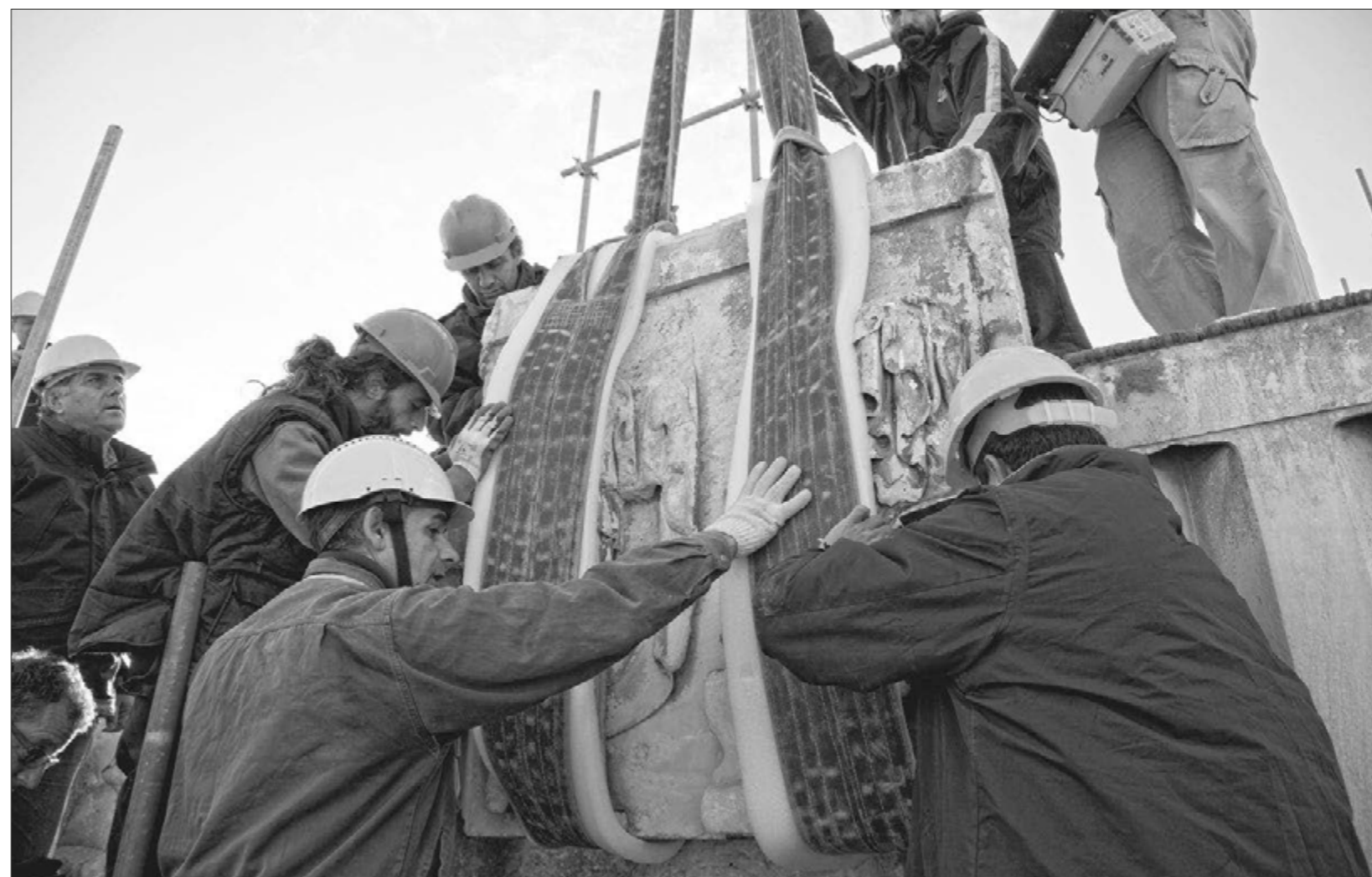
Παρθενώνας. Απομάκρυνση της τελευταίας βόρειας μετόπης από τον ναό για λόγους προστασίας (2011)
