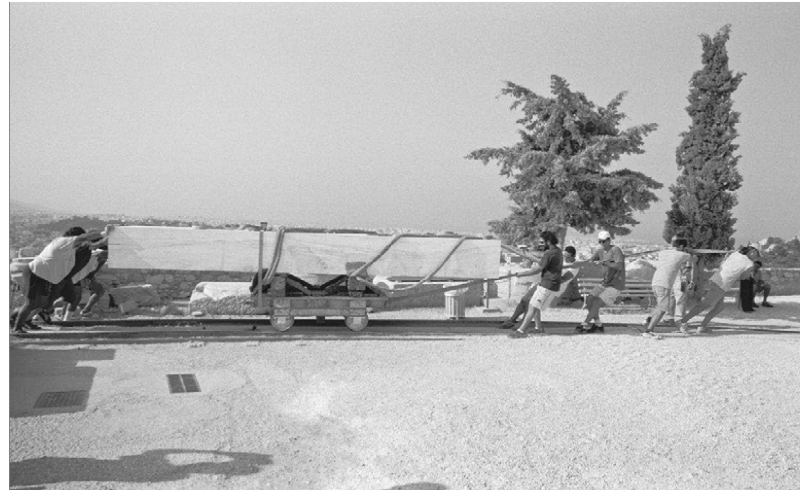
Προπύλαια. Μεταφορά όγκου νέου μαρμάρου από το αναβατόριο στο εργοτάξιο, για την κατασκευή δοκού του κεντρικού κτηρίου (2006)
