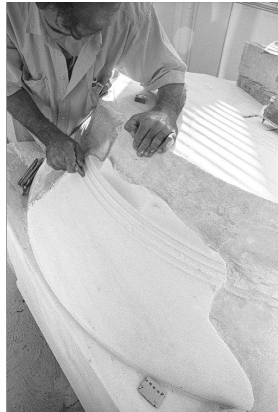
Προπύλαια. Διαμόρφωση ιμάντων σε συμπλήρωμα δωρικού κιονοκράνου της ανατολικής πρόστασης (2003)
