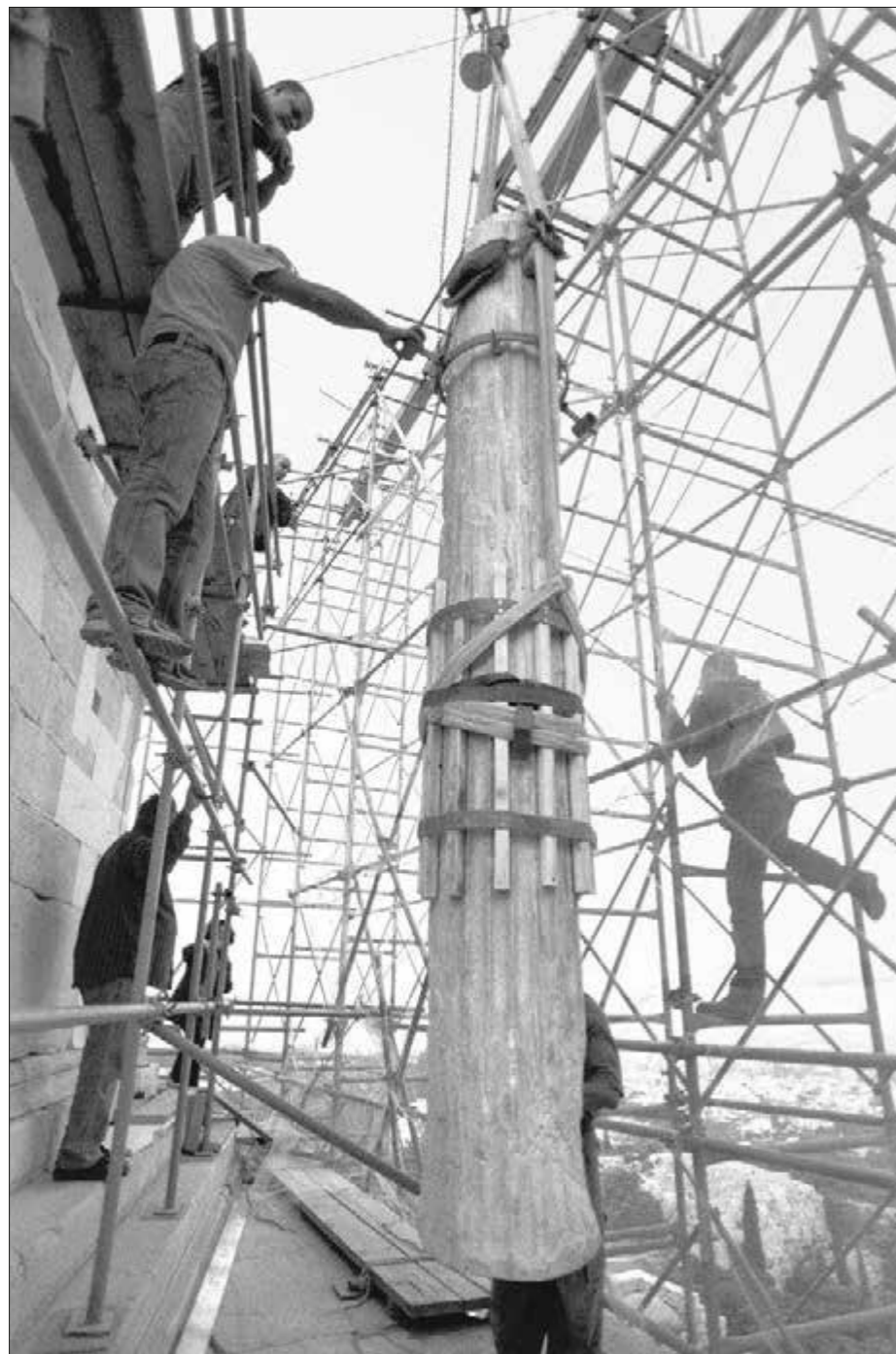
Ναός Αθηνάς Νίκης. Μεταφορά κορμού κίονα της δυτικής πρόστασης για την τοποθέτησή του στην οριστική του θέση (2008)
