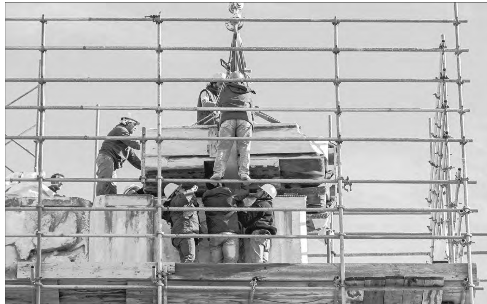
Παρθενώνας. Αποσυναρμολόγηση του νοτιοδυτικού γείσου (2012)
