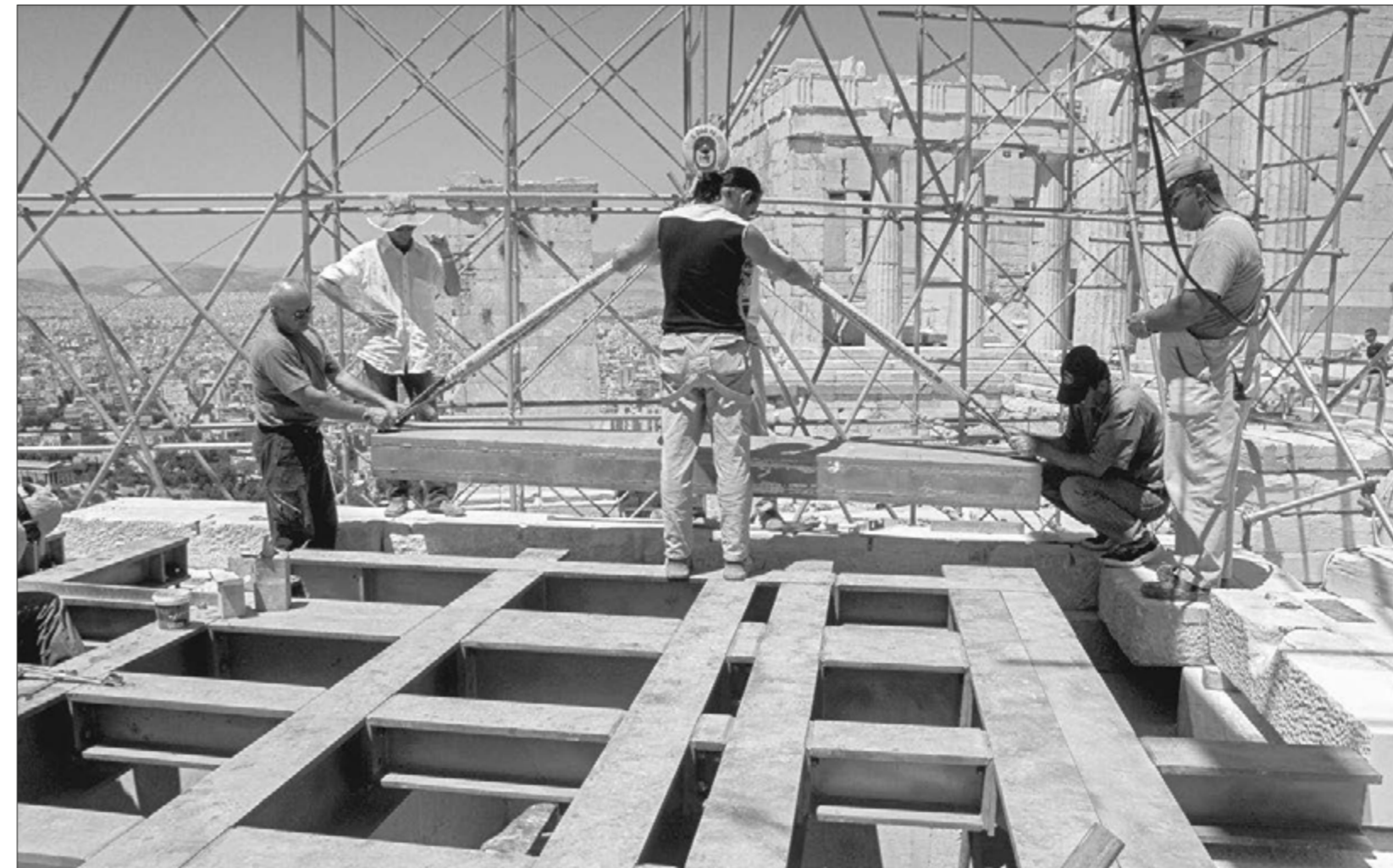
Ναός Αθηνάς Νίκης. Εγκατάσταση εσχάρας από ανοξείδωτο χάλυβα που αντικατέστησε τη φέρουσα κατασκευή της επέμβασης Μπαλάνου κατά τη νέα αναστήλωση του ναού (2004)
