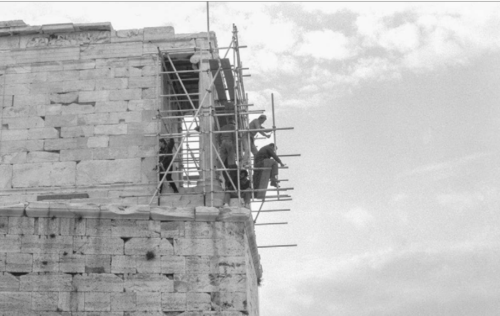
Ναός Αθηνάς Νίκης. Εγκατάσταση ικρίωματος στη δυτική πρόσταση για τις εργασίες αποτύπωσης του μνημείου (1990) The Temple of Athena Nike. Installing scaffoldings at the west porch to assist the works of the monument's plotting (1990)
