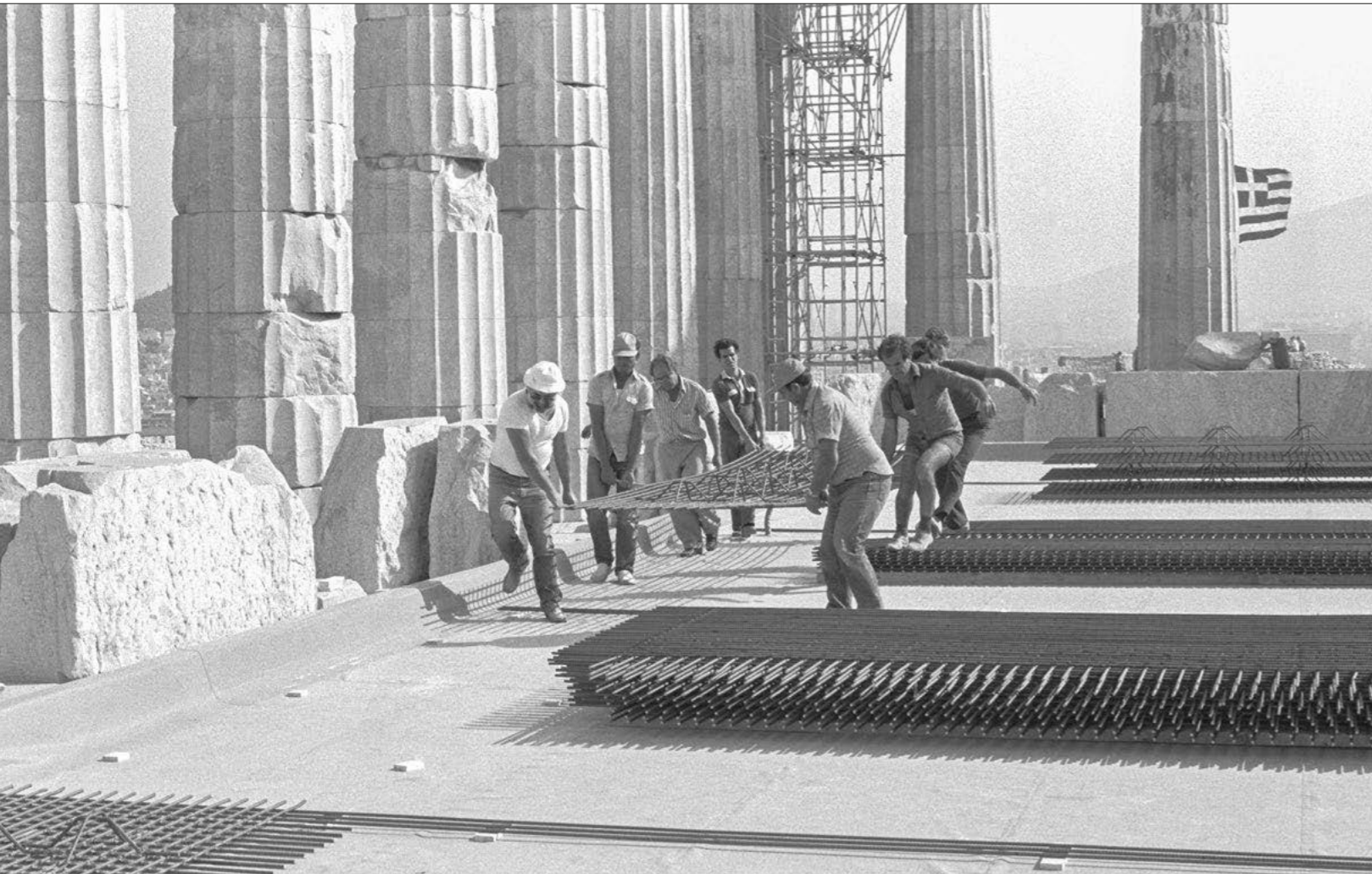
Παρθενώνας. Μεταφορά οπλισμού για την κατασκευή προστατευτικού δαπέδου (1985) The Parthenon. Moving reinforcement material for the construction of a protective floor (1985)
