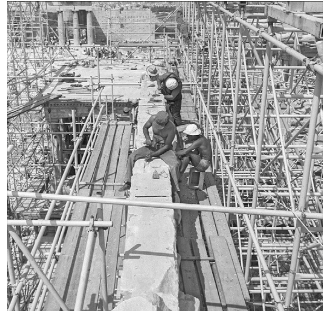
Ερέχθειο. Αφαίρεση συνδετηρίων της αναστήλωσης Μπαλάνου από λίθο επικρανίτιδας του νοτίου τοίχου (1979)
