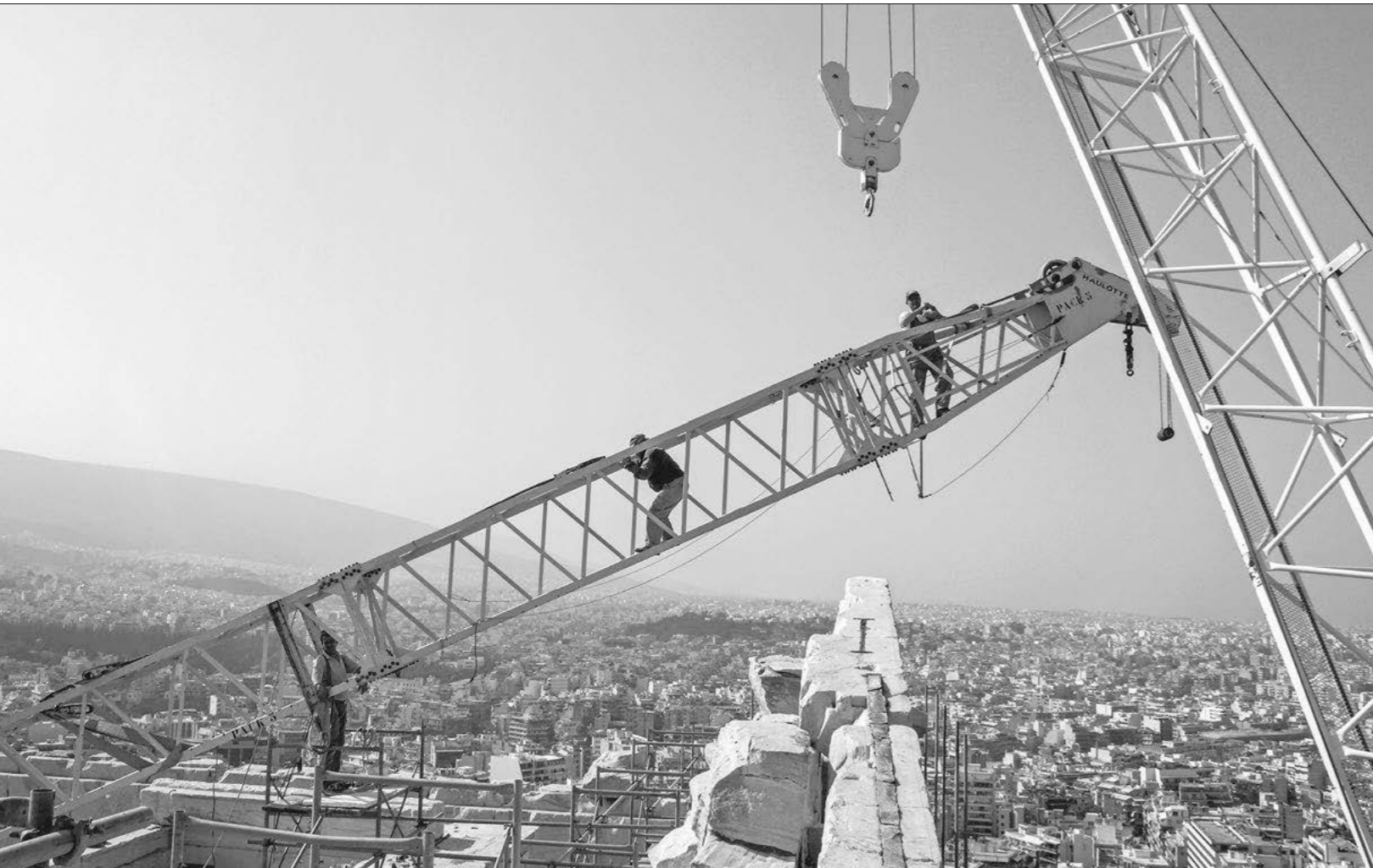
Παρθενώνας. Επισκευή της μπούμας του γερανού Derrick (2011) The Parthenon. Repairing the Derrick crane boom (2011)
