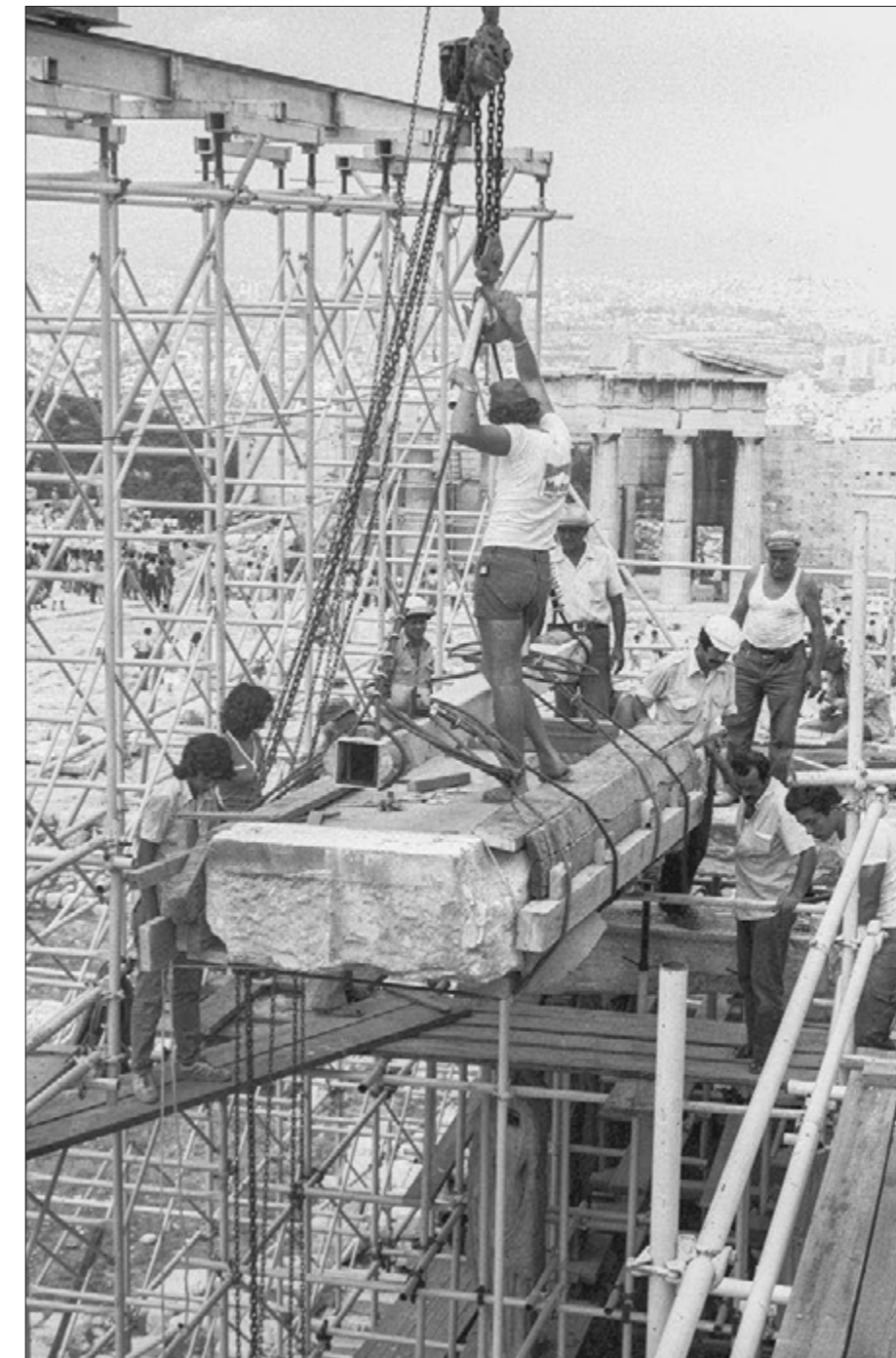
Ερέχθειο. Αποξήλωση φατνωματικής πλάκας από τη νότια πρόσταση (1979)
