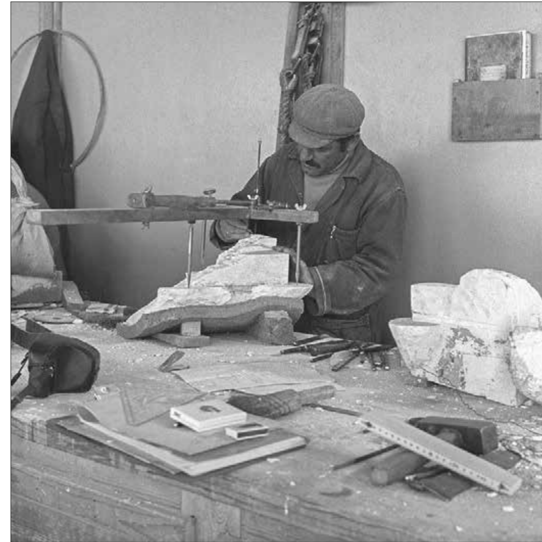
Ερέχθειο. Αντιγραφή εκμαγείου με χρήση πονταδόρου για την κατασκευή συμπληρώματος αρχιτεκτονικού μέλους (1980)
