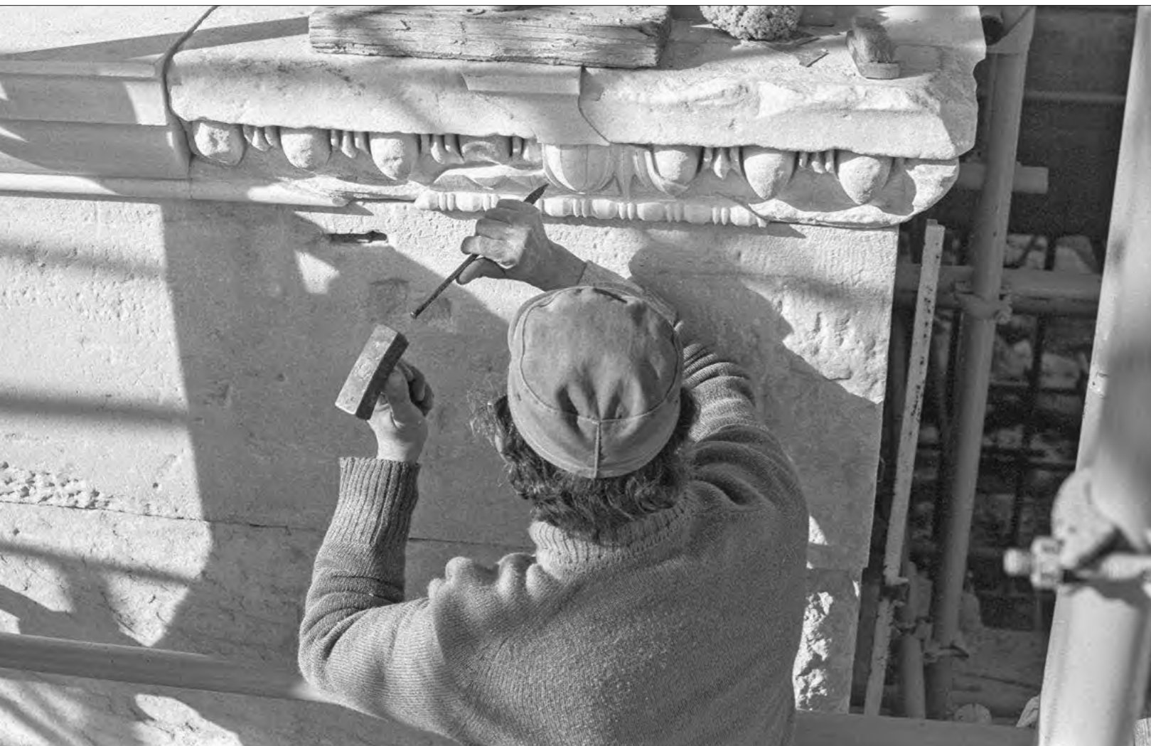
Ερέχθειο. Διαμόρφωση συμπληρώματος κυματίου στην επίστεψη του βάθρου της πρόστασης των Κορών (1981)
