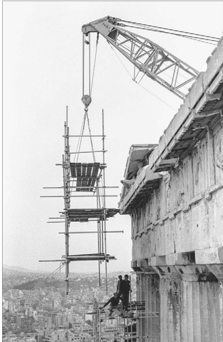
Παρθενώνας. Αφαίρεση ικριωμάτων από την νοτιοανατολική γωνία (1986)
