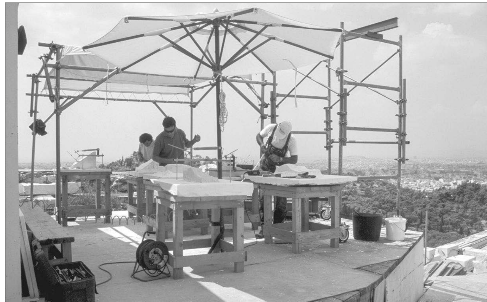
Ναός Αθηνάς Νίκης. Αντιγραφή εκμαγείων με χρήση πονταδόρου για τη διαμόρφωση συμπληρωμάτων λίθων (2002)
