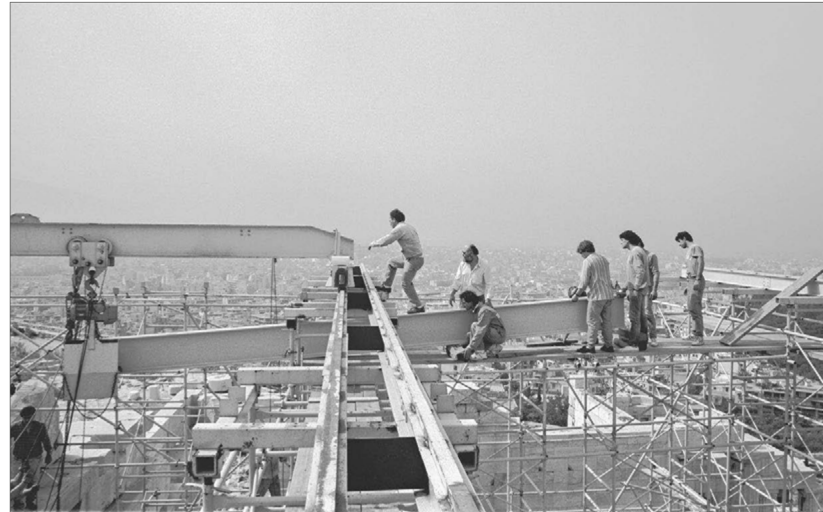
Προπύλαια. Ανάρτηση κεντρικού φορέα γερανογέφυρας για την επέμβαση στη δυτική αίθουσα (1991) The Propylaea. Lifting the central carrier of a crane bridge for the intervention in the west hall (1991)
