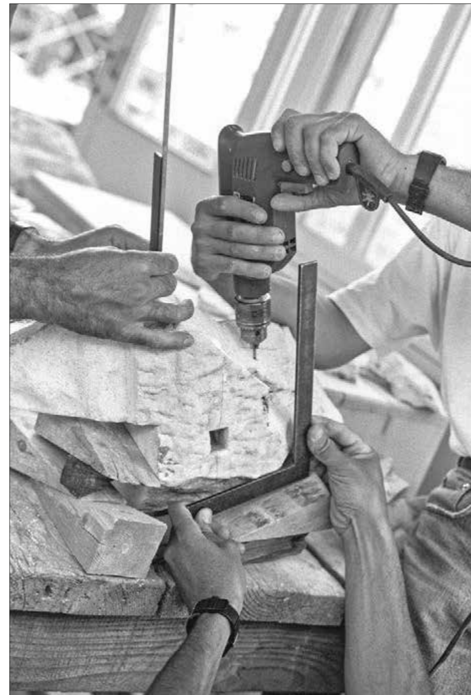
Προπύλαια. Διάτρηση θραύσματος φατνωματικής πλάκας για τη στερέωση μικρών θραυσμάτων με καρφίδες τιτανίου (1993)
