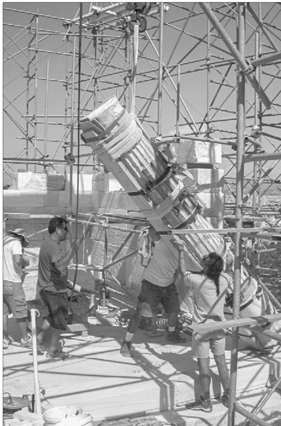
Ναός Αθηνάς Νίκης. Μεταφορά του κορμού του νοτιοανατολικού κίονα, κατά τις εργασίες αποκατάστασης (2006)
