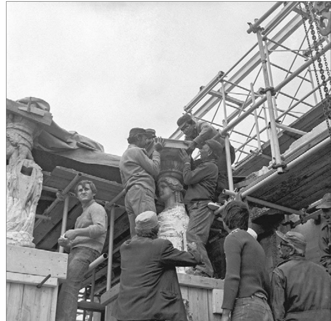
Ερέχθειο. Αφαίρεση άβακα από την 6 η Κόρη της νότιας πρόστασης, πριν τη μεταφορά της στο Μουσείο Ακροπόλεως (1979)
