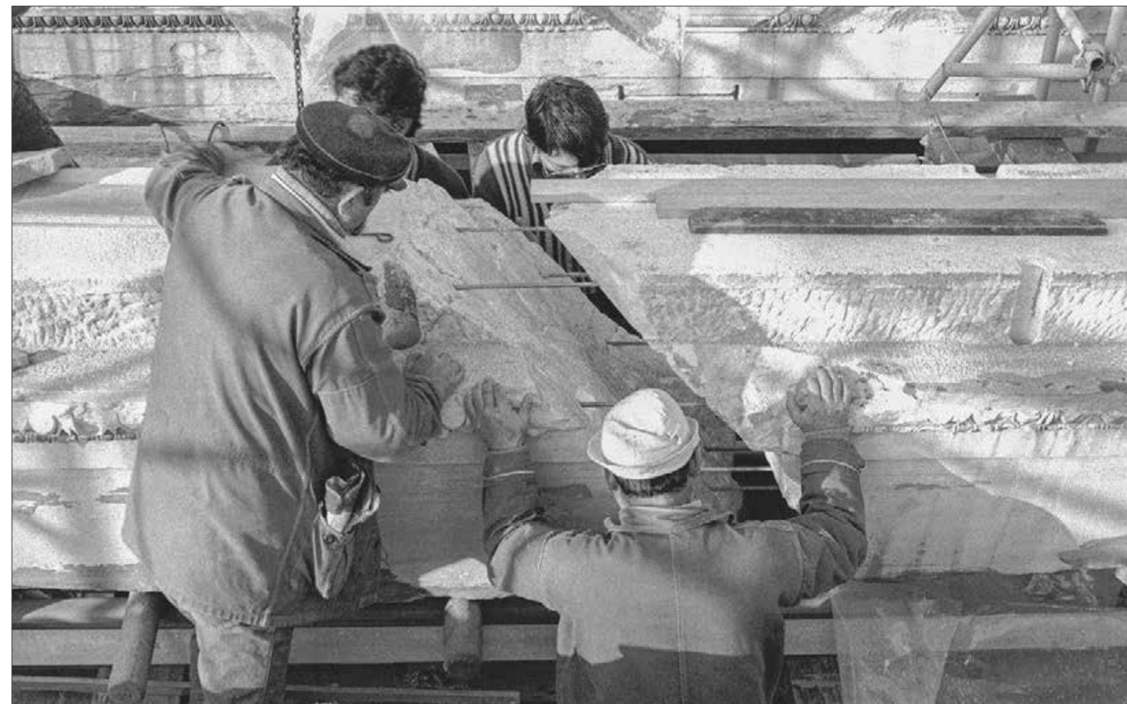
Ερέχθειο. Συγκόλληση δύο θραυσμάτων δοκού της οροφής της βόρειας πρόστασης (1982)
