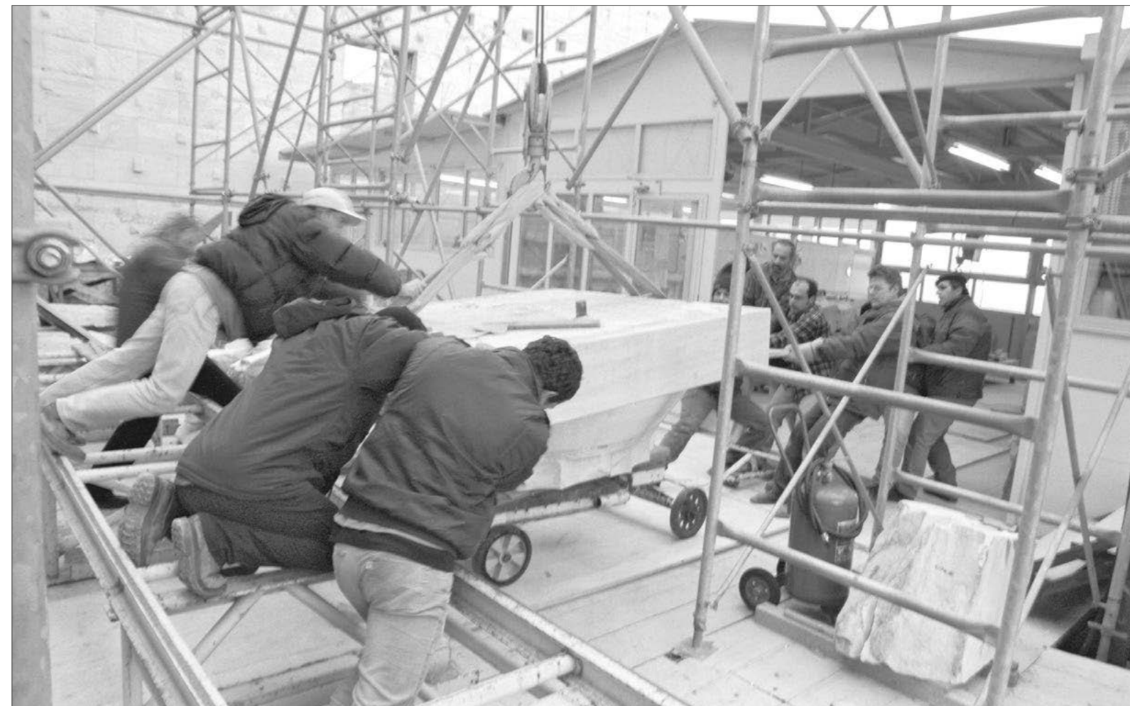
Προπύλαια. Μεταφορά κιονοκράνου της ανατολικής πρόστασης στο εργαστήριο, για την αποκατάστασή του (2003)
