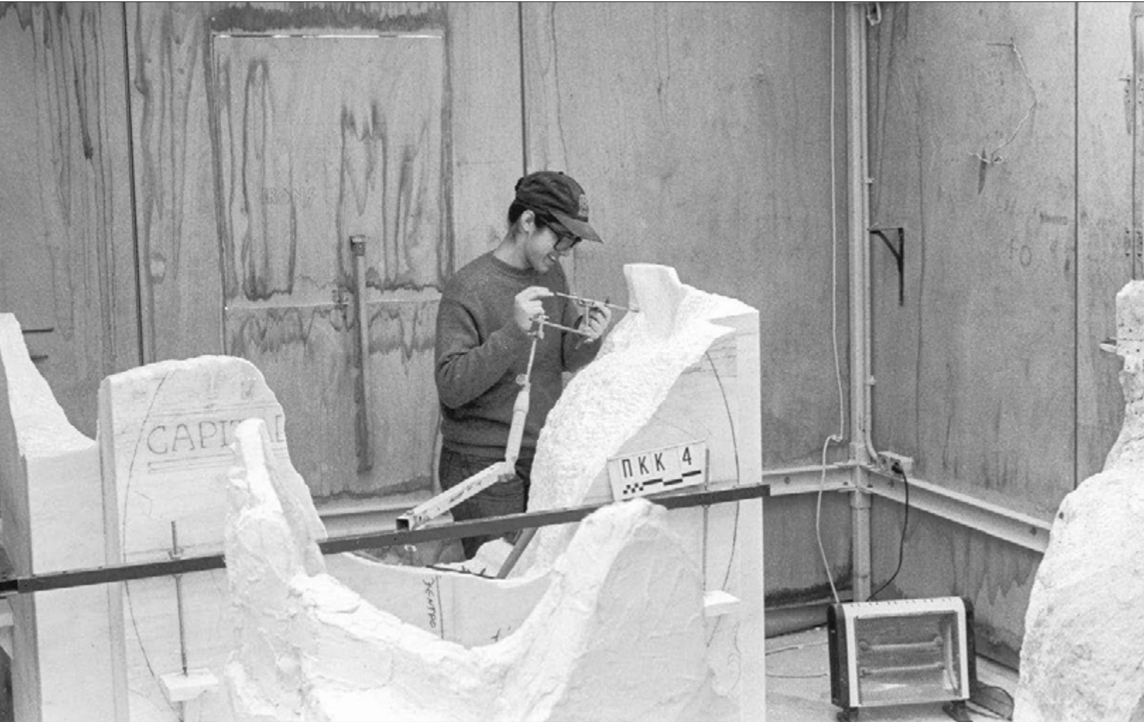
Παρθενώνας. Διαμόρφωση συμπληρώματος κιονοκράνου του προνάου με χρήση πονταδόρου (2001) The Parthenon. Shaping a column-capital filling from the pronaos with the use of a pointing device (2001)
