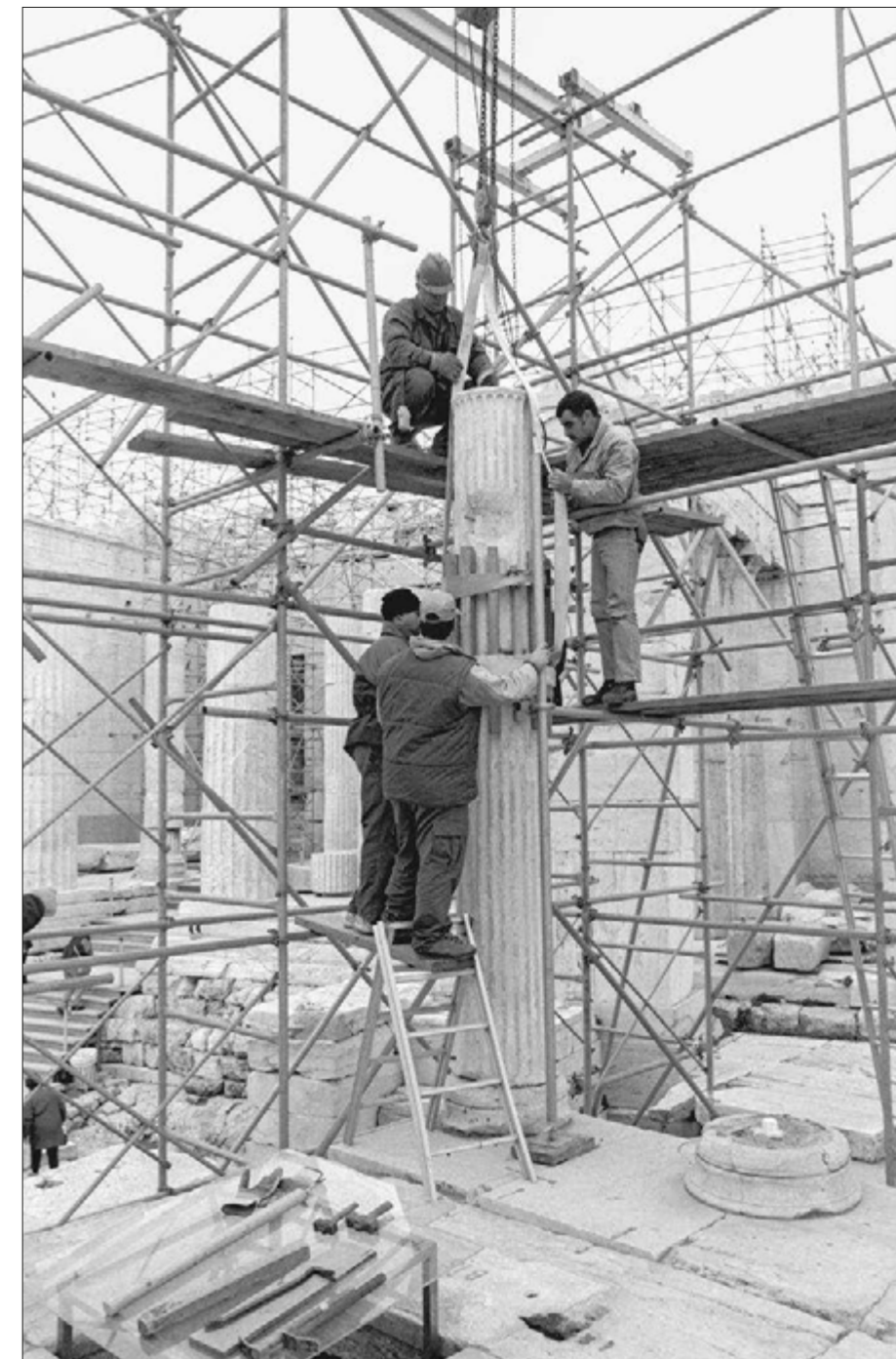
Ναός Αθηνάς Νίκης. Προετοιμασία αποξήλωσης του βορειοανατολικού κίονα (2002)
