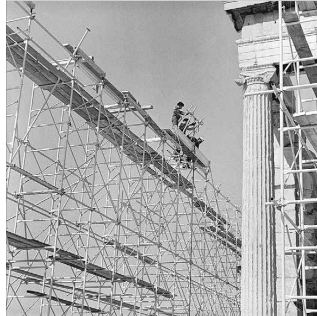
Ερέχθειο. Ανύψωση στοιχείων γερανογέφυρας με χρήση χειροκίνητου βαρούλκου, για την επέμβαση στον νότιο τοίχο (1979)
