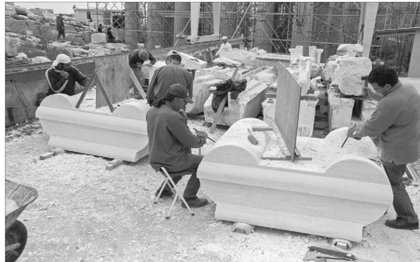
Προπύλαια. «Ξεχόντρισμα» των όγκων από νέο μαρμάρο στους οποίους λαξεύτηκαν τα δύο αντίγραφα ιωνικού κιονοκράνου (2002)
