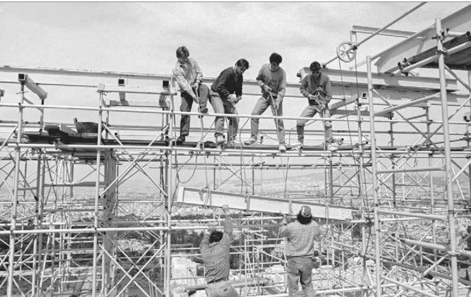
Προπύλαια. Αναβίβαση δοκού γερανογέφυρας για την εξυπηρέτηση των εργασιών αποκατάστασης του κεντρικού κτηρίου (1991)
