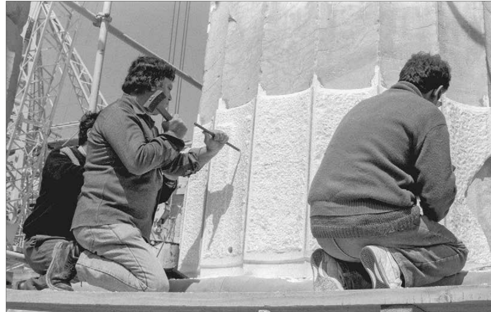
Παρθενώνας. Κατεργασία συμπληρώματος στον πρώτο σπόνδυλο του πέμπτου κίονα του νότιου πτερού (1993)
