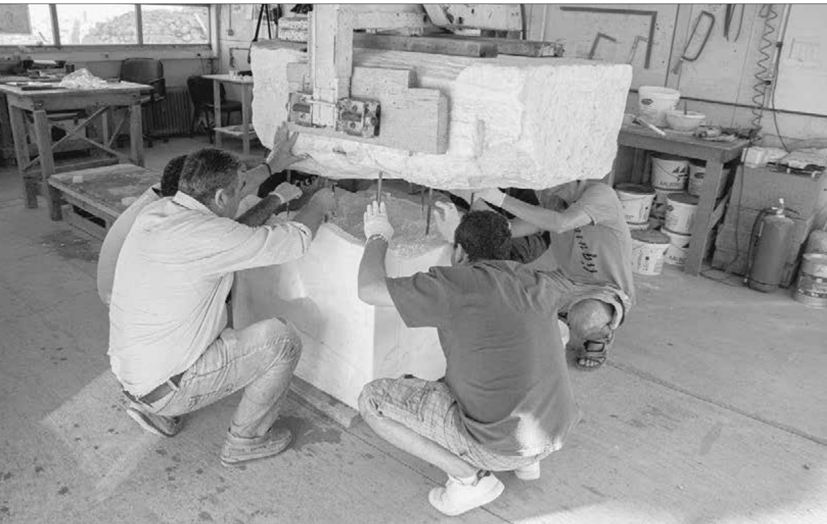
Προπύλαια. Συγκόλληση νέου συμπληρώματος σε αντίθημα επιστυλίου της βορειοδυτικής γωνίας του κεντρικού κτηρίου (2012)
