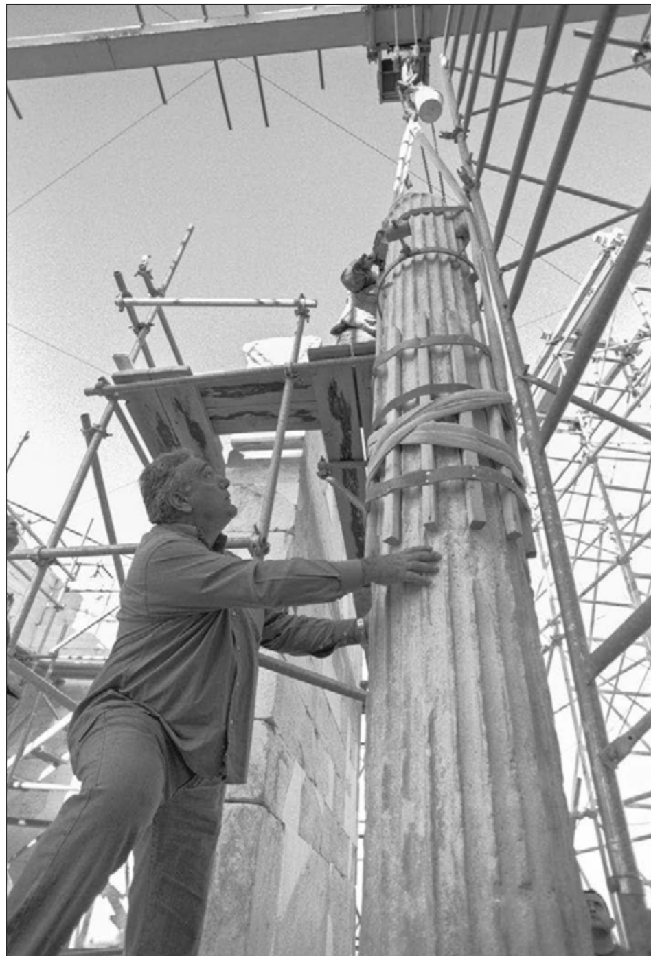
Ναός Αθηνάς Νίκης. Μεταφορά του κορμού του νοτιοδυτικού κίονα για την τοποθέτησή του στην οριστική του θέση (2008)
