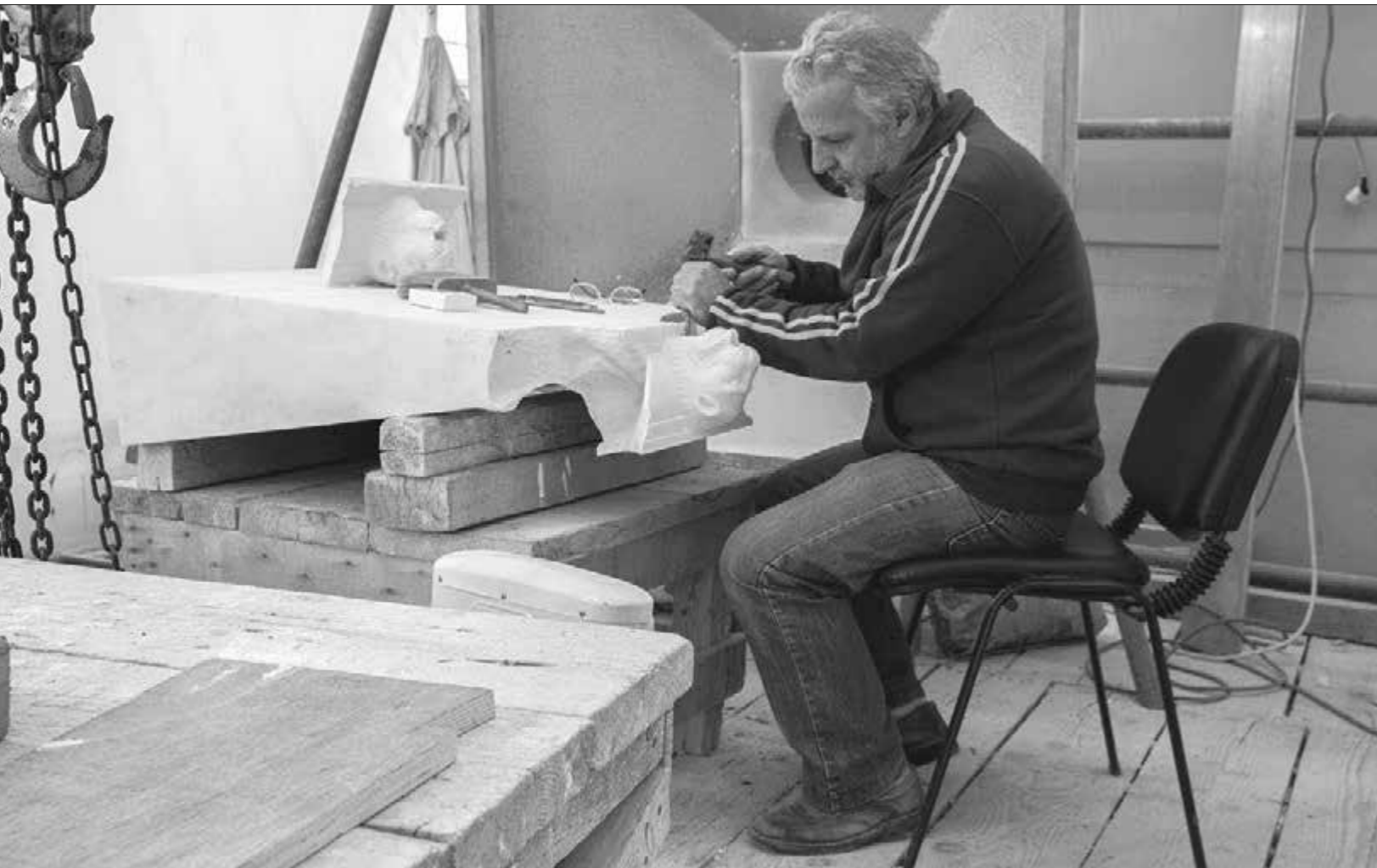
Ναός Αθηνάς Νίκης. Τελική επεξεργασία αντιγράφου λεοντοκεφαλής υδρορρόης σε λίθο πλευρικής σίμης της στέγης (2009)
