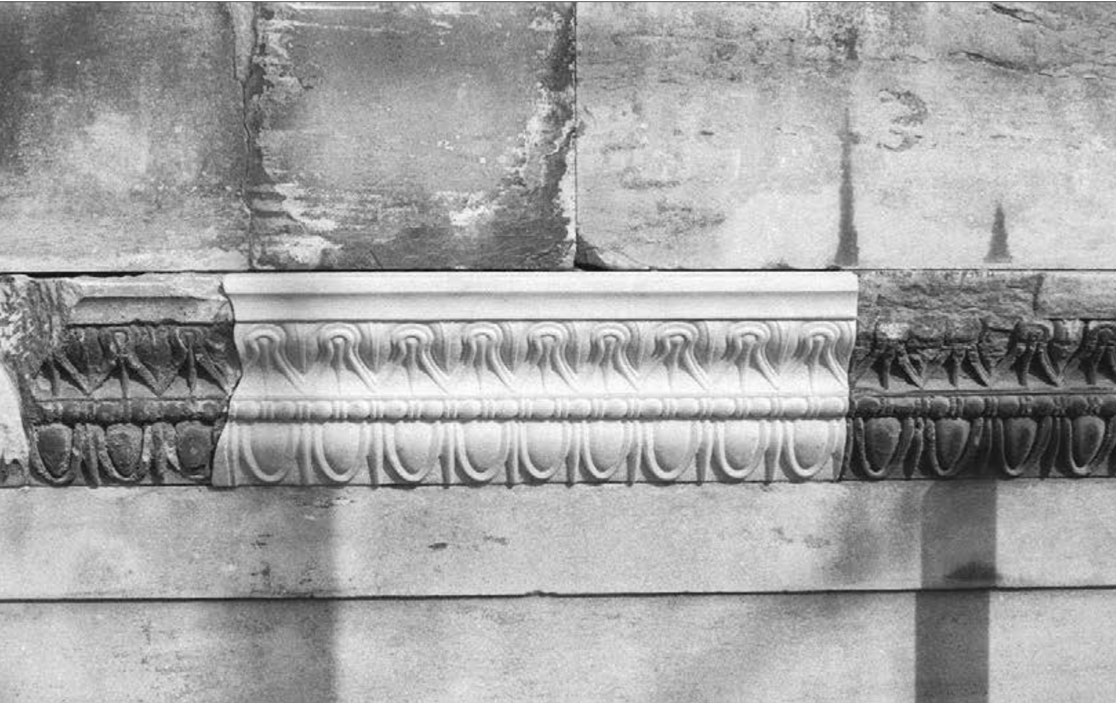
Ερέχθειο. Συμπλήρωση κυματίου σε λίθο επικρανίτιδας της νότιας πρόστασης (1980)
