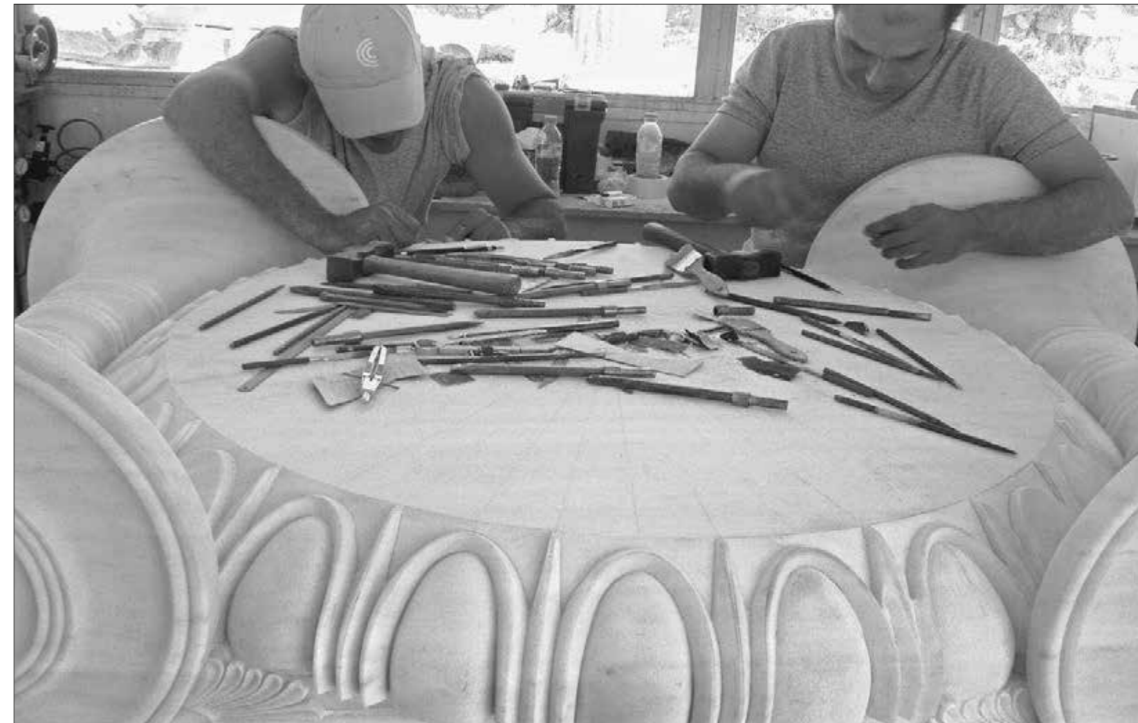
Προπύλαια. Τελική επεξεργασία αντιγράφου του ιωνικού κιονοκράνου (2006) The Propylaea. Final treating of the copy of the Ionic column-capital (2006)
