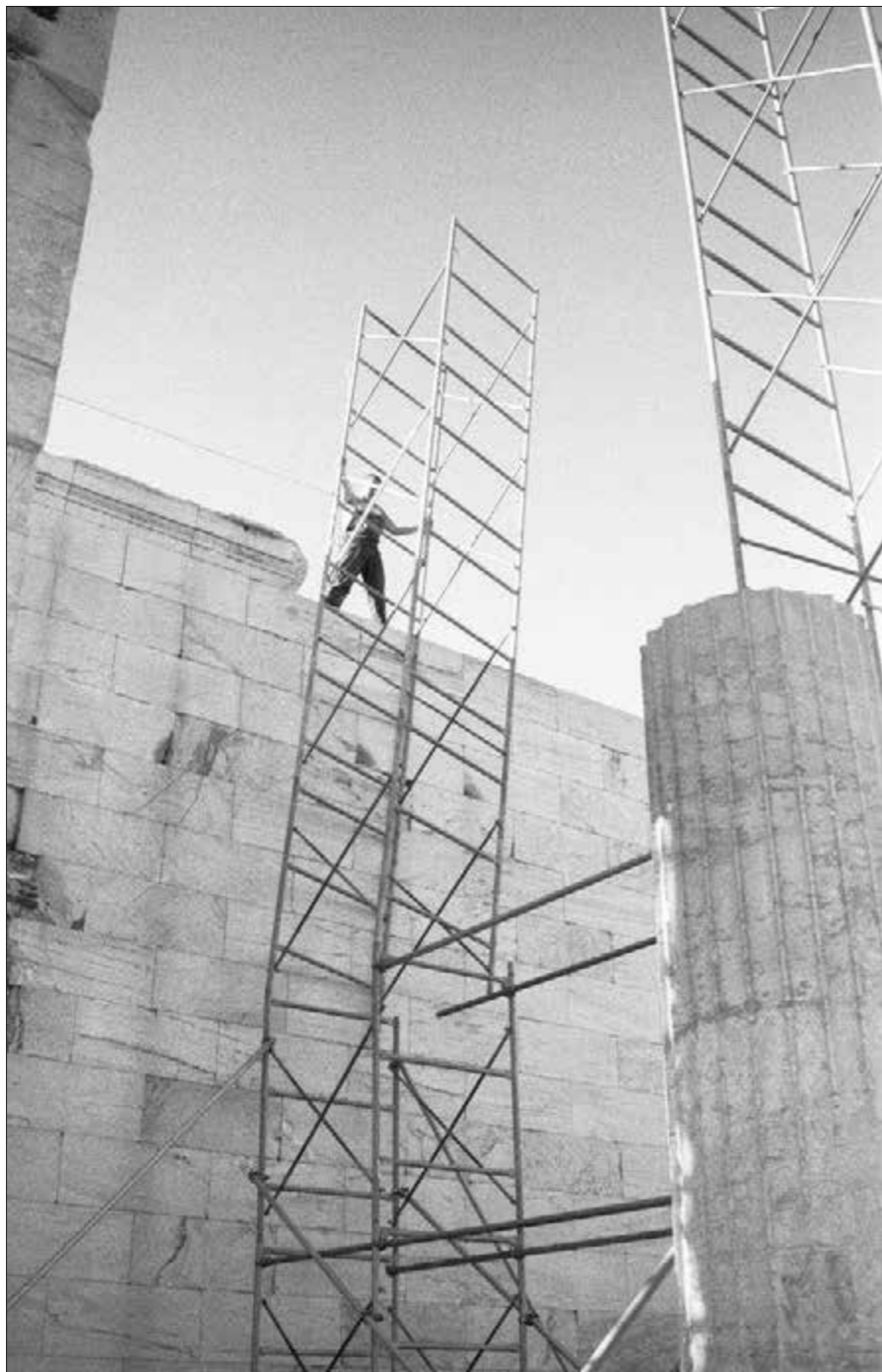
Προπύλαια. Εγκατάσταση ικριωμάτων για την επέμβαση στο κεντρικό κτήριο (2001)
