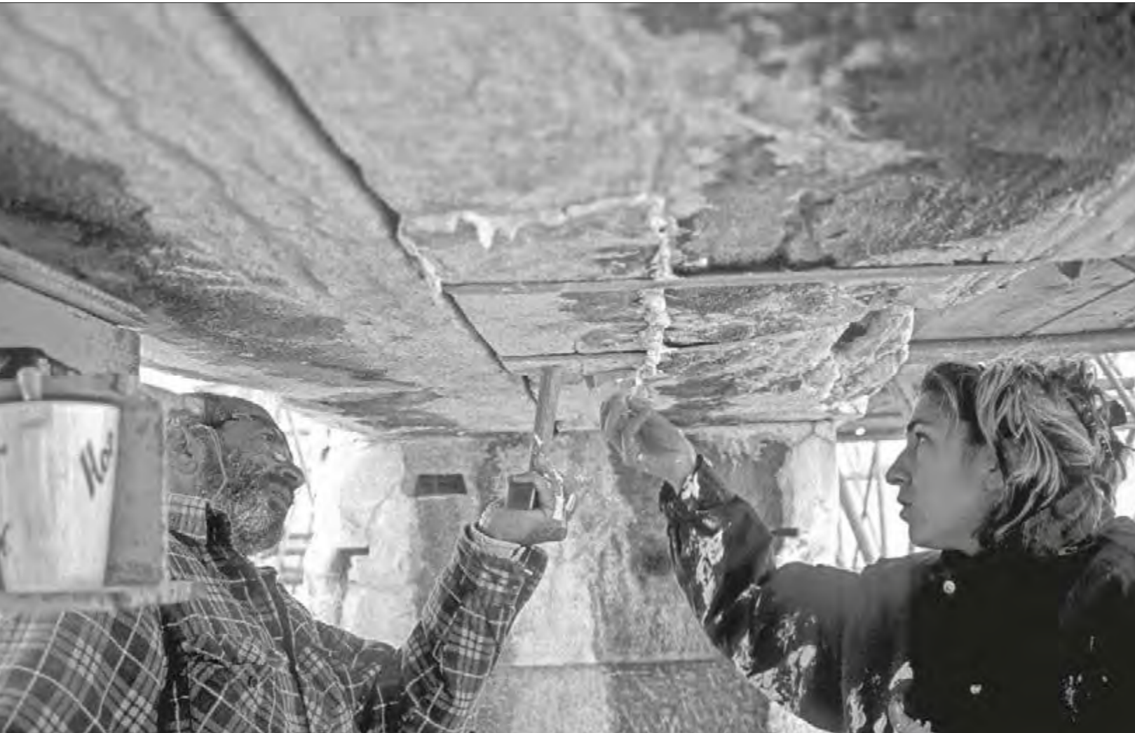
Προπύλαια. Συγκόλληση μικρών θραυσμάτων σε λίθο του κεντρικού υπερθύρου (2006) The Propylaea. Binding small fragments on a lintel block of the central doorway (2006)
