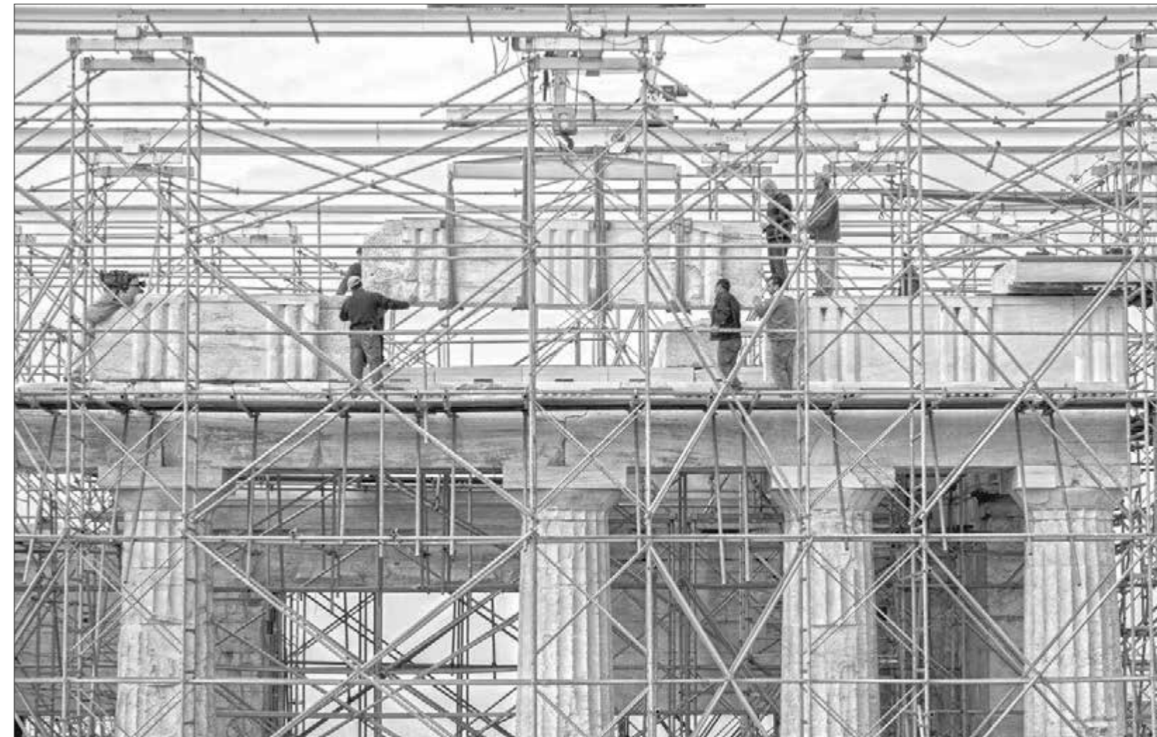
Προπύλαια. Ανατοποθέτηση λίθου ζωφόρου στην ανατολική πρόσταση, μετά την αποκατάστασή του (2008)
