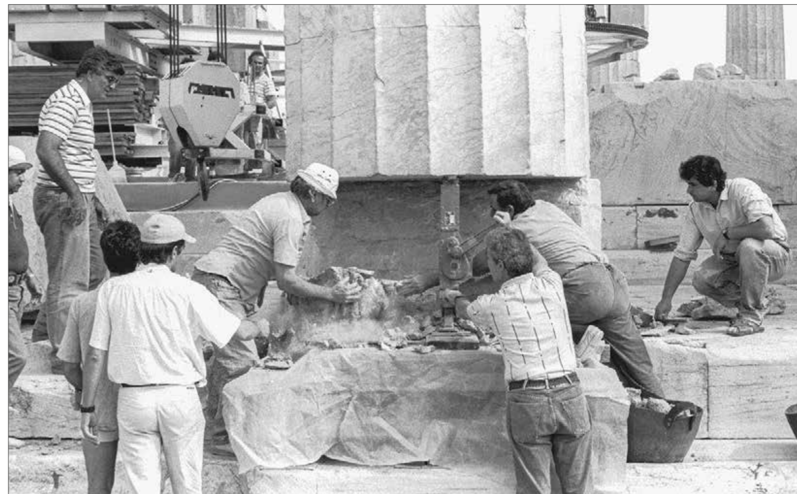
Παρθενώνας. Αφαίρεση υλικού παλαιότερης επέμβασης από τον πρώτο σπόνδυλο του πέμπτου κίονα του νότιου πτερού (1991)
