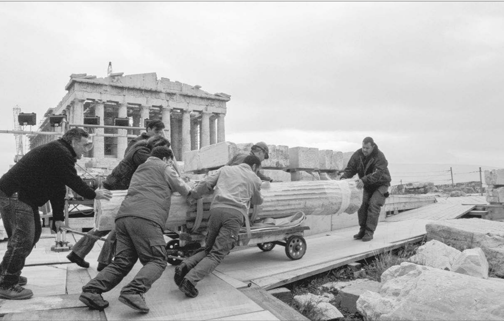
Ναός Αθηνάς Νίκης. Μεταφορά κορμού κίονα της δυτικής πρόστασης στο εργοτάξιο για τη συντήρησή του (2002)
