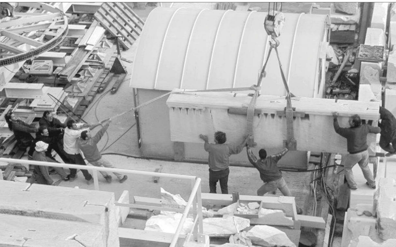
Παρθενώνας. Μεταφορά επιστυλίου του οπισθοναού στον σηκό του ναού (2001)
