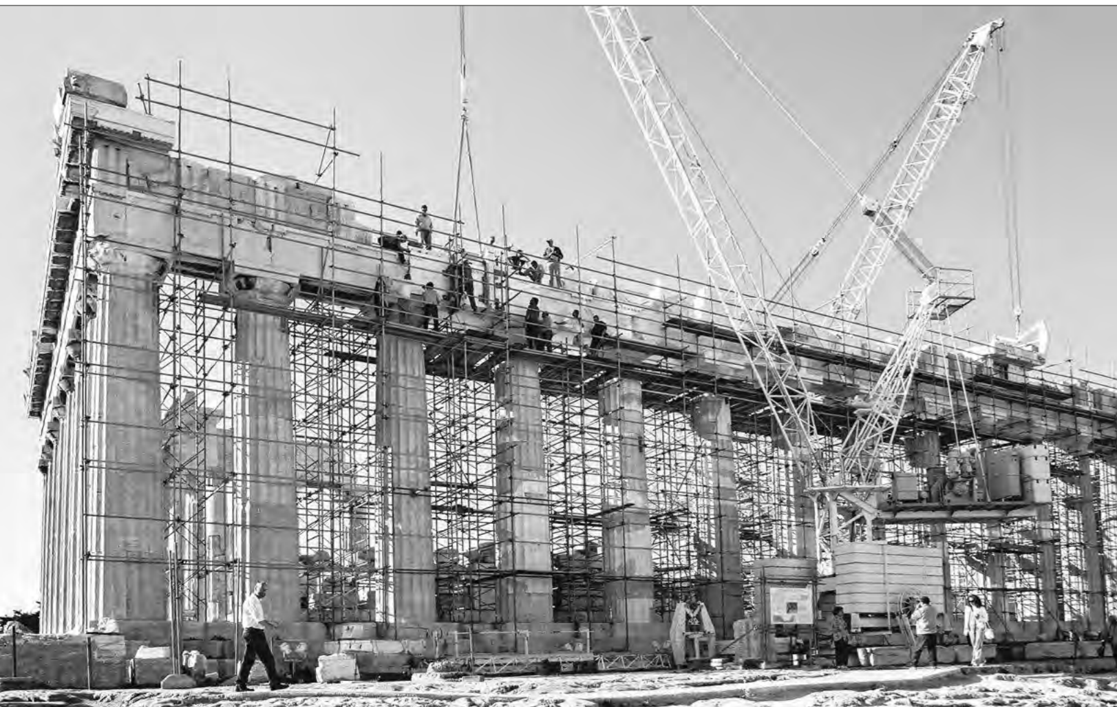
Παρθενώνας. Τοποθέτηση εξωτερικού επιστυλίου του βόρειου πτερού στην οριστική του θέση (2009)
