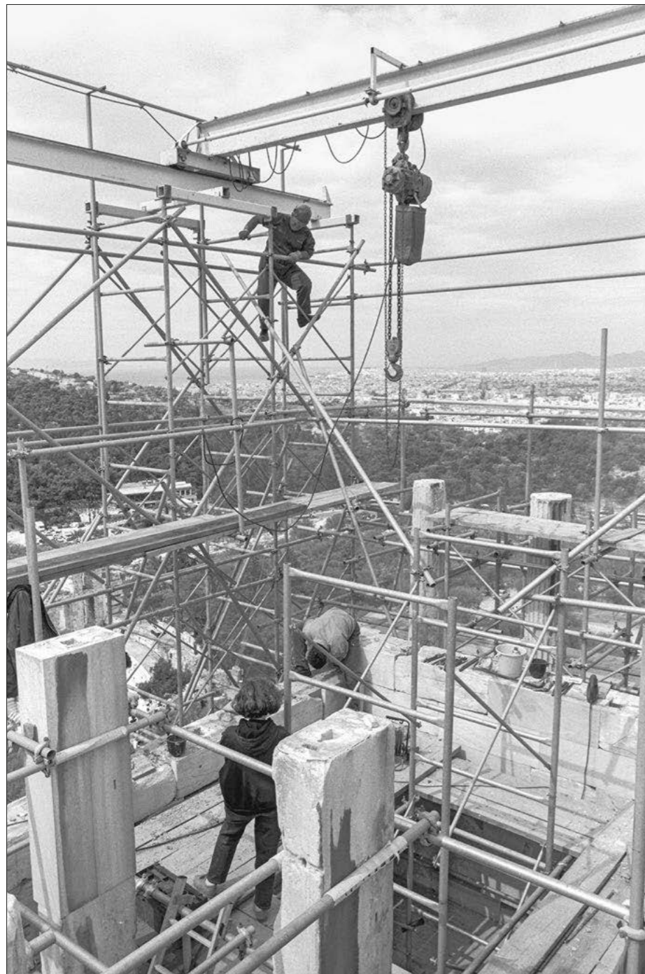
Ναός Αθηνάς Νίκης. Κατά τις εργασίες αποξήλωσης του νότιου τοίχου του σηκού (2001)
