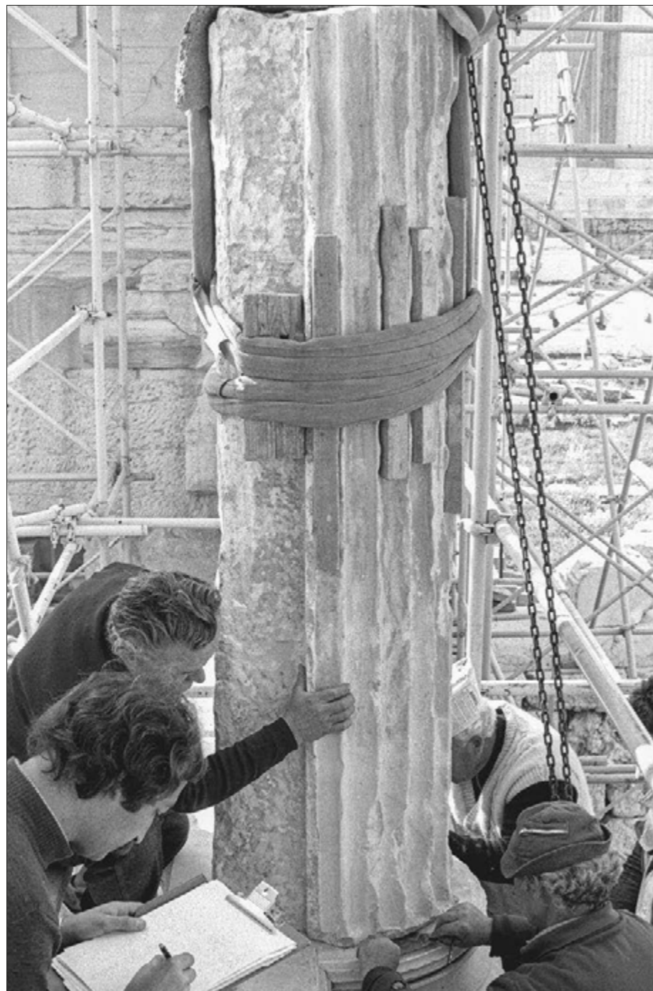
Ερέχθειο. Ανατοποθέτηση ημικίονα του δυτικού τοίχου (1983)
