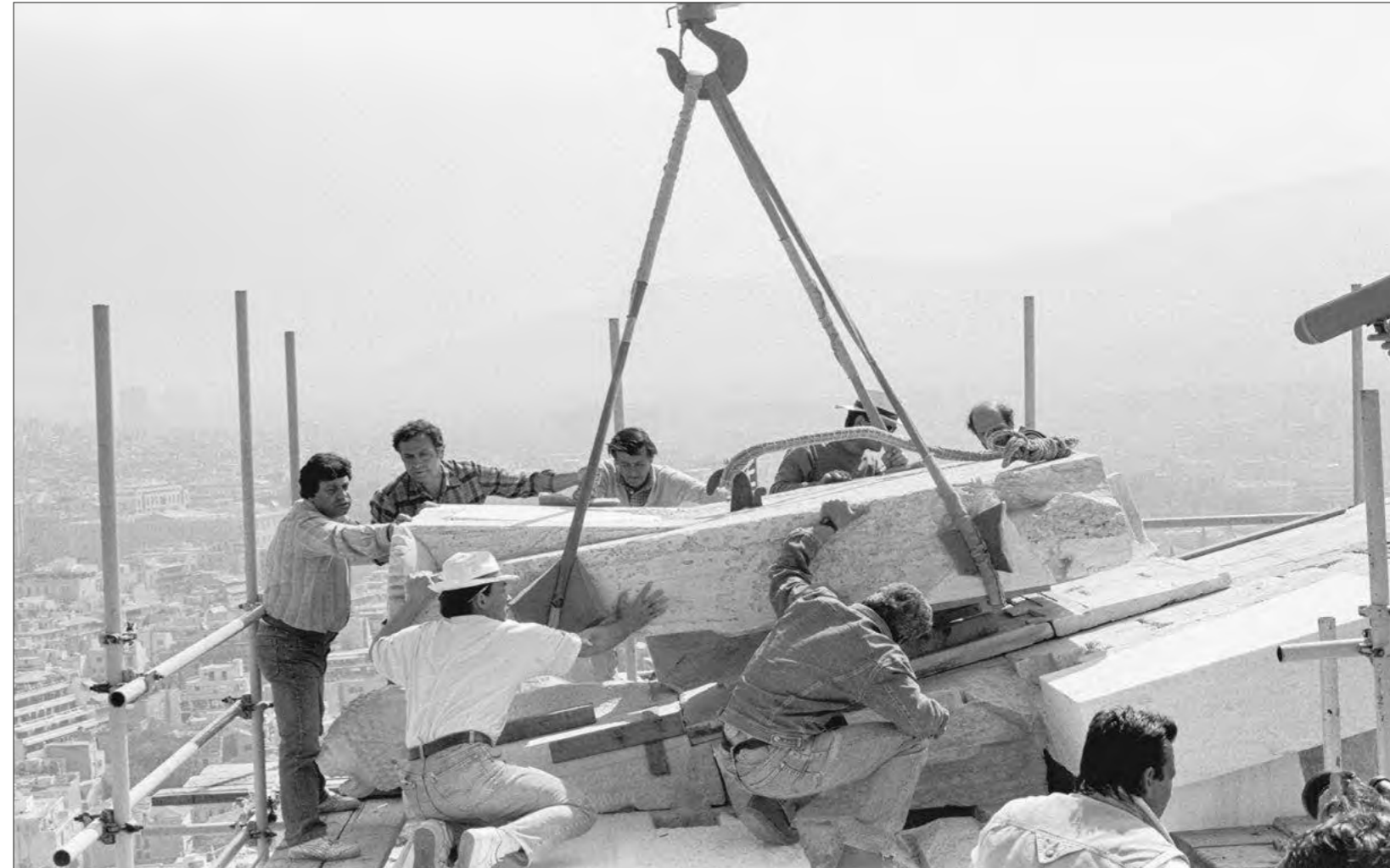
Παρθενώνας. Ανατοποθέτηση του βορειοανατολικού βάθρου ακρωτηρίου στην οριστική του θέση (1991)
