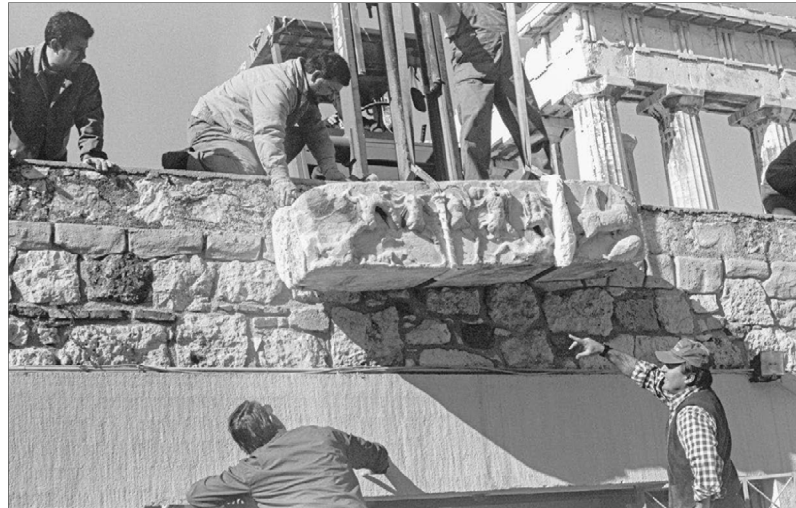
Ναός Αθηνάς Νίκης. Μεταφορά λίθου της ιωνικής ζωφόρου στο Μουσείο Ακροπόλεως, κατά τις εργασίες αποξήλωσης του γλυπτικού διακόσμου του μνημείου, για λόγους προστασίας (1998)
