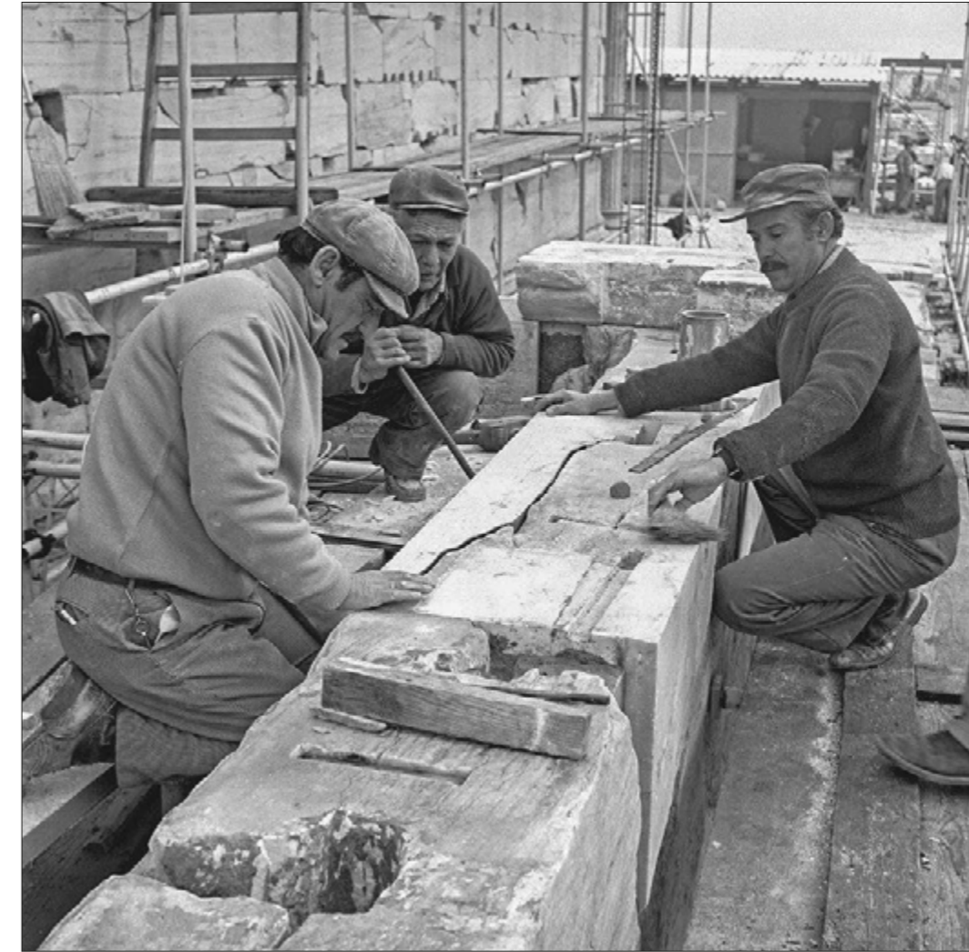
Ερέχθειο. Δοκιμαστική τοποθέτηση συμπληρώματος σε λίθο του ορθοστάτη της νότιας πρόστασης (1980)
