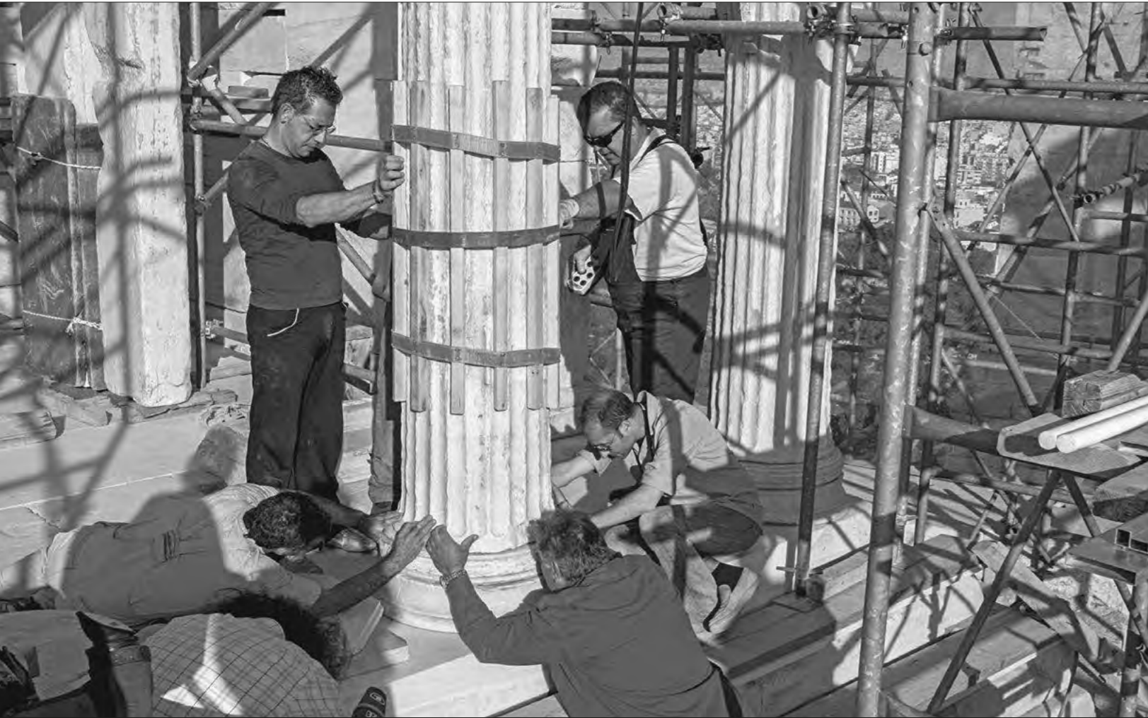
Ναός Αθηνάς Νίκης. Τοποθέτηση κορμού κίονα της ανατολικής πρόστασης στην οριστική του θέση (2008) The Temple of Athena Nike. Placing a column shaft of the east porch to its final position (2008)
