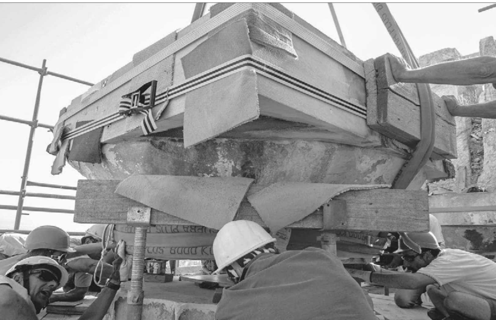
Παρθενώνας. Απουναρμολόγηση του βορειοδυτικού κιονοκράνου (2012)
