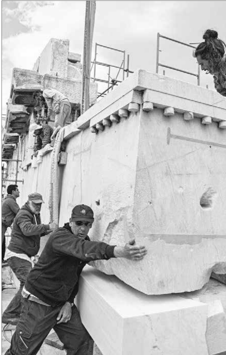
Παρθενώνας. Τοποθέτηση του νοτιοδυτικού εξωτερικού επιστυλίου στην οριστική του θέση (2014)
