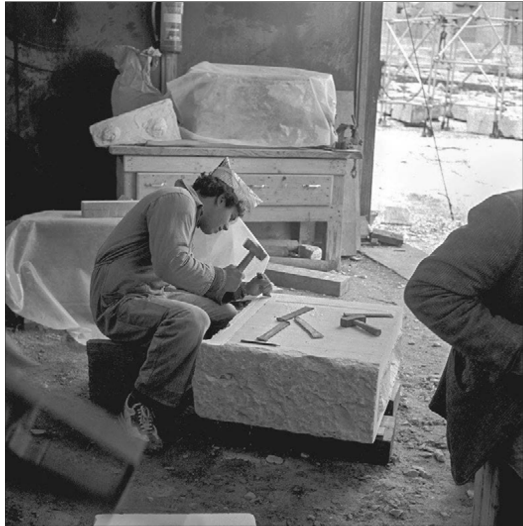
Ερέχθειο. Διαμόρφωση νέου μέλους της επίστεψης του βάθρου της πρόστασης των Κορών (1980)
