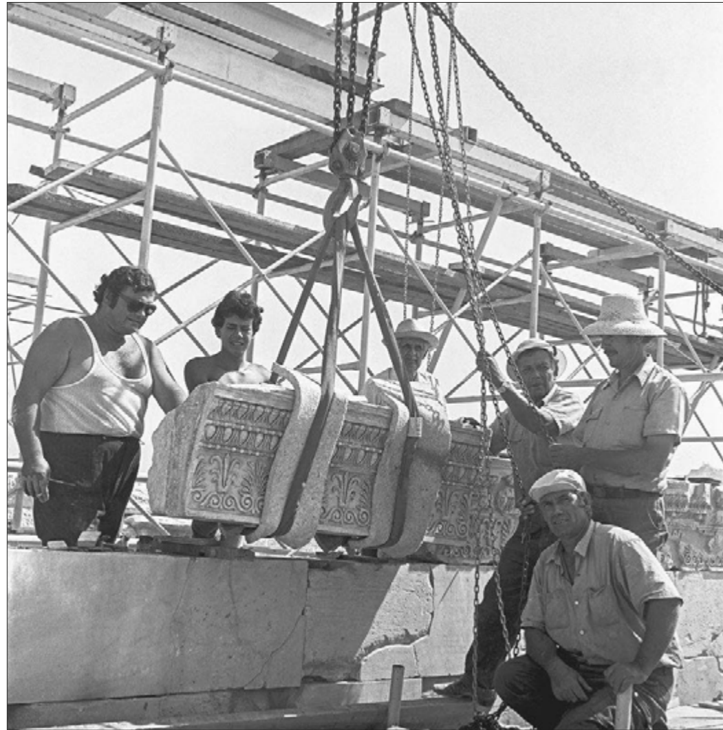
Ερέχθειο. Μαρμαροτεχνίτες του συνεργείου κατά την αποξήλωση λίθου της επικρανίτιδας του νότιου τοίχου (1979)
